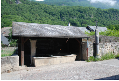
Vue de la croix près du bassin. Phot. Caroline Guibaud IVR84_20247300481NUCA
