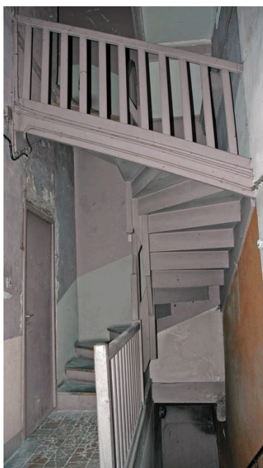
Escalier en bois desservant l'immeuble mitoyen situé au nord Phot. Maryannick Chalabi IVR82_20066901366NUCA
