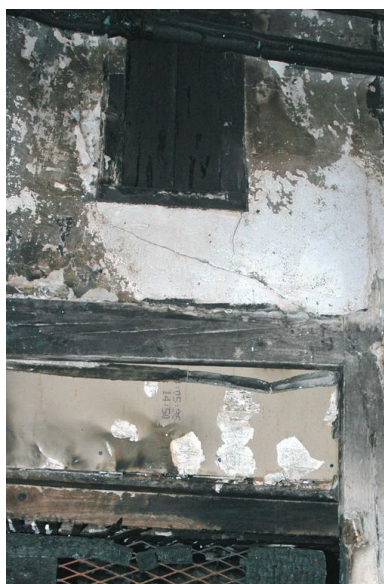
Lucarne au dessus de la porte donnant accès à la sous-pente Phot. Maryannick Chalabi IVR82_20066901258NUCA
