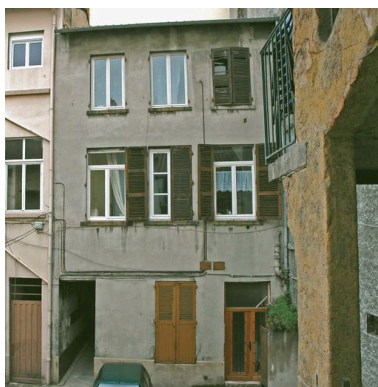
Façade ouest sur cour, vue depuis la cage d'escalier de l'immeuble sur rue Phot. Maryannick Chalabi IVR82_20066901365NUCA
