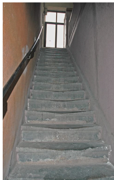
Volée droite permettant d'accéder au premier étage vue depuis l'est Phot. Maryannick Chalabi IVR82_20066901364NUCA
