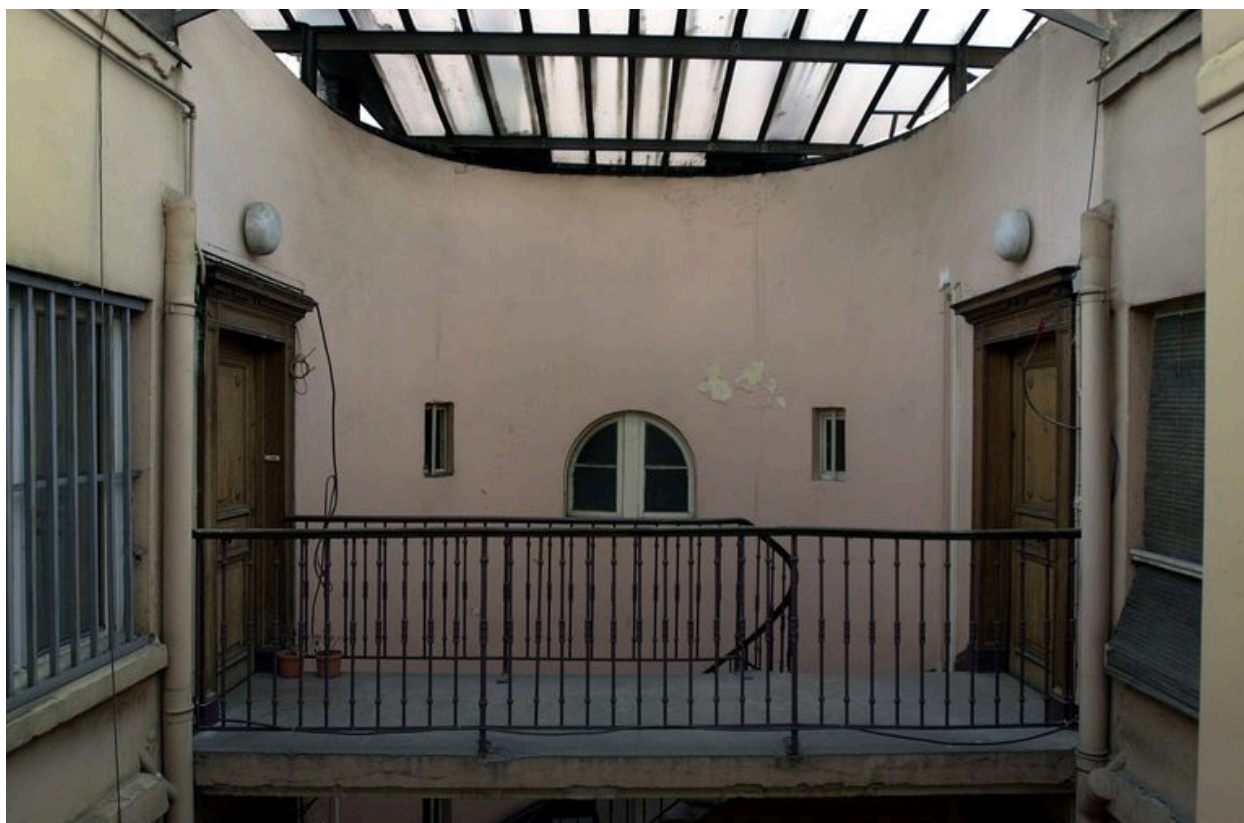
Escalier sud : palier du dernier étage
