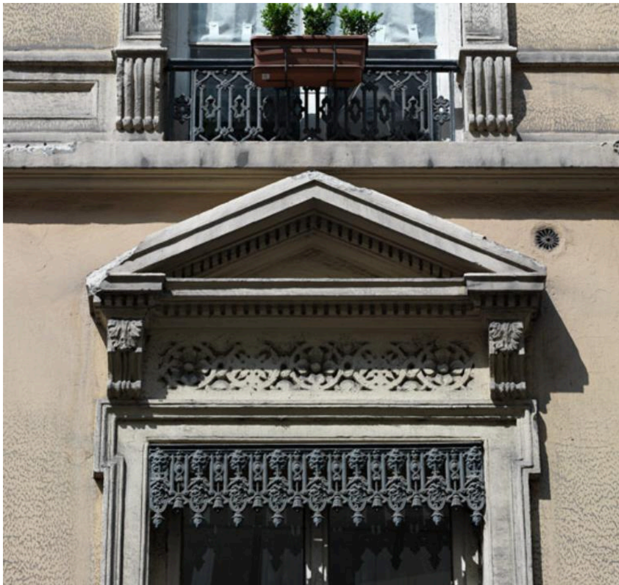
Elévation antérieure : fenêtre ornée d'un fronton
