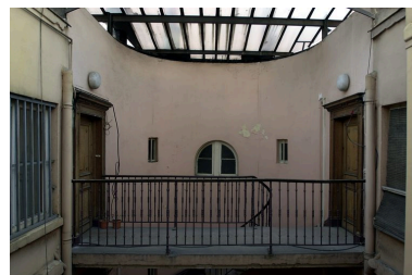
Escalier sud : palier du dernier étage Phot. Véronique Belle IVR82_20076901290NUCA
