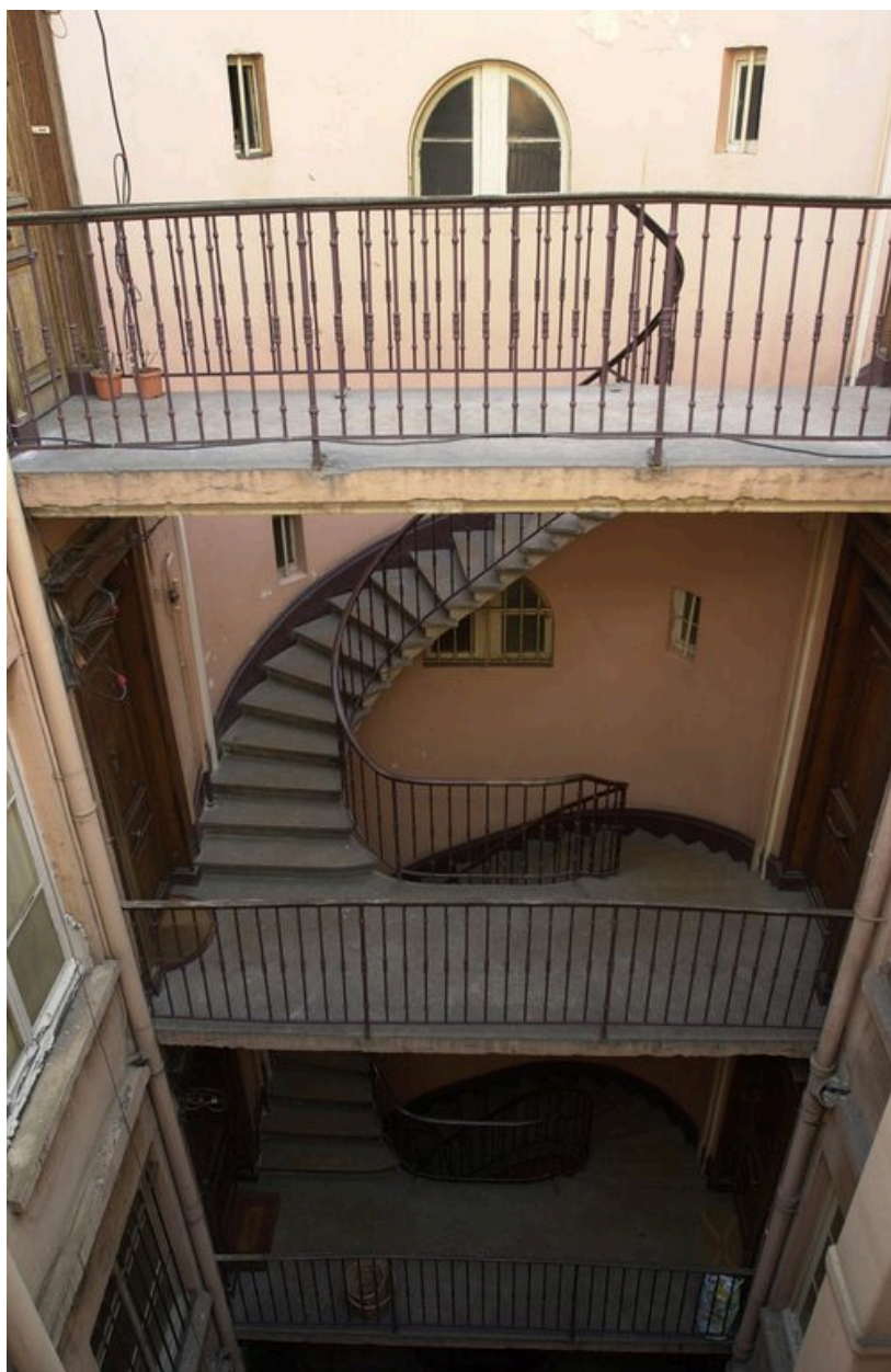
L'escalier sud : dernières volées
