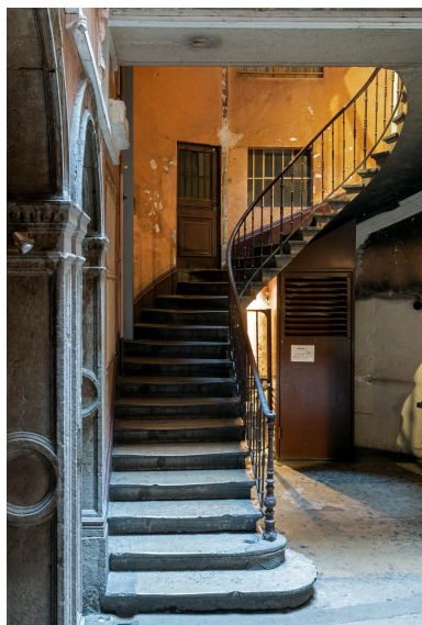
L'escalier sud : première volée et baies de la loge de concierge Phot. Michel Pérès IVR84_20216901004NUCA
