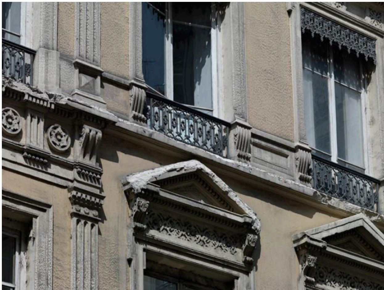
Elévation antérieure, détail
