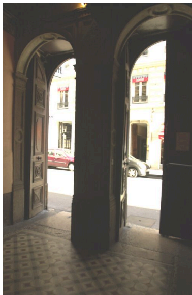
Les entrées jumelles depuis le vestibule Phot. Véronique Belle IVR82_20076901281NUCA
