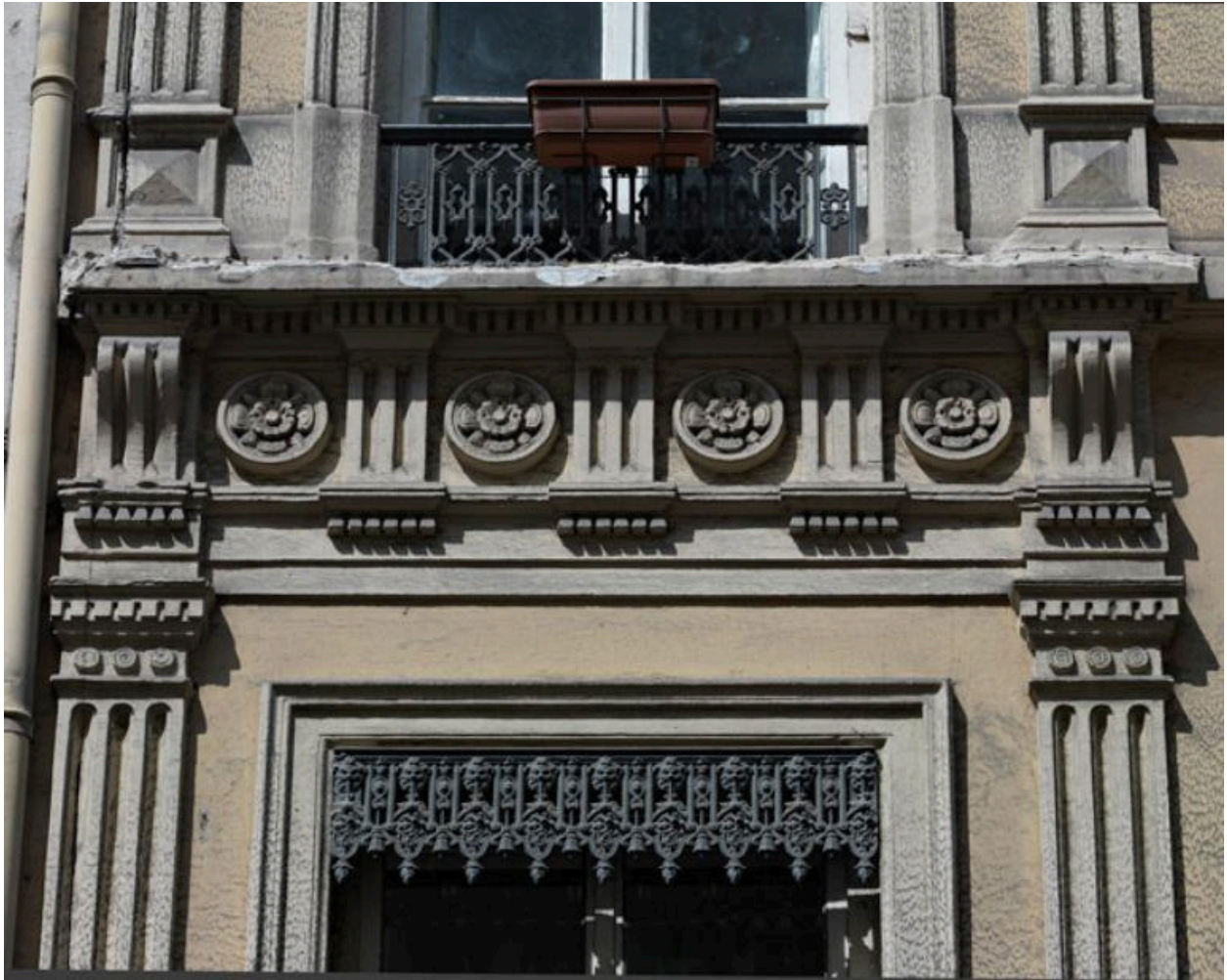
Elévation antérieure : détail de baies, garde-corps, frise et lambrequin
