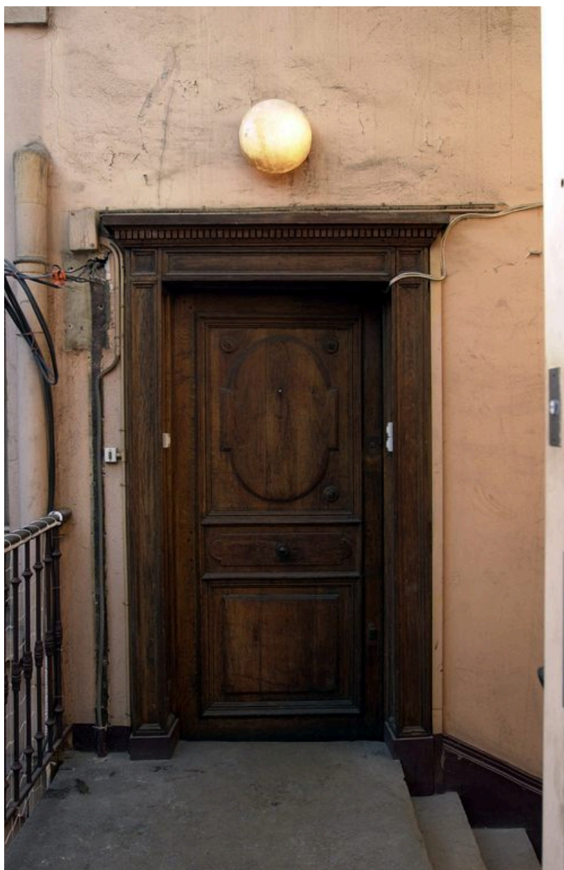
Escalier nord : porte palière du dernier étage
