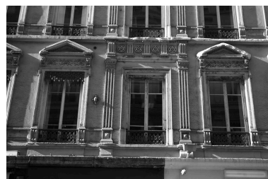
Elévation antérieure : détail de baies axiales Phot. Véronique Belle IVR82_20076901280NUCA
