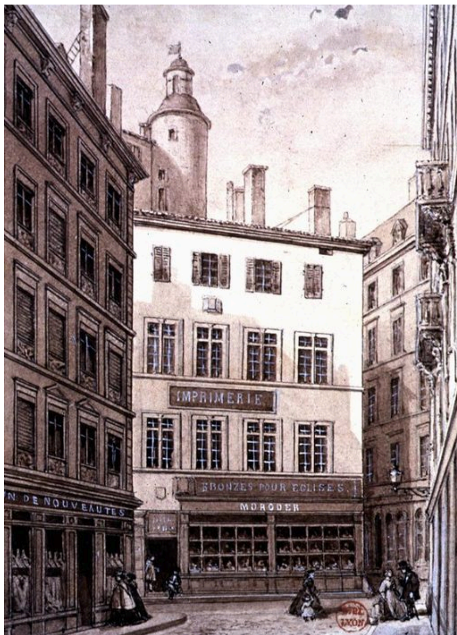
A gauche de l'image, vue partielle de l'élévation sur la rue Ferrandière
