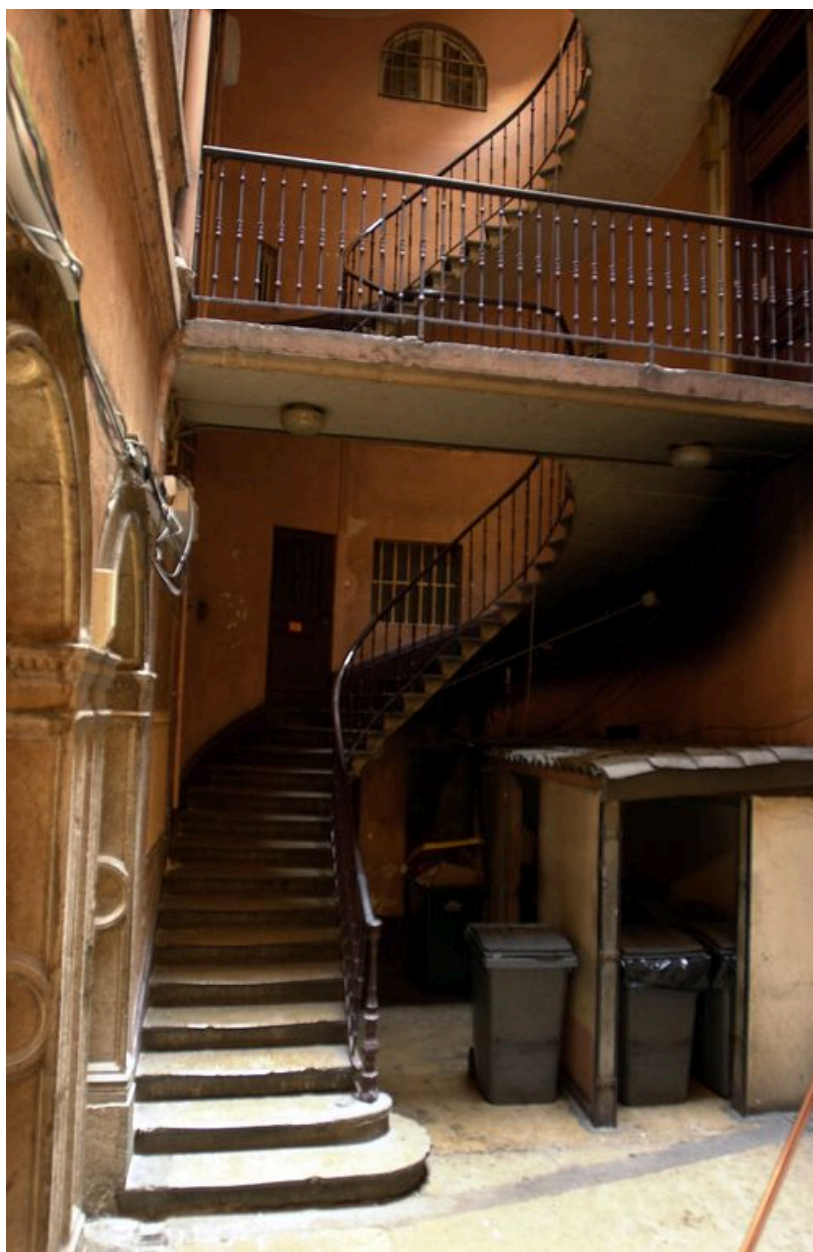
L'escalier sud : première et deuxième volées, premier palier
