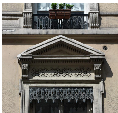
Elévation antérieure : fenêtre ornée d'un fronton Phot. Eric Dessert IVR82_20126901477NUCA
