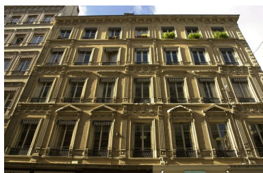
Elévation antérieure : les étages carrés Phot. Véronique Belle IVR82_20076901278NUCA
