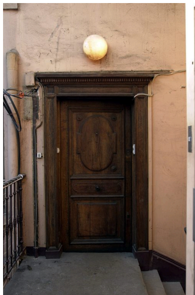
Escalier nord : porte palière du dernier étage Phot. Véronique Belle IVR82_20076901291NUCA
