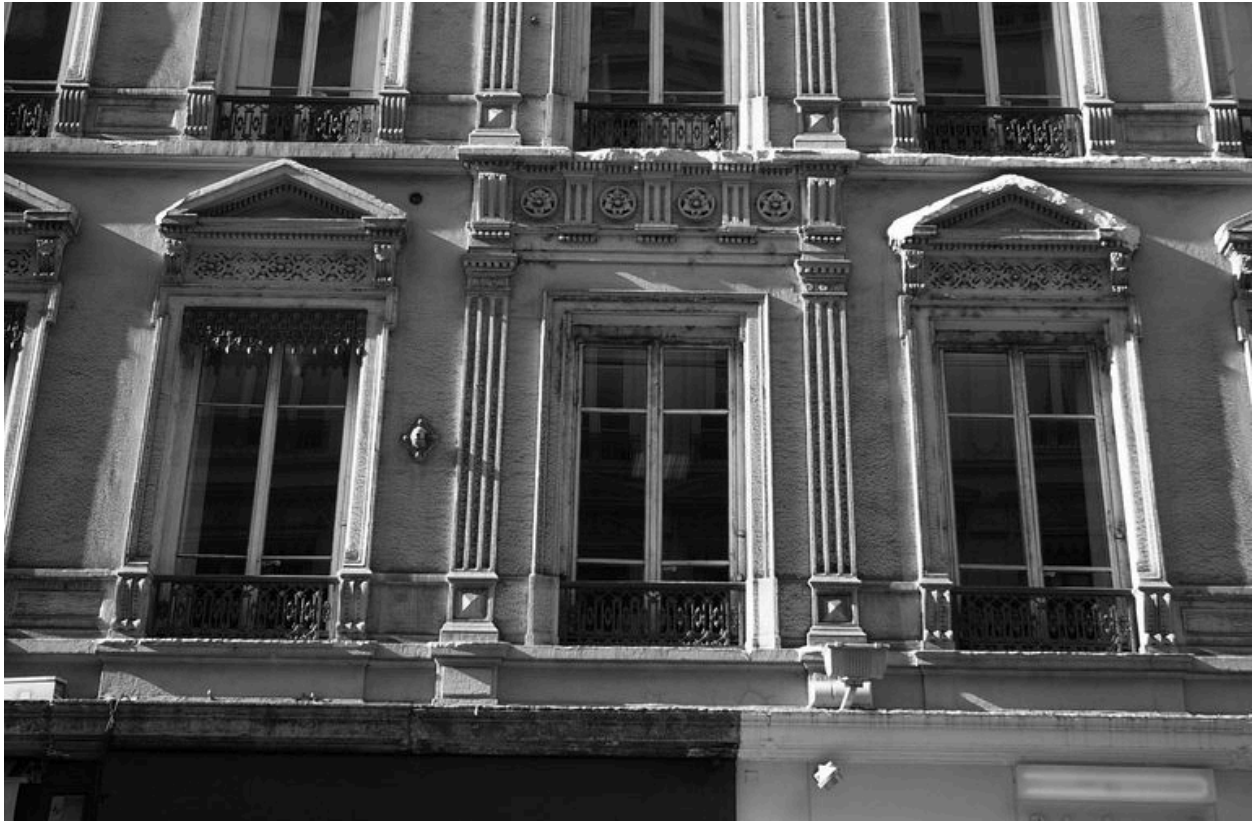
Élévation antérieure : détail de baies axiales
