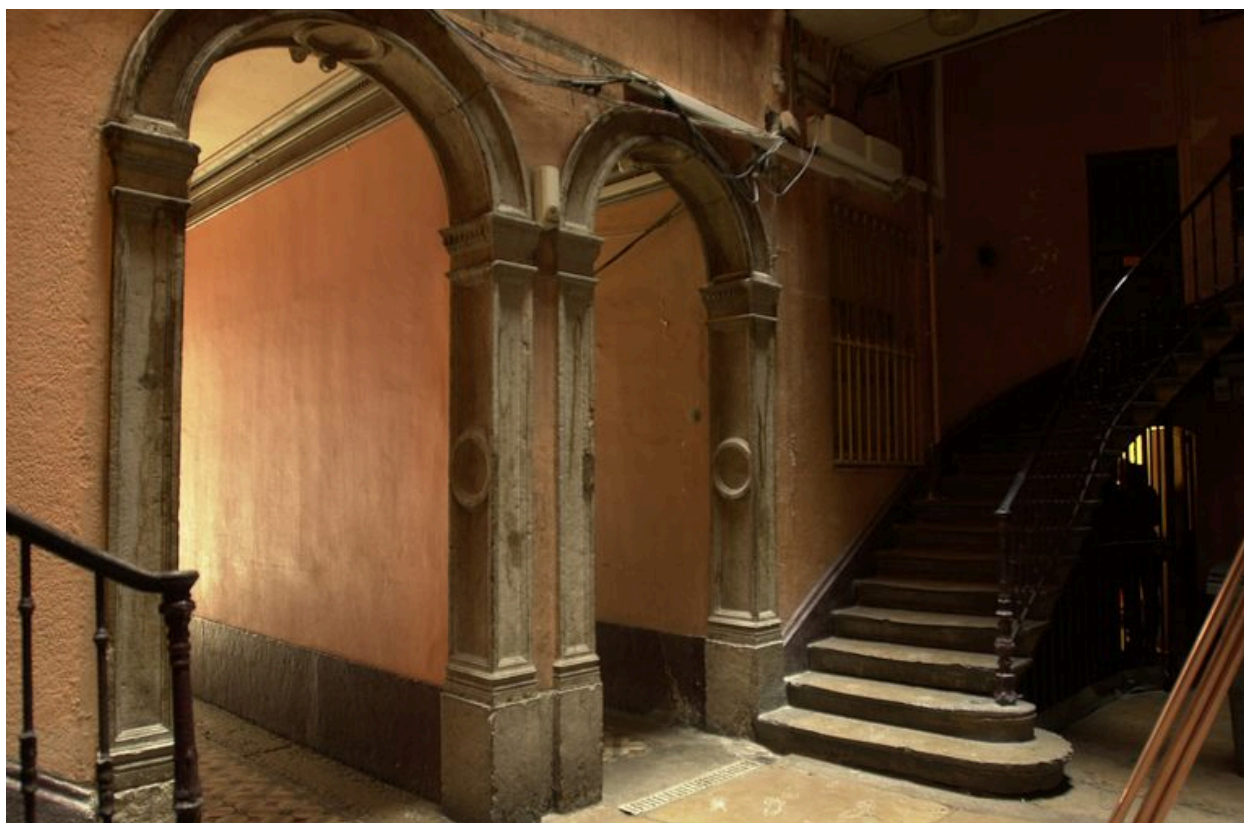
Les allées jumelées et le départ de l'escalier sud
