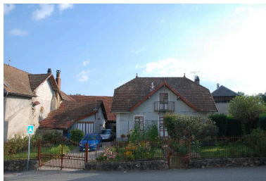
Vue d'ensemble. Phot. Caroline Guibaud IVR84_20177301328NUCA
