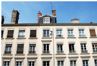
Détail des étages supérieurs depuis la grenette, sise 21 rue de Brest Phot. Véronique Belle IVR82_20096902288NUCA
