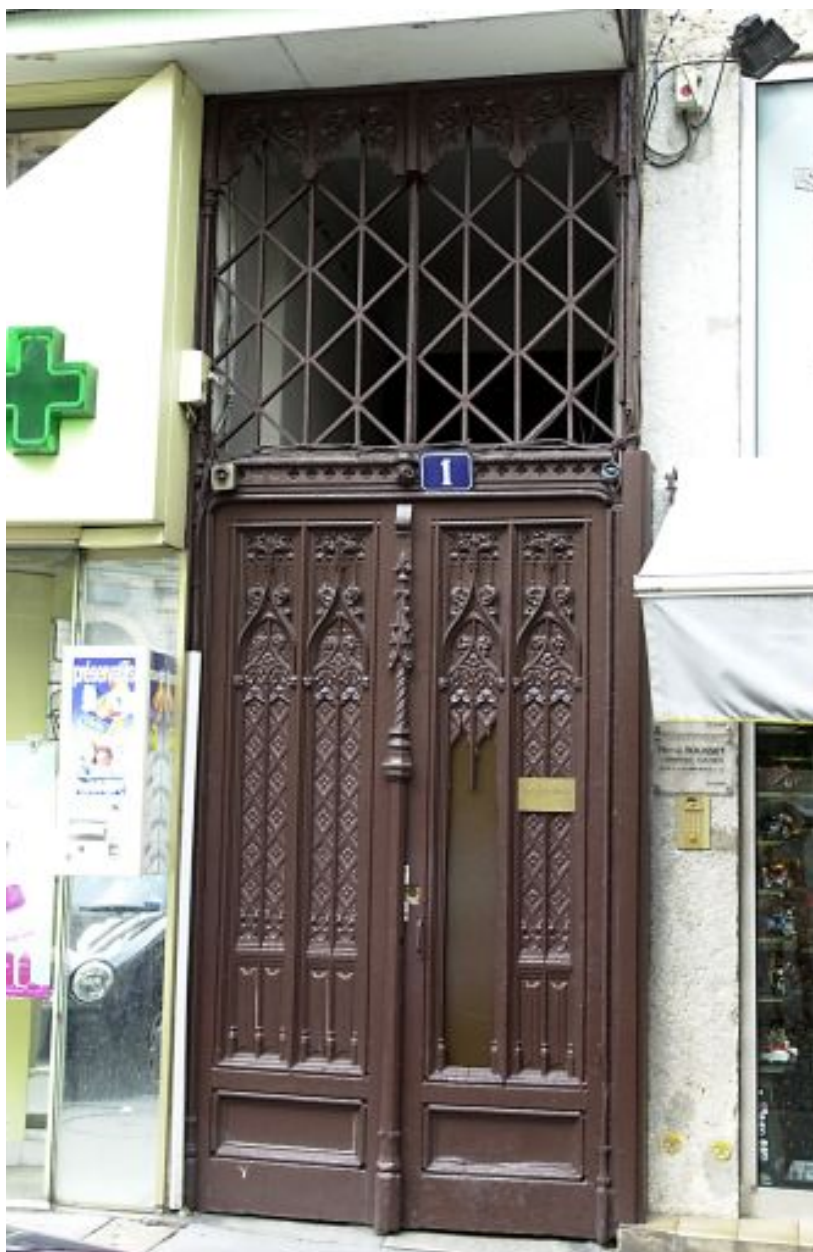
Façade place Saint-Nizier, détail de la porte
