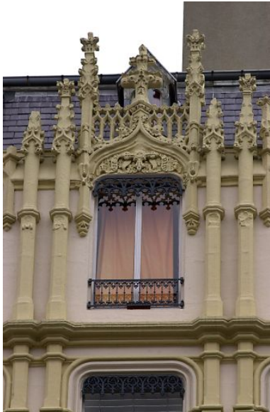
Façade principale sur la rue Chavanne, détail de la baie axiale du dernier étage Phot. Lore Derail IVR82_20046900099NUCA
