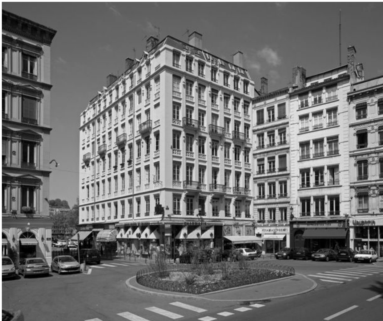
Vue générale des façades sur la rue des Bouquetiers et sur la place Saint-Nizier
