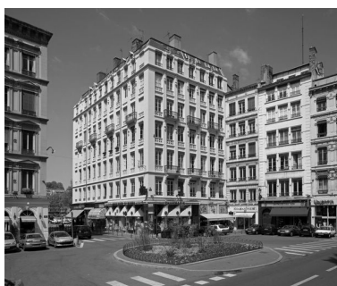
Vue générale des façades sur la rue des Bouquetiers et sur la place Saint-Nizier Phot. Eric Dessert IVR82_20056901709NUC
