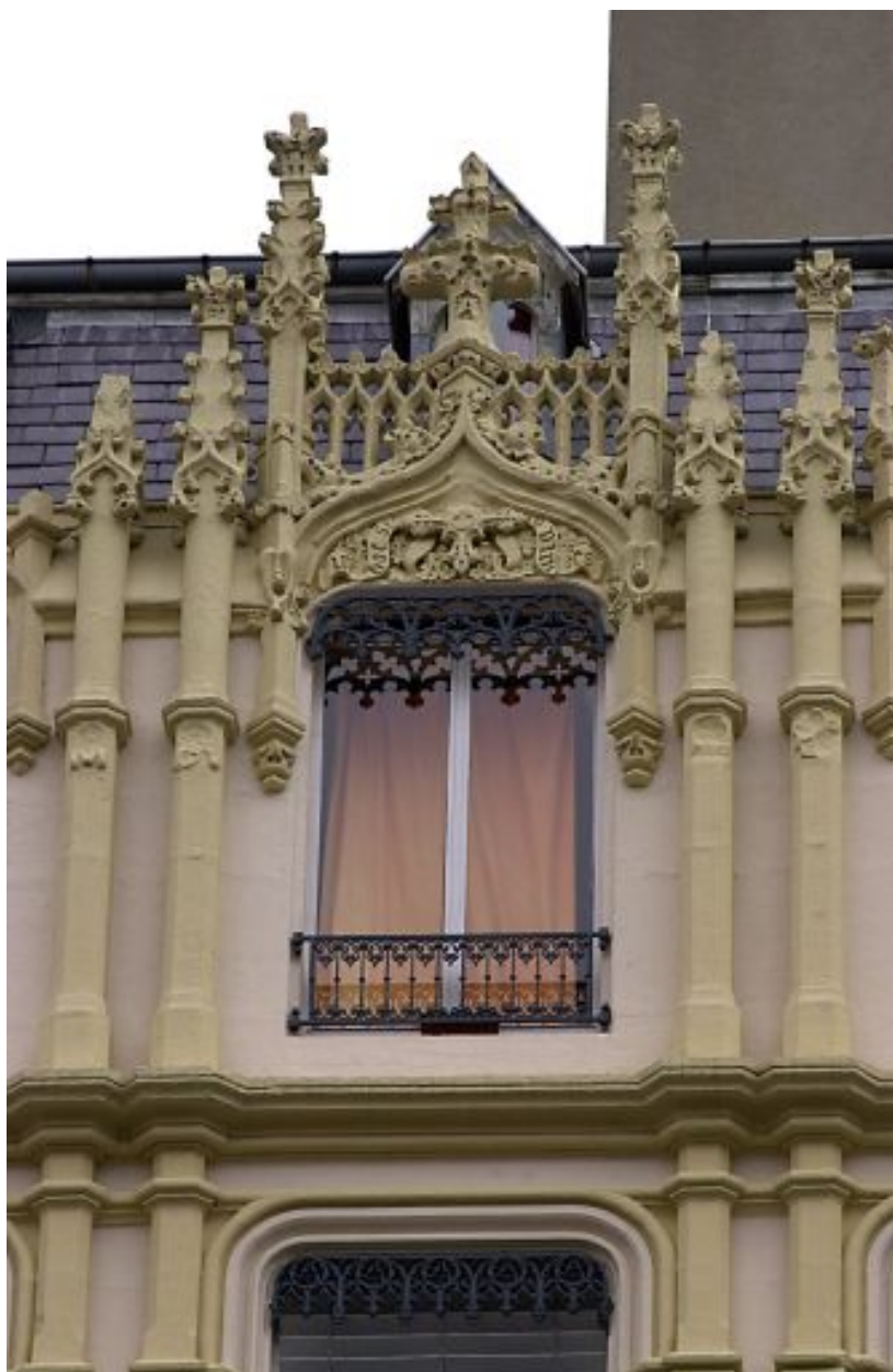
Façade principale sur la rue Chavanne, détail de la baie axiale du dernier étage
