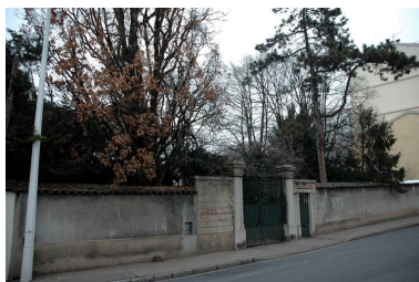
Le mur de clôture Phot. Véronique Belle IVR82_20066900821NUCA
