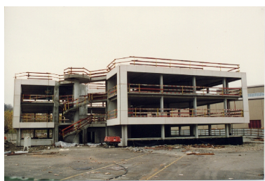
Chantier de construction Repro. François Fouger IVR82_20087300703NUCB
