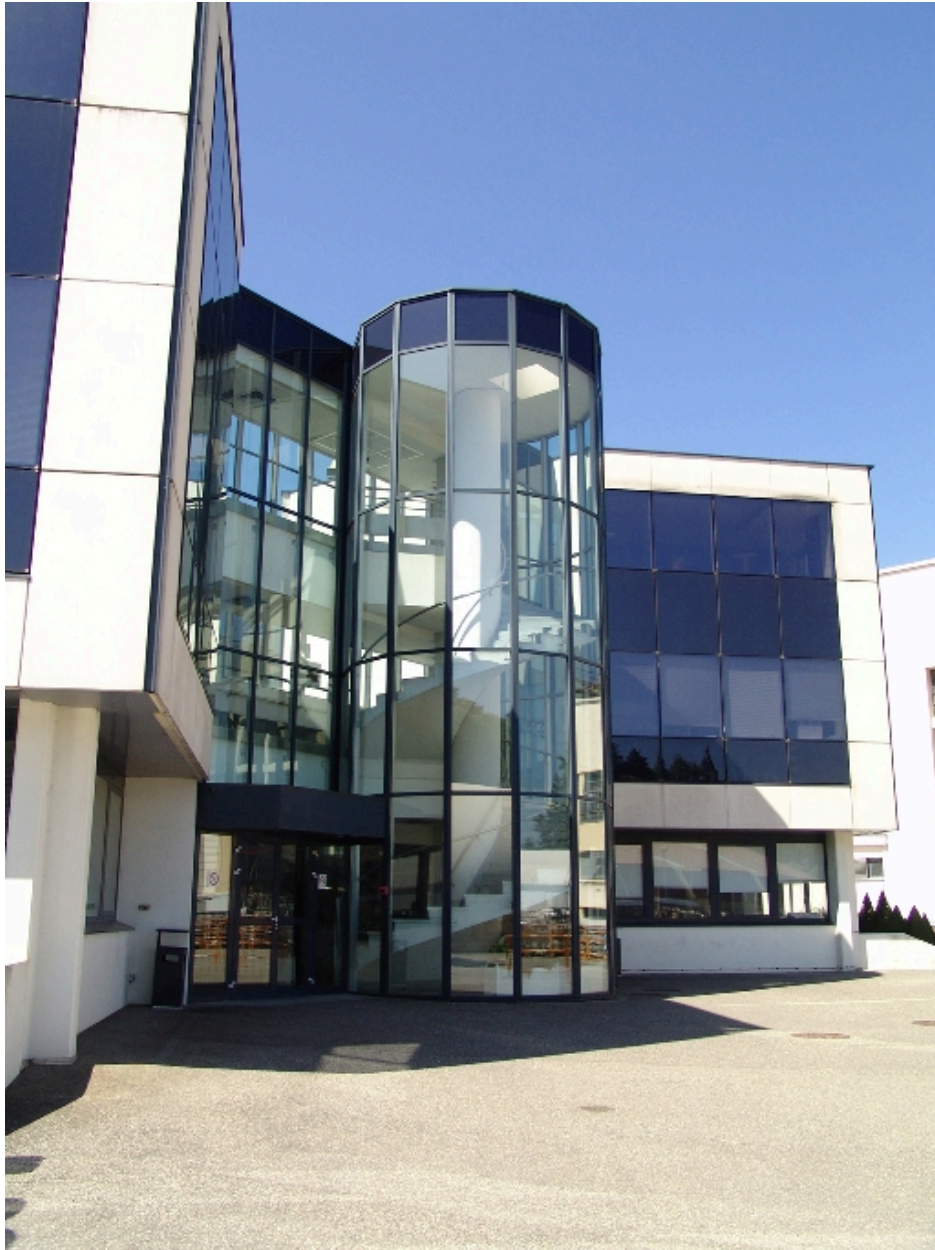
Entrée et escalier en vis
