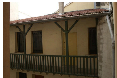
Vue de la coursière desservant le corps de bâtiment sur cour Phot. Maryannick Chalabi IVR82_20046904612NUCA
