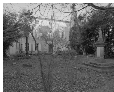
Montbrison-sur-Lez, Les Plans (C1 63). Façade sur jardin de la maison de maître. Phot. Alain Franchella IVR82_19982600997X
