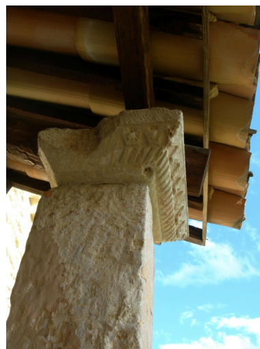
La Rivière, ou Odoir ( A4 597). Détail du pilier à chapiteau sculpté supportant le toit de la galerie ; le chapiteau (médiéval ?) est peut-être un remploi provenant du prieuré tout proche. Phot. Annie Tosi-Remy IVR82_20062600075NUCA
