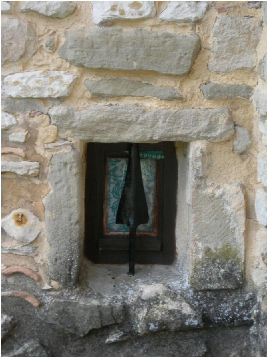
La Rivière, ou Odoir ( A4 597). Détail de l'élévation latérale droite, au 1er niveau : jour éclairant une dépendance.
