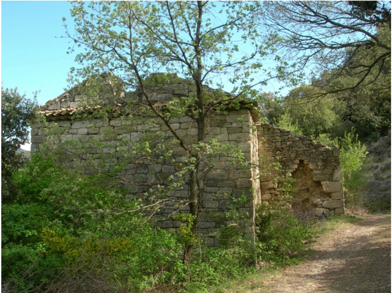
La Viale : ferme en ruines (maison Reboul ?) sur le chemin conduisant à l'ancien village.
