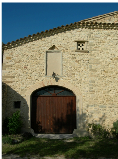
La Rivière, ou Odoir ( A4 597). Dépendance accolée au logis, détail d'élévation. Phot. Annie Tosi-Remy IVR82_20062600074NUCA
