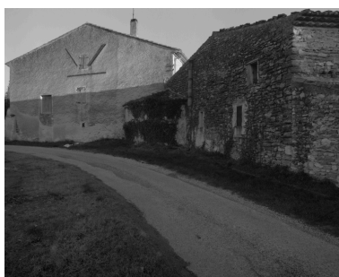
Peyrol (A1 334). Elévations latérale du logis et postérieure des dépendances. Phot. Alain Franchella IVR82_19982601005X
