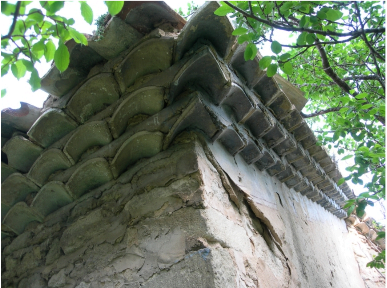
Montbrison-sur-Lez, La Viale : exemple de mise en oeuvre de génoise sur l'angle d'une élévation.
