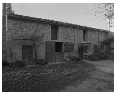
Peyrol (A1 334). Elévation sur cour de l'atelier et dépendances de la ferme. Phot. Alain Franchella IVR82_19982601006X
