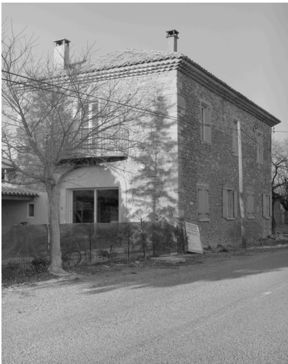
Beloure (parcelle C2 389). Corps de logis, vue de trois quarts depuis la route.
