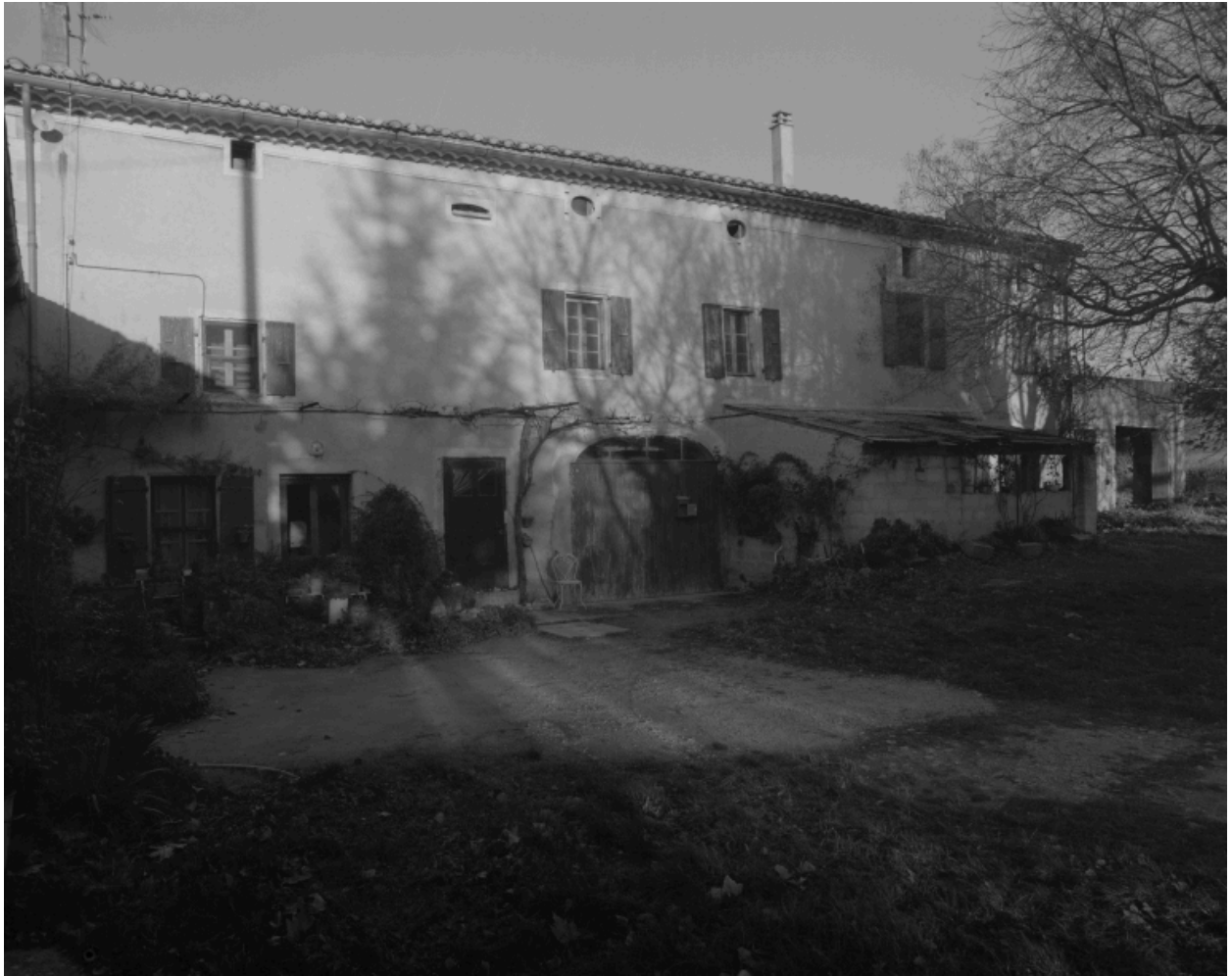
Peyrol (A1 334). Elévation principale du logis, avec la forge.
