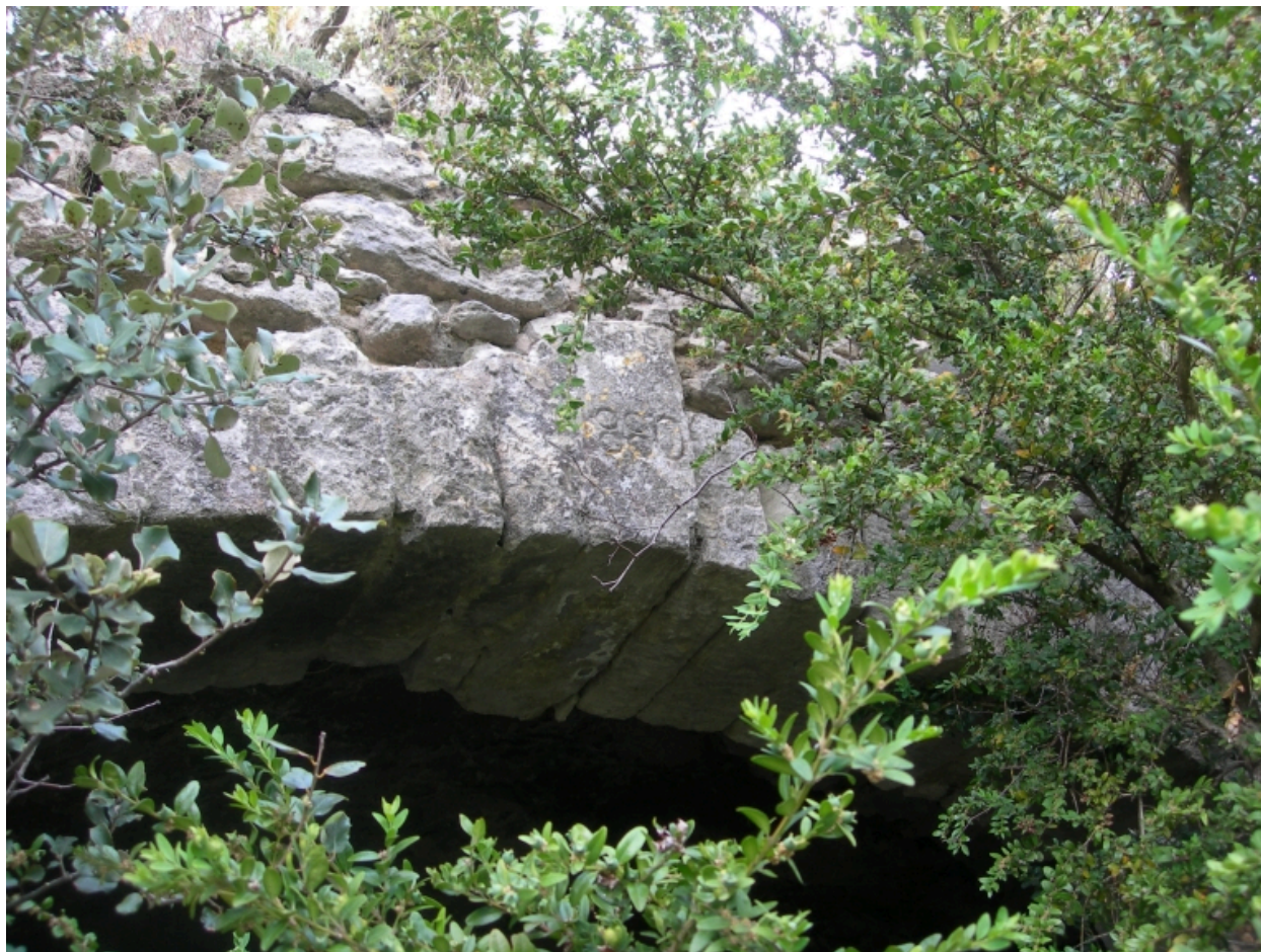
La Viale (section A2) : dépendance troglodytique portant la date 1881 à la clef de l'arc, près de l'ancien domaine de la Viale, en bordure du chemin.
