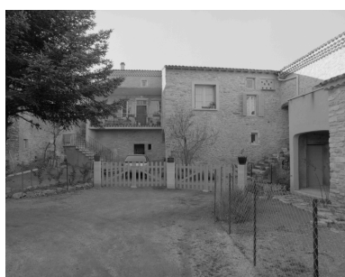
Montbrison-sur-Lez, Beloure (C2 367). Vue du corps de logis de l'ancienne ferme (à droite), récemment restauré. Phot. Alain Franchella IVR82_19982601002X
