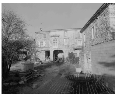
Beloure (C2 389). Vue d'ensemble du bâtiment depuis la cour.
