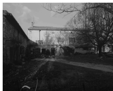
Peyrol (A1 334). Maison de maréchal-ferrant et ferme, vue d'ensemble depuis la cour. Phot. Alain Franchella IVR82_19982601008X
