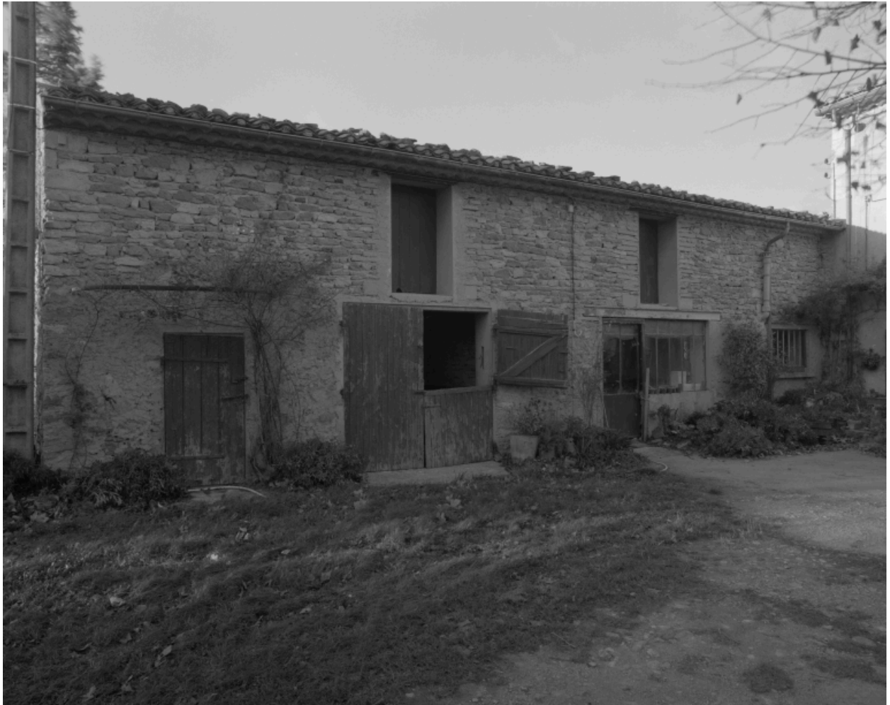
Peyrol (A1 334). Elévation sur cour de l'atelier et dépendances de la ferme.
