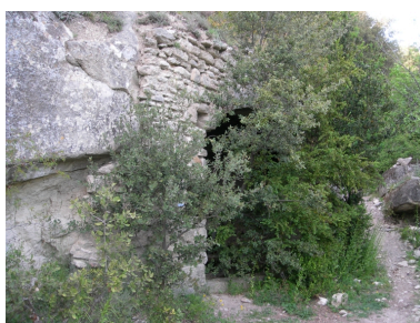
La Viale (section A2) : entrée d'une dépendance troglodytique construite en bordure du chemin, près de l'ancien domaine de la Viale. Phot. Annie Tosi-Remy IVR82_20062600069NUCA
