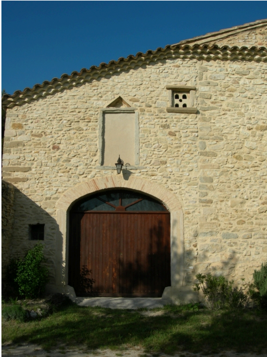
La Rivière, ou Odoir ( A4 597). Dépendance accolée au logis, détail d'élévation.
