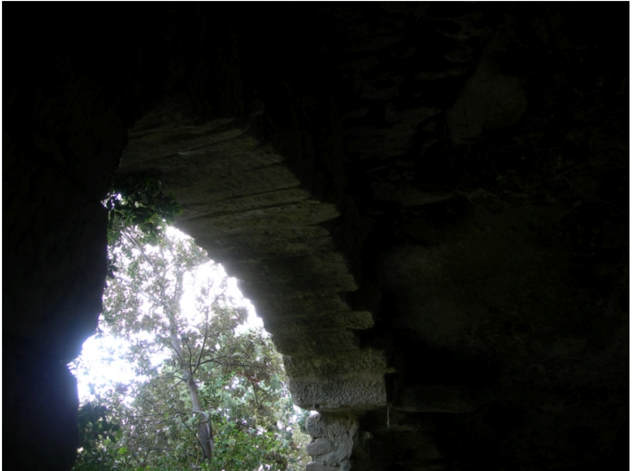
La Viale (section A2) : arc, daté 1881, vu de l'intérieur d'une dépendance troglodytique, près de l'ancien domaine de la Viale.
