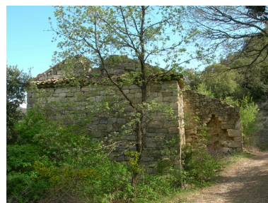
La Viale : ferme en ruines (maison Reboul ?) sur le chemin conduisant à l'ancien village.
