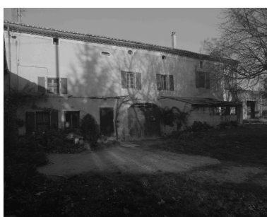
Peyrol (A1 334). Elévation principale du logis, avec la forge. Phot. Alain Franchella IVR82_19982601007X
