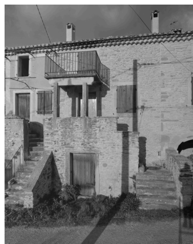
Les Gails (A1 200, 203). Elévations principales de deux logis. Phot. Alain Franchella IVR82_19982601013X
