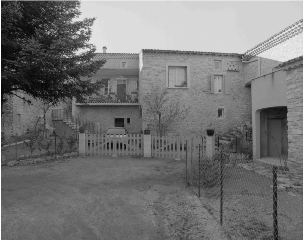
Montbrison-sur-Lez, Beloure (C2 367). Vue du corps de logis de l'ancienne ferme (à droite), récemment restauré.
