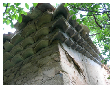
Montbrison-sur-Lez, La Viale : exemple de mise en oeuvre de génoise sur l'angle d'une élévation. Phot. Annie Tosi-Remy IVR82_20062600114NUCA
