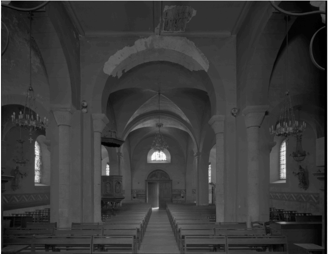
Vue d'ensemble intérieure vers l'entrée.
