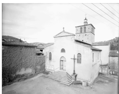
Vue d'ensemble depuis le nord-ouest. Phot. Eric Dessert IVR82_20034200480V
