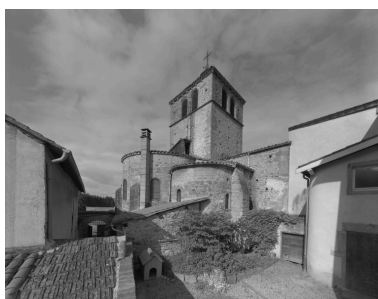
Vue d'ensemble du chevet, clocher et transept, depuis le sud-est. Phot. Eric Dessert IVR82_20034200481V
