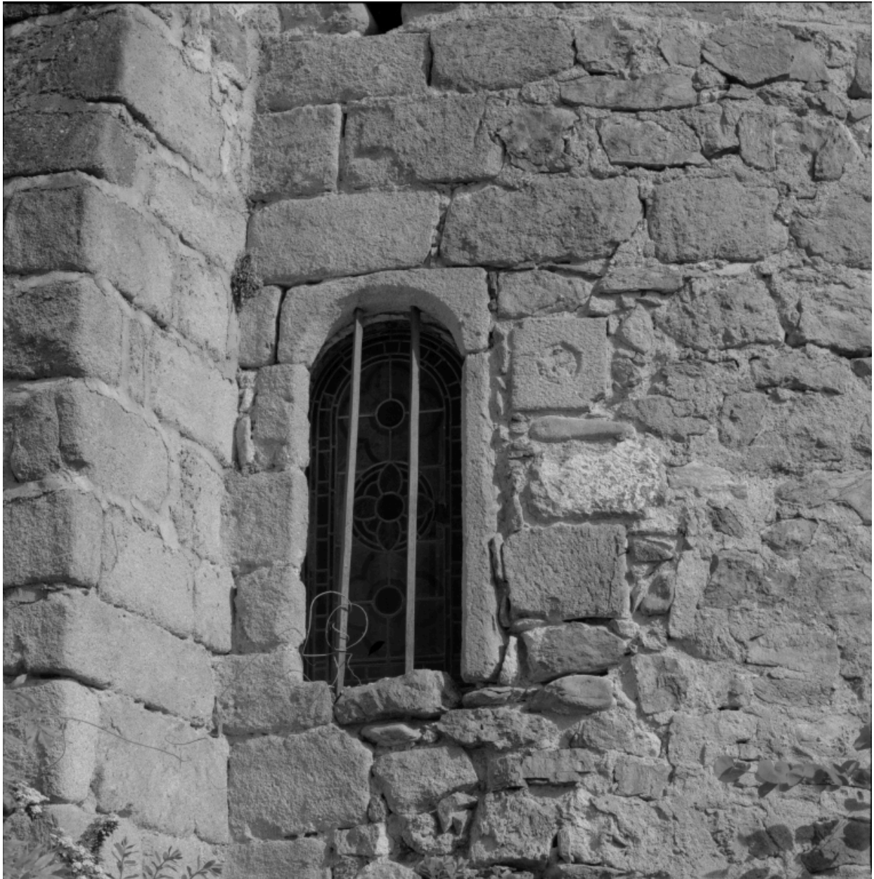
Détail d'une baie à archivolté monolithe sur l'absidiole sud.
