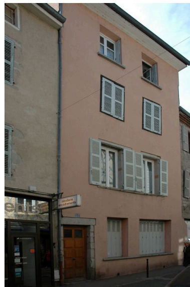
Vue générale. Phot. Simone Hartmann-Nussbaum IVR82_20124202658NUCA
