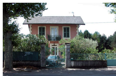
Façade principale Phot. Alice Arnault IVR84_20187301521NUCA
