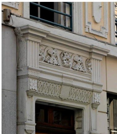
La porte, détail Phot. Eric Dessert IVR82_20126901475NUCA
