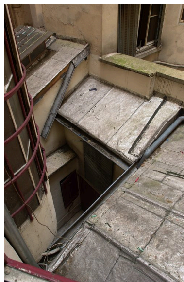
La cour depuis l'escalier Phot. Bernard Ducouret IVR82_20046905229NUCA
