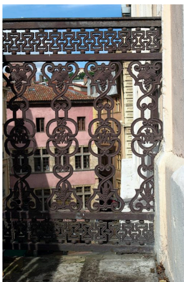
Détail du garde-corps du balcon de l'appartement du 4e étage carré construit pour un ecclésiastique Phot. Bernard Ducouret IVR82_20046905225NUCA
