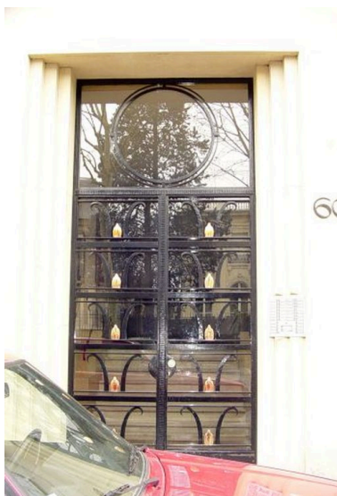
Porte d'entrée 60, boulevard des Belges Phot. Anaïs Beccaria IVR82_20046903314NUCA
