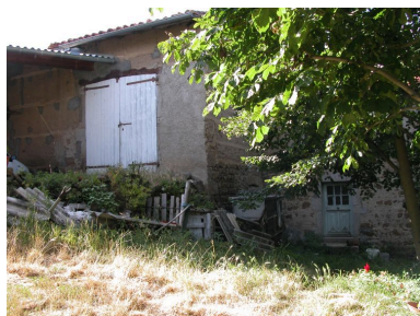
Vue générale Phot. Thierry Monnet IVR82_20124200790NUCA
