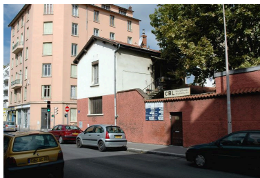
Elévation rue de la Viabert Phot. Véronique Belle IVR82_20076903119NUCA
