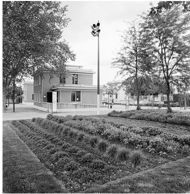
Vue d'ensemble est Phot. Didier Gourbin IVR82_20046902720X
