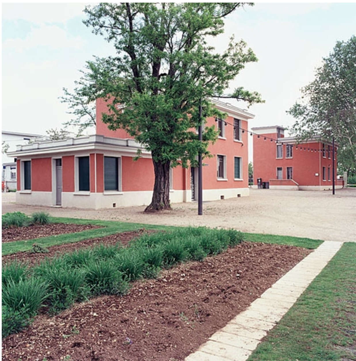
Vue sud des pavillons administratifs
