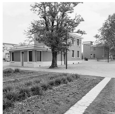
Pavillons administratifs de l'ancienne usine chimique
