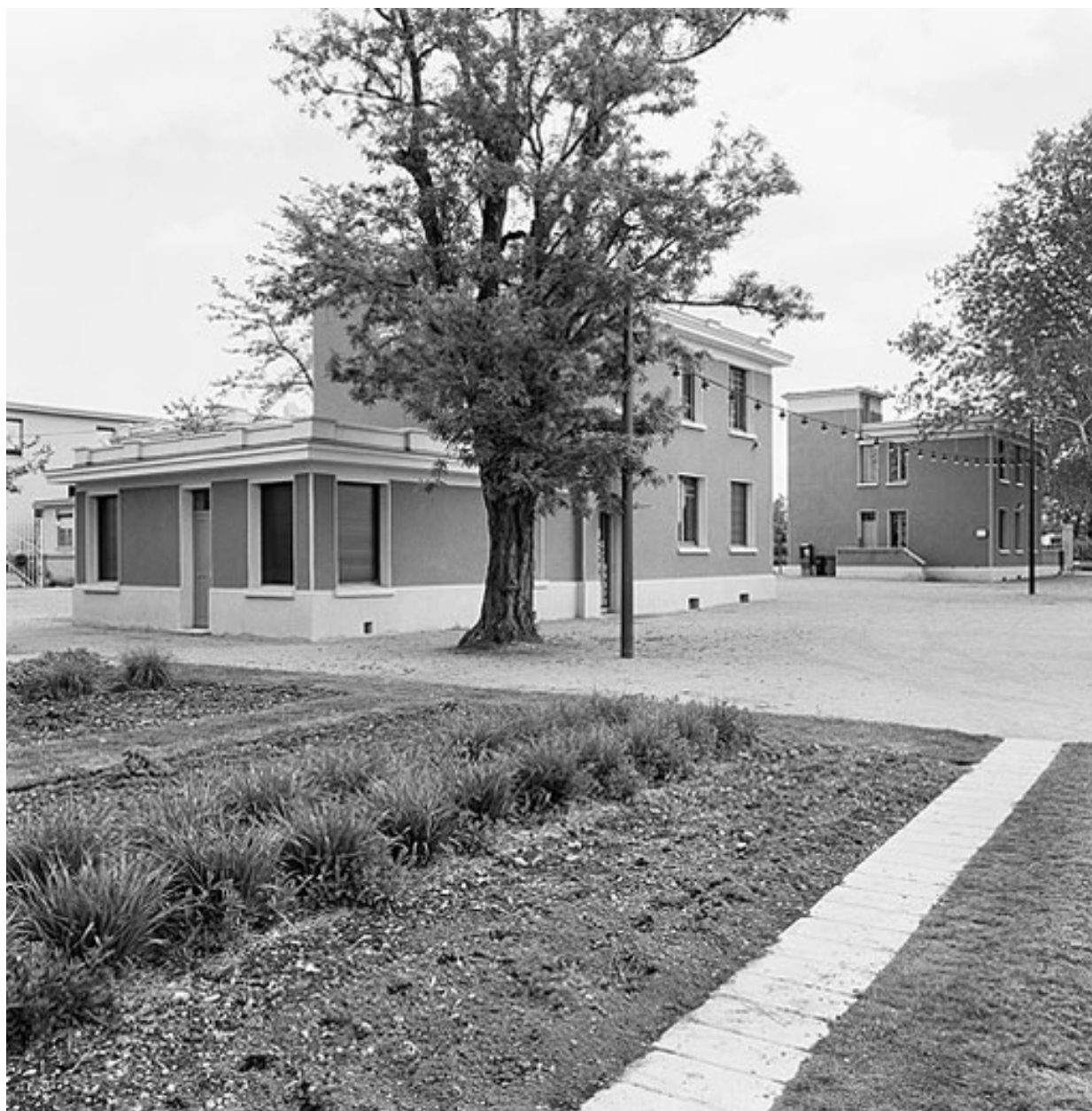
Pavillons administratifs de l'ancienne usine chimique
