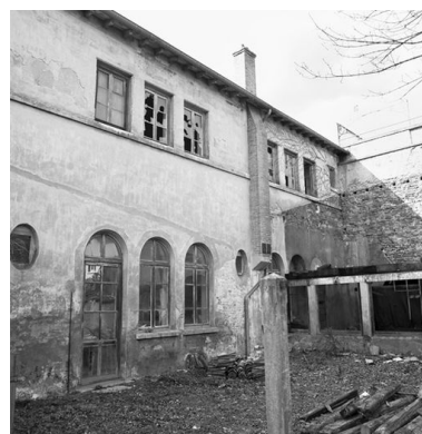
Grand cloître avant les travaux de mars 2002, angle nord-ouest Phot. Jean-Marie Refflé IVR82_20026901913X
