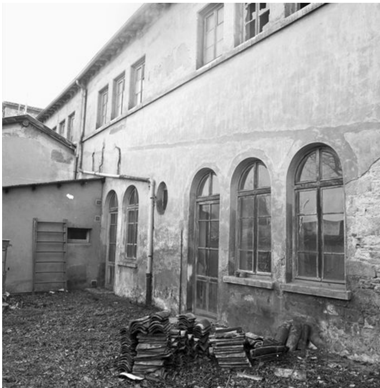
Grand cloître, galerie ouest, partie nord donnant sur une cour avant les travaux de mars 2002, vue en direction du sud
