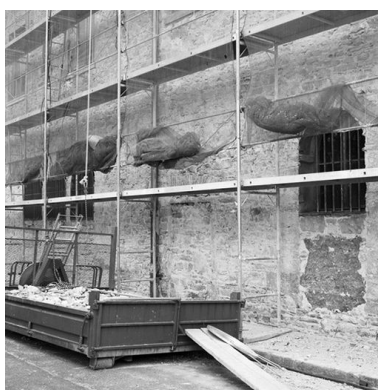
Grand cloître, galerie ouest, partie centrale donnant sur la place des Chartreux durant les travaux de mars 2002, détail de l'ancienne porte axiale Phot. Jean-Marie Refflé IVR82_20026901909X
