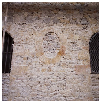
Grand cloître, galerie ouest, partie sud donnant sur la place des Chartreux durant les travaux de mars 2002, détail de l'oculus ovale entre deux travées Phot. Jean-Marie Refflé IVR82_20026901906XA
