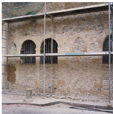
Grand cloître, galerie ouest, partie sud donnant sur la place des Chartreux durant les travaux de mars 2002 Phot. Jean-Marie Refflé IVR82_20026901902XA
