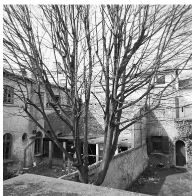
Grand cloître avant les travaux de mars 2002, angle nord-ouest Phot. Jean-Marie Refflé IVR82_20026901914X
