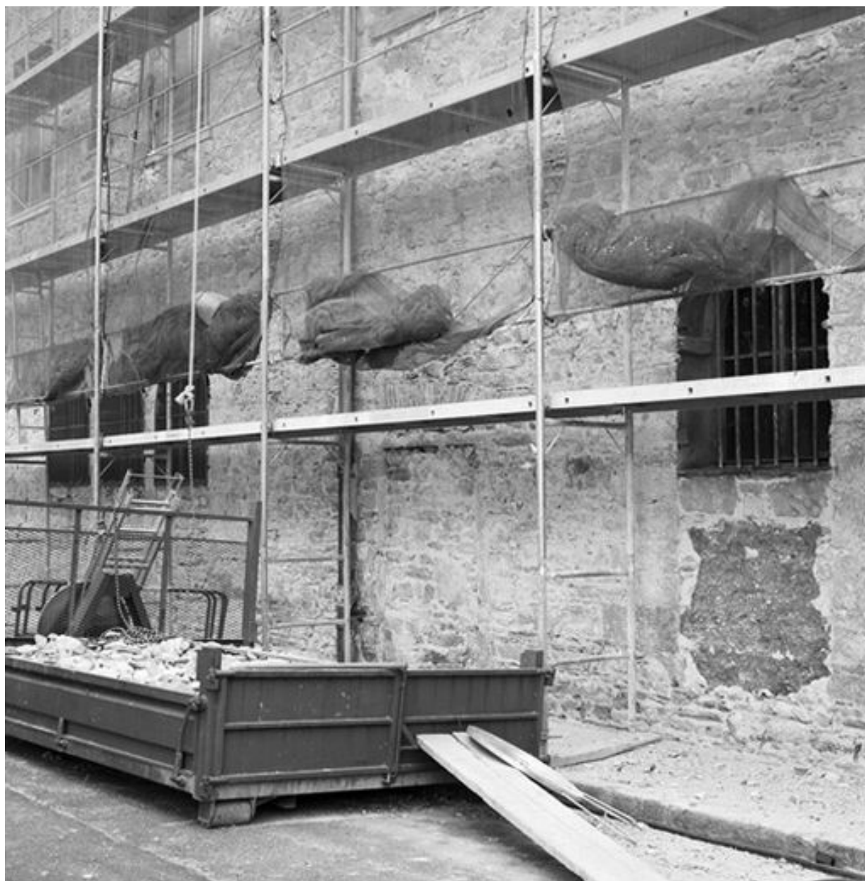
Grand cloître, galerie ouest, partie centrale donnant sur la place des Chartreux durant les travaux de mars 2002, détail de l'ancienne porte axiale
