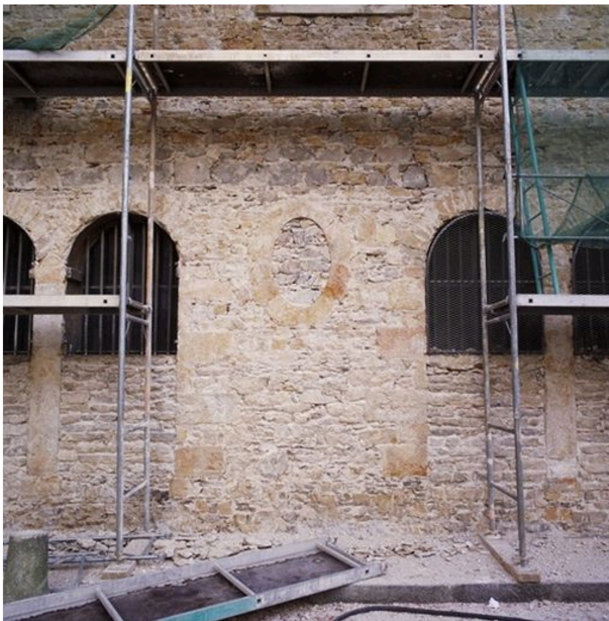
Grand cloître, galerie ouest, partie sud donnant sur la place des Chartreux durant les travaux de mars 2002, séparation entre les deux travées
