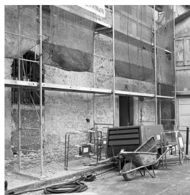
Grand cloître, galerie ouest, partie nord donnant sur la place des Chartreux durant les travaux de mars 2002 Phot. Jean-Marie Refflé IVR82_20026901910X
