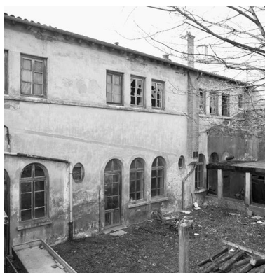
Grand cloître, galerie ouest, partie nord donnant sur une cour avant les travaux de mars 2002, vue en direction du nord Phot. Jean-Marie Refflé IVR82_20026901912X
