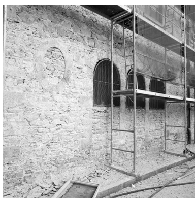
Grand cloître, galerie ouest, partie sud donnant sur la place des Chartreux durant les travaux de mars 2002, détail de la deuxième travée Phot. Jean-Marie Refflé IVR82_20026901908X
