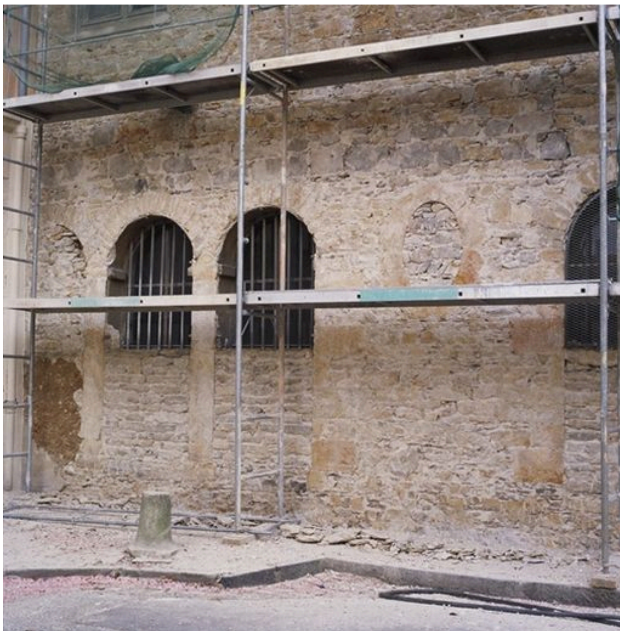
Grand cloître, galerie ouest, partie sud donnant sur la place des Chartreux durant les travaux de mars 2002
