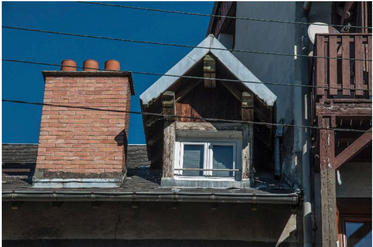
Lucarne à deux pans (jacobine) sur le versant sud
