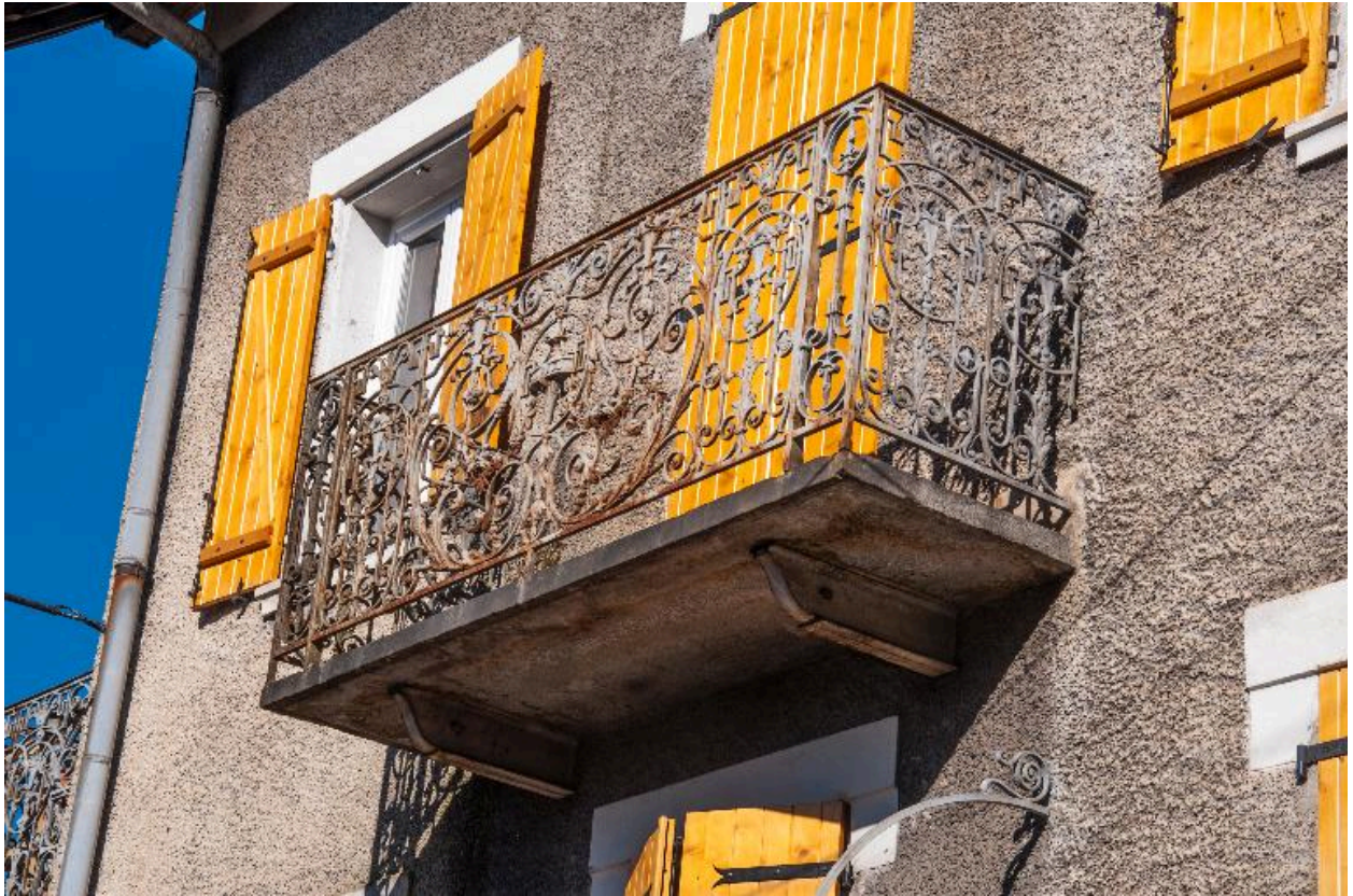
Balcon médian de la façade sud
