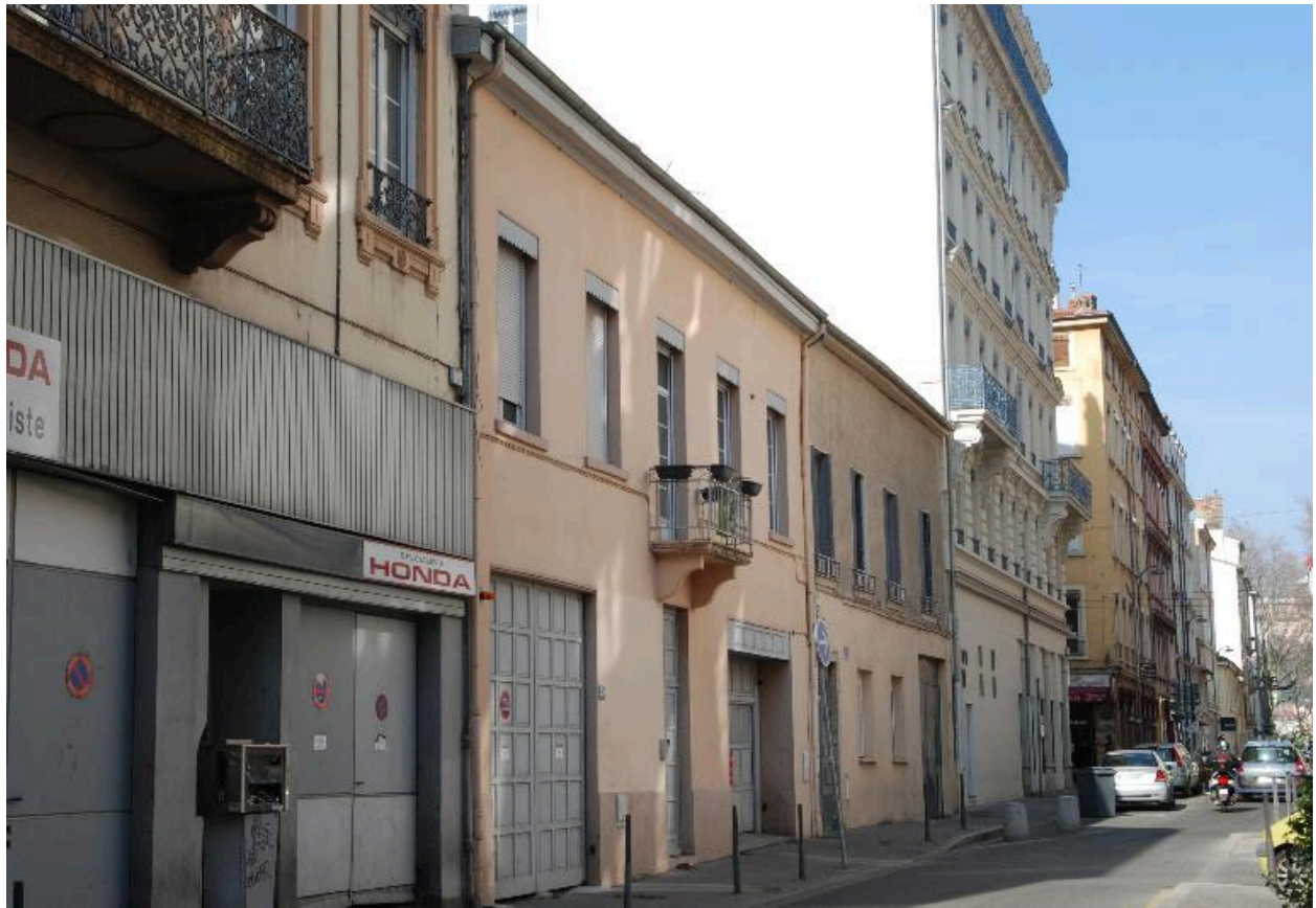
Vue générale, depuis l'est
