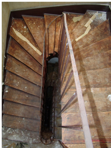
Vue de l'escalier Phot. François Fouger IVR82_20047300515NUCA
