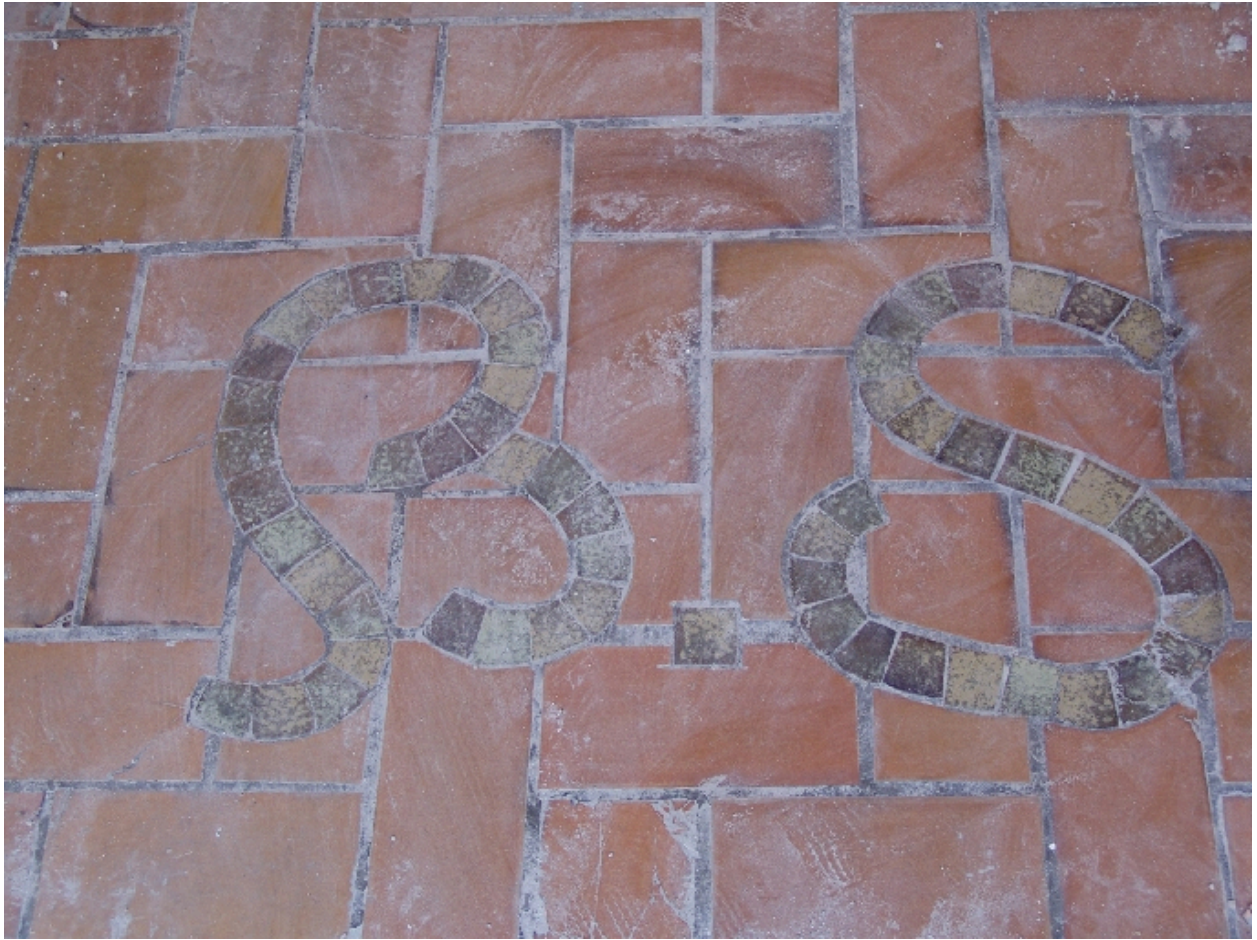
Détail du carrelage
