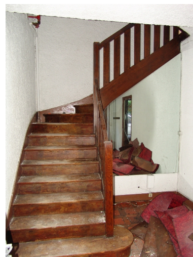
Départ de l'escalier Phot. François Fouger IVR82_20047300512NUCA
