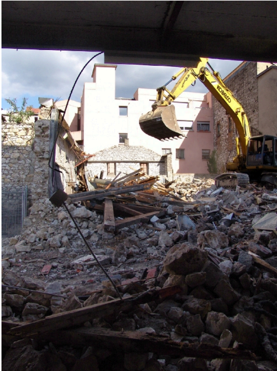
Démolition de la partie arrière
