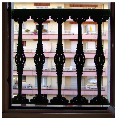
Détail d'un garde-corps Phot. François Fouger IVR82_20047300513NUCA
