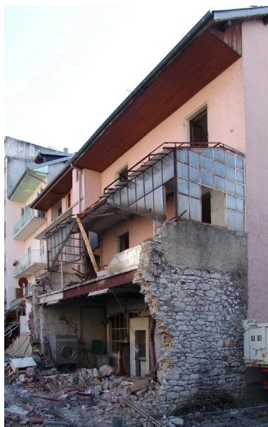
Démolition de la véranda Phot. François Fouger IVR82_20047300509NUCA
