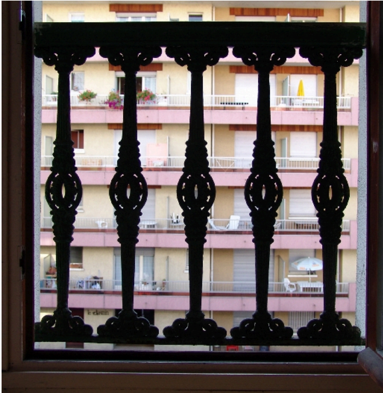
Détail d'un garde-corps
