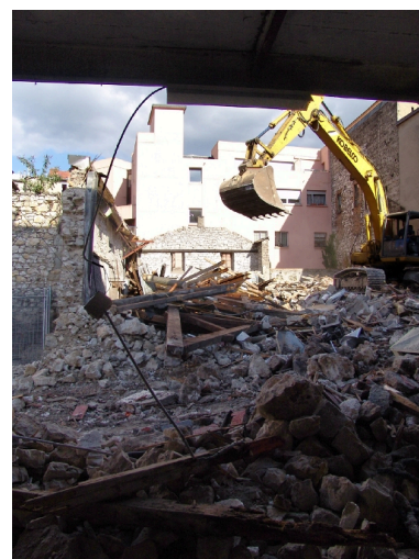
Démolition de la partie arrière Phot. François Fouger IVR82_20047300508NUCA
