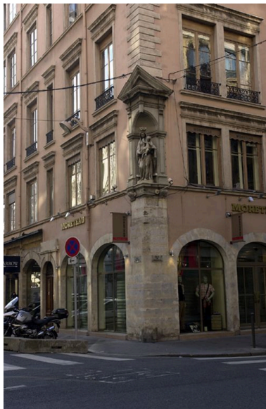
Détail de la niche d'angle Phot. Bernard Ducouret IVR82_20056901062NUCA
