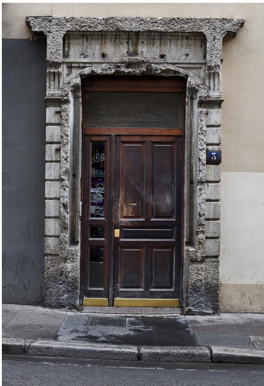
Imprimerie Nouvelle Lyonnaise - INL : porte d'entrée actuelle (modifiée en 1981 ?)
