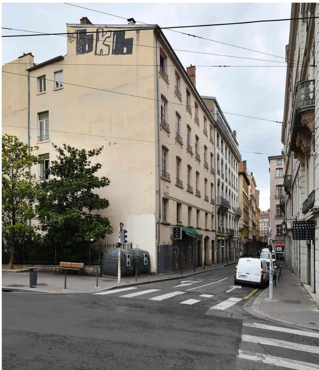
Vue ouest du bâtiment I N L - Imprimerie Nouvelle Lyonnaise
