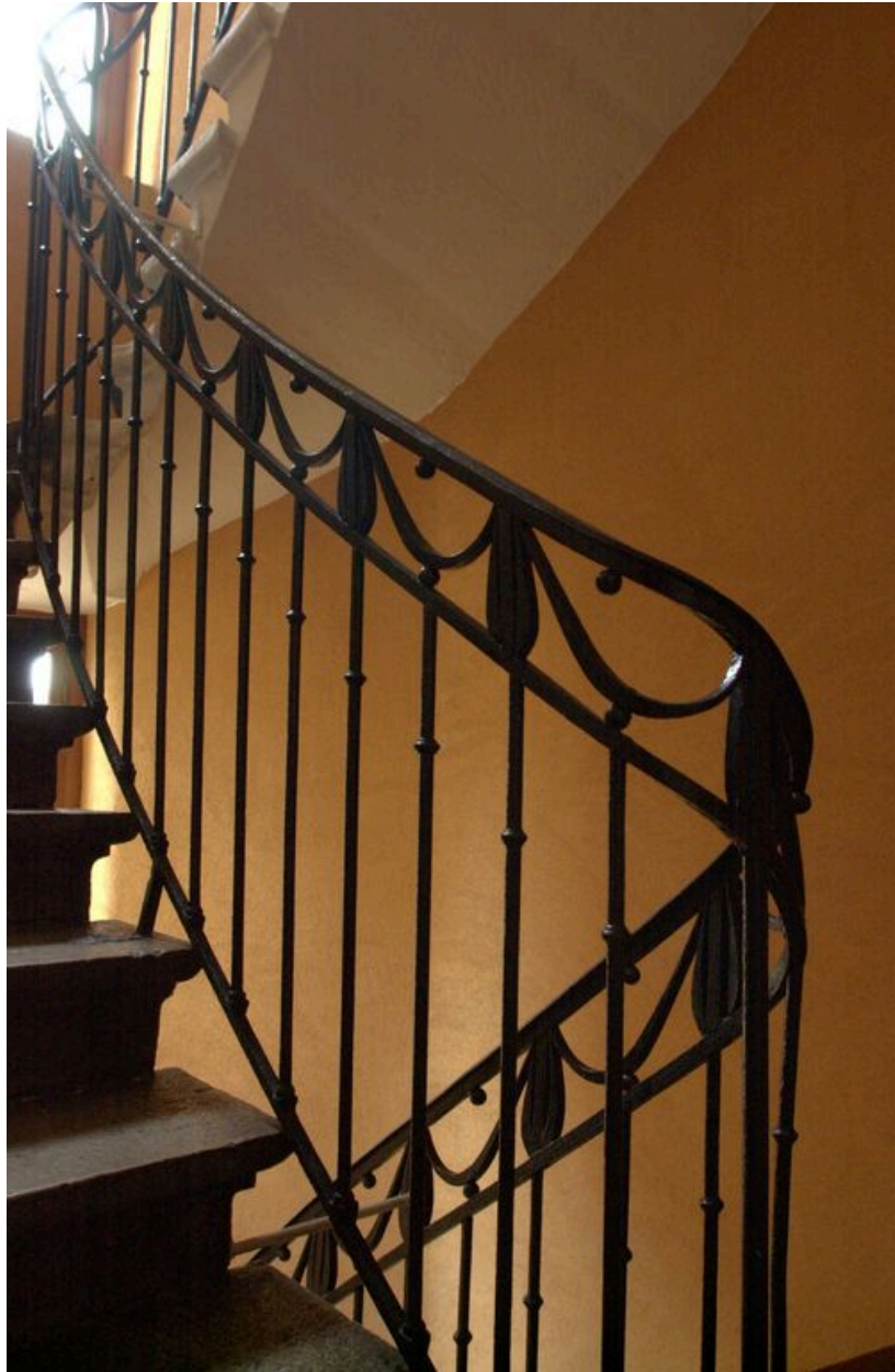
Détail de la rampe d'escalier en fonte
