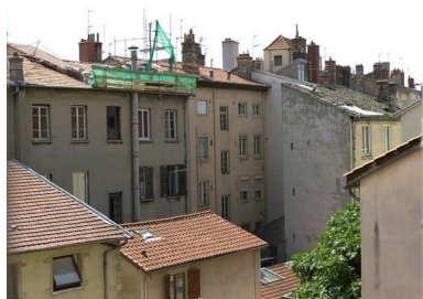
Elévation postérieure depuis le nord-ouest Phot. Maryannick Chalabi IVR82_20096901045NUCA
