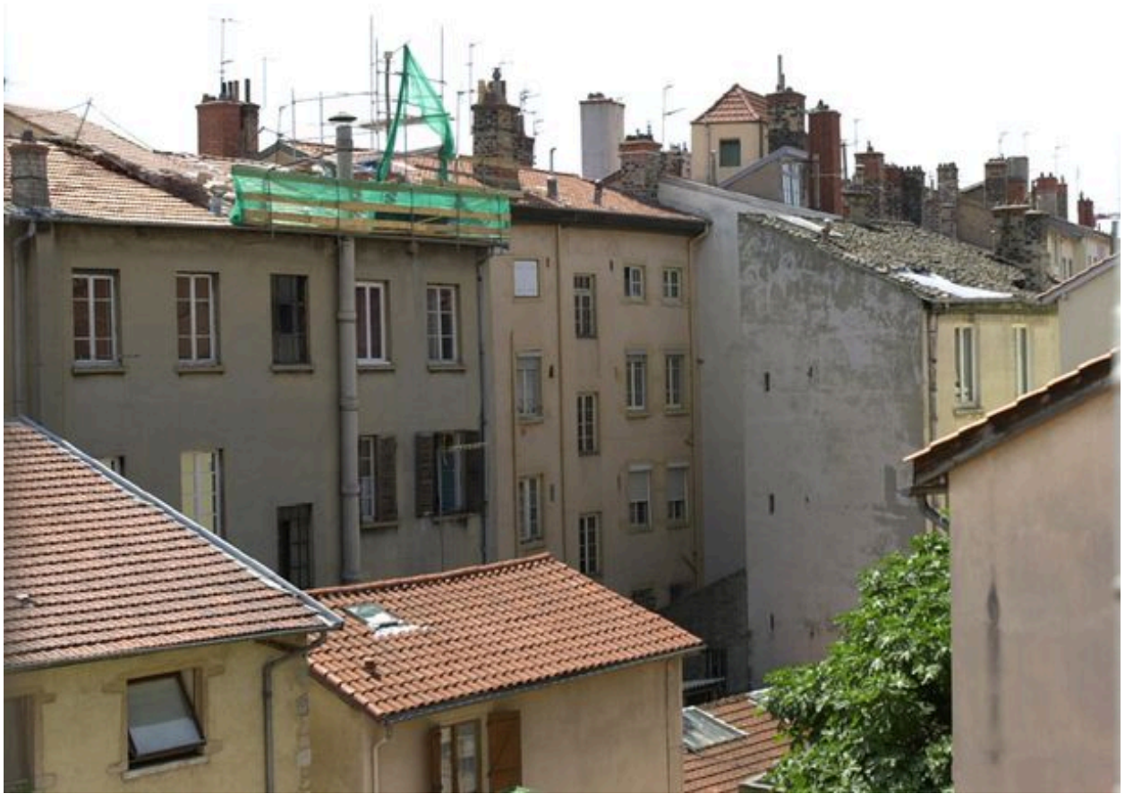
Élévation postérieure depuis le nord-ouest
