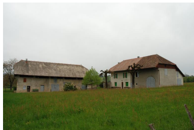
Vue générale depuis le sud-est. Phot. Caroline Guibaud IVR82_20157303012NUCA
