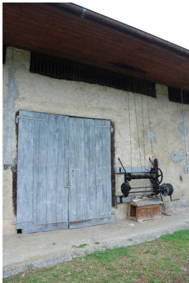
Détail de l'entrée de la grange, avec le treuil à foin. Phot. Caroline Guibaud IVR82_20157303013NUCA
