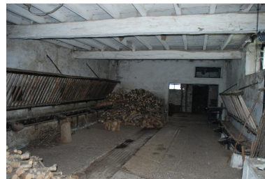
Vue intérieure de l'étable. Phot. Caroline Guibaud IVR82_20157303015NUCA
