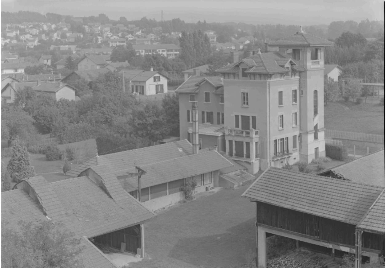
Vue d'ensemble depuis le sud-ouest, avec les bâtiments industriels.
