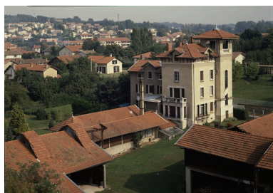
Vue d'ensemble, avec les entrepôts de bois. Phot. Jean-Marie Refflé IVR82_19870100374PA
