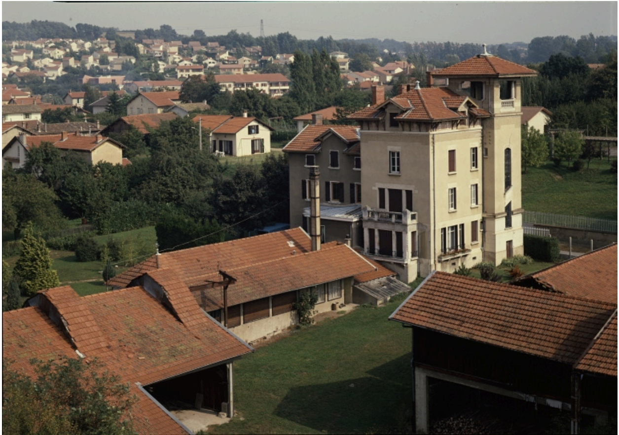
Vue d'ensemble, avec les entrepôts de bois.
