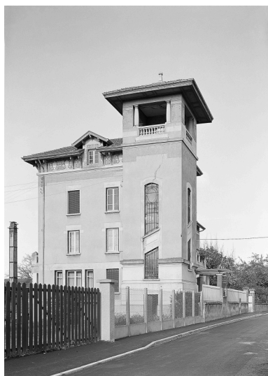
Vue depuis le sud. Repro. Jean-Marie Refflé
