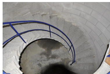
Escalier en vis suspendu, vue par dessus Phot. Nadine Halitim-Dubois IVR82_20130700161NUCA
