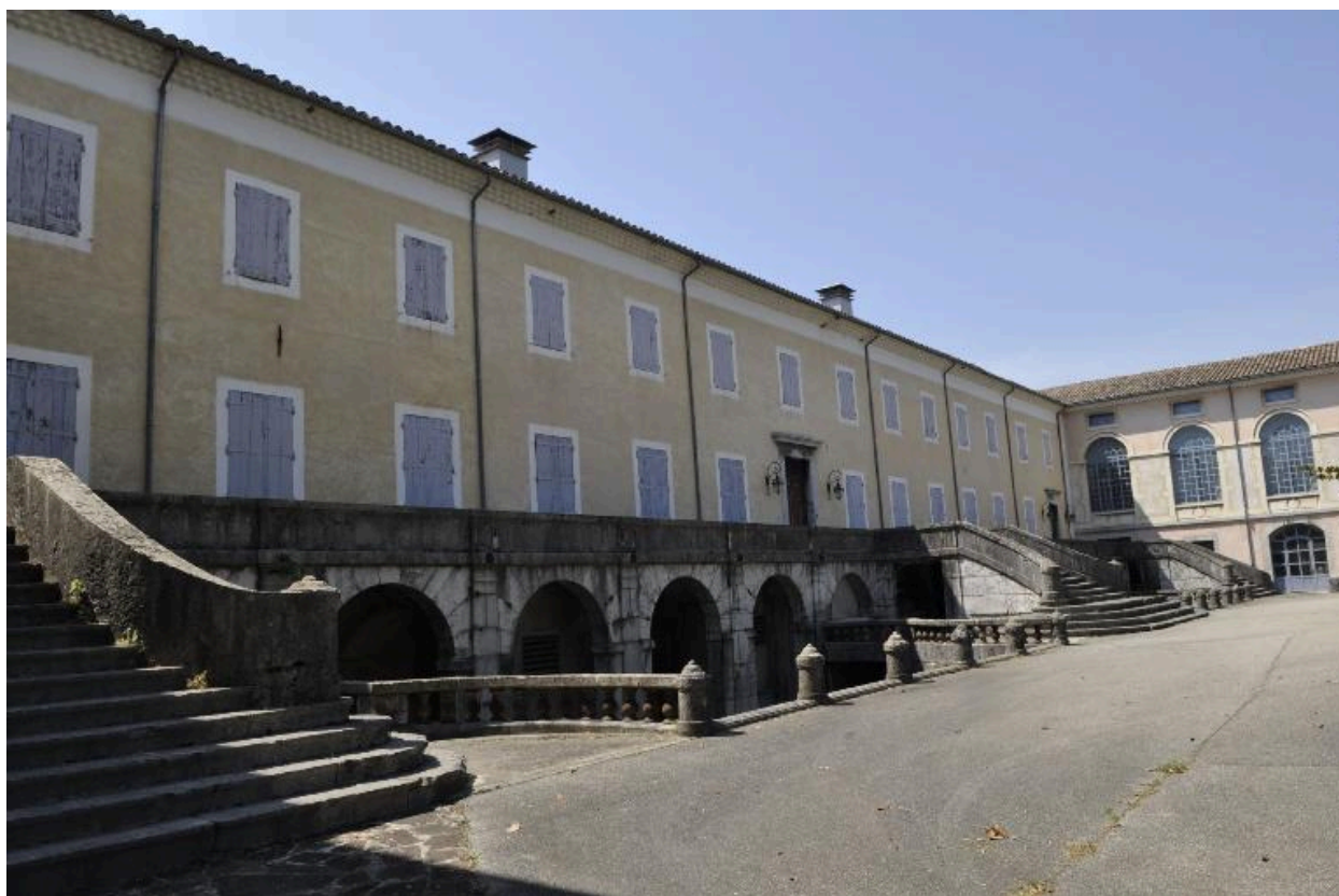
Vue du moulinage Blanchon : façade principale surmonté d'une génoise
