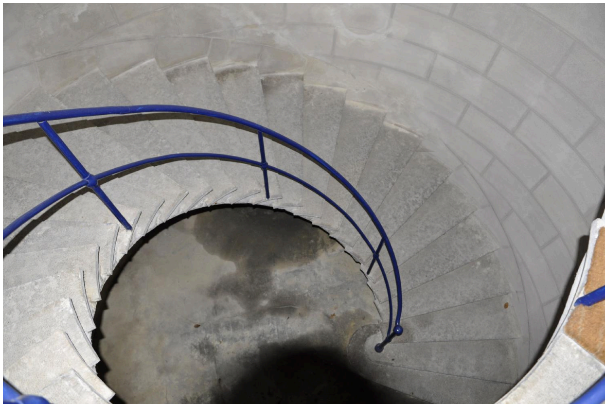
Escalier en vis suspendu, vue par dessus
