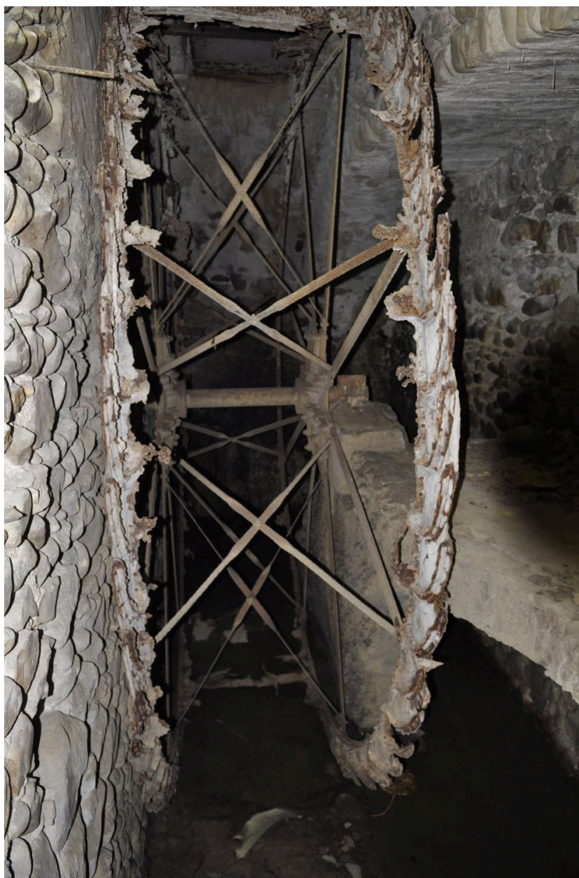
Roue de l'ancien système hydraulique (vue d'intérieur)
