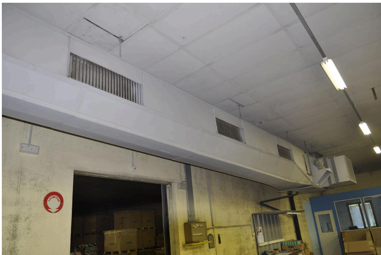
Atelier de texturation détail ventilations (vue d'intérieur)
