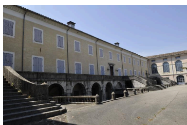
Vue du moulinage Blanchon : façade principale surmonté d'une génoise Phot. Nadine Halitim-Dubois IVR82_20130700070NUCA
