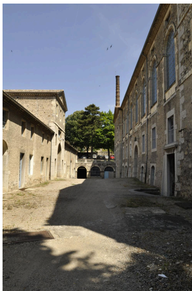
Vue d'ensemble des circulations extérieures Phot. Nadine Halitim-Dubois IVR82_20130700049NUCA
