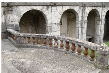
Vue extérieure : balustrade composée de balustres en poire Phot. Nadine Halitim-Dubois IVR82_20130700083NUCA
