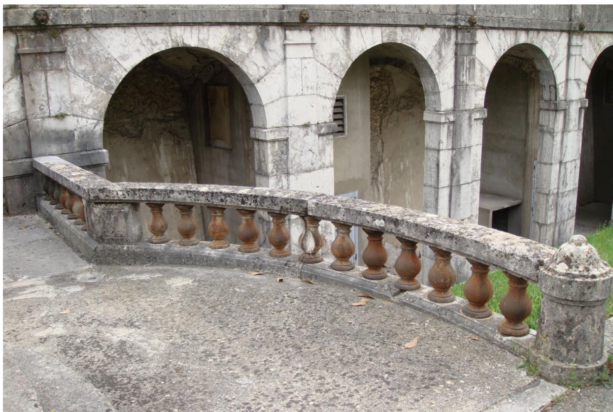
Vue extérieure : balustrade composée de balustres en poire
