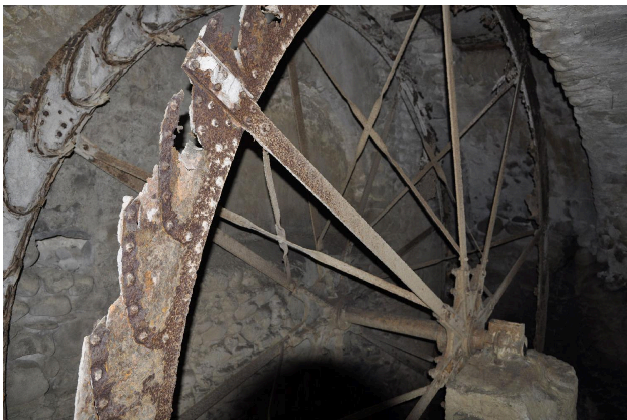
Roue de l'ancien système hydraulique (vue d'intérieur)
