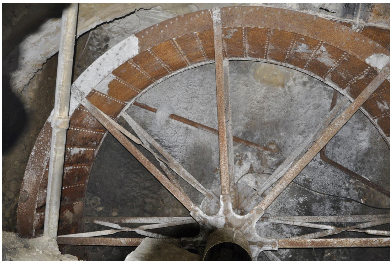
Roue de l'ancien système hydraulique (vue d'intérieur)
