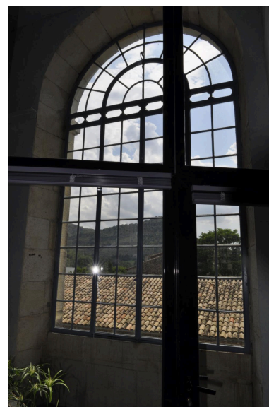
Porte-fenêtre à châssis de tympan en éventail (vue d'intérieur) Phot. Nadine Halitim-Dubois IVR82_20130700155NUCA
