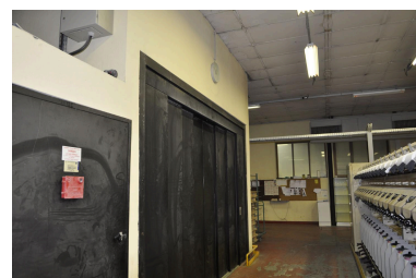
Monte-charges (vue d'intérieur) Phot. Nadine Halitim-Dubois IVR82_20130700117NUCA
