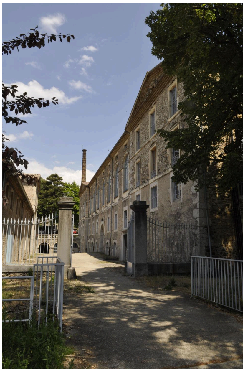
Entrée du moulinage (vue d'extérieur)
