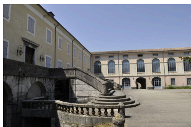
Vue d'ensemble sud de la grande cour principale Phot. Nadine Halitim-Dubois IVR82_20130700073NUCA
