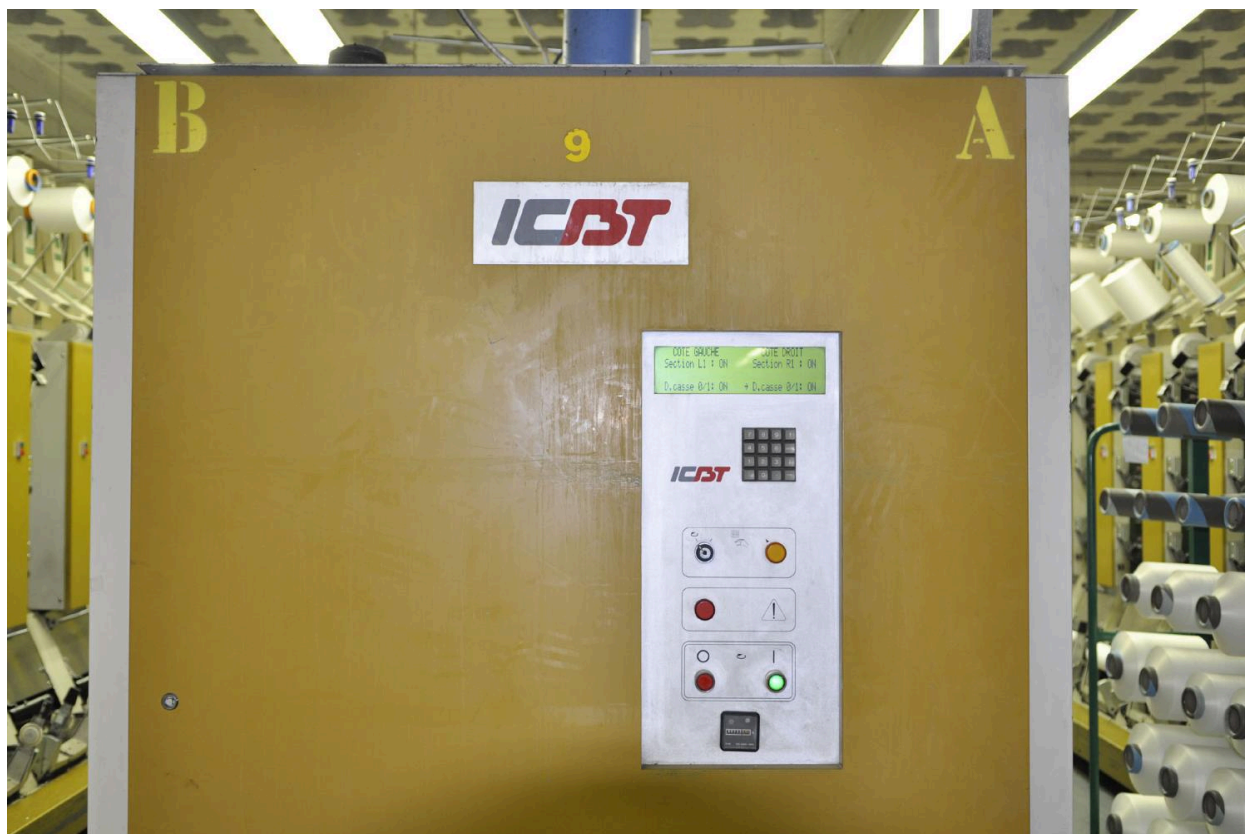
Détail : tableau de contrôle (vue d'intérieur)
