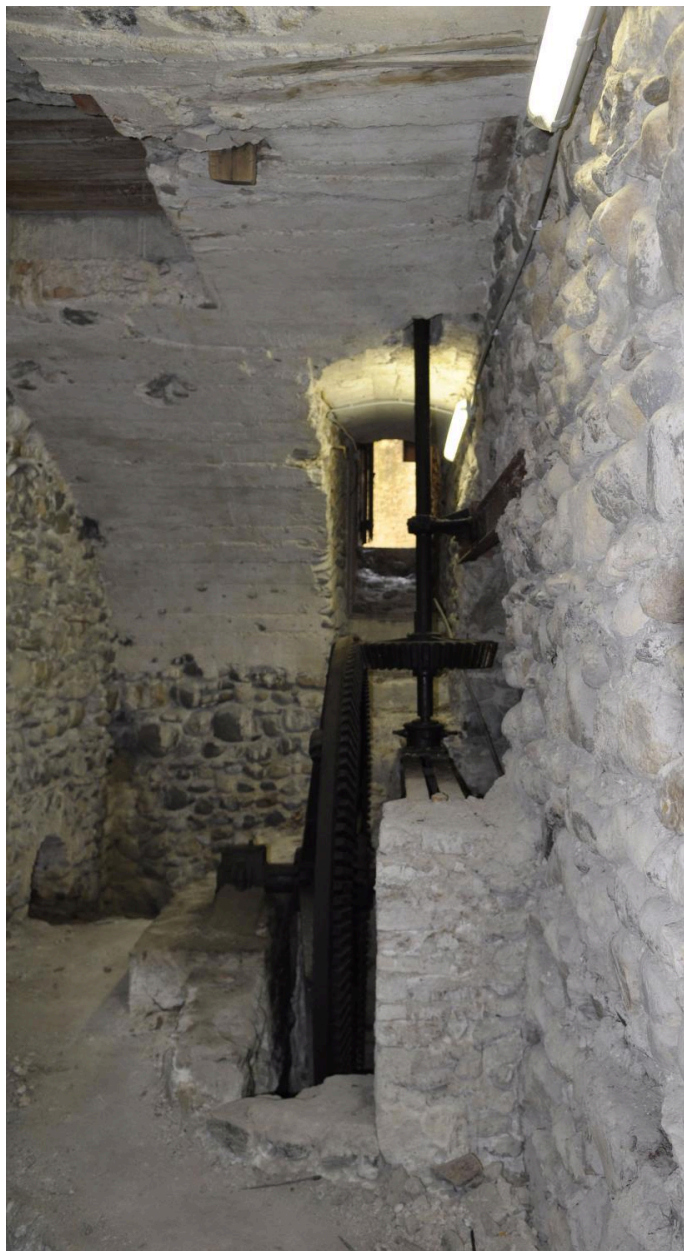
Ancien système hydraulique (vue d'intérieur)
