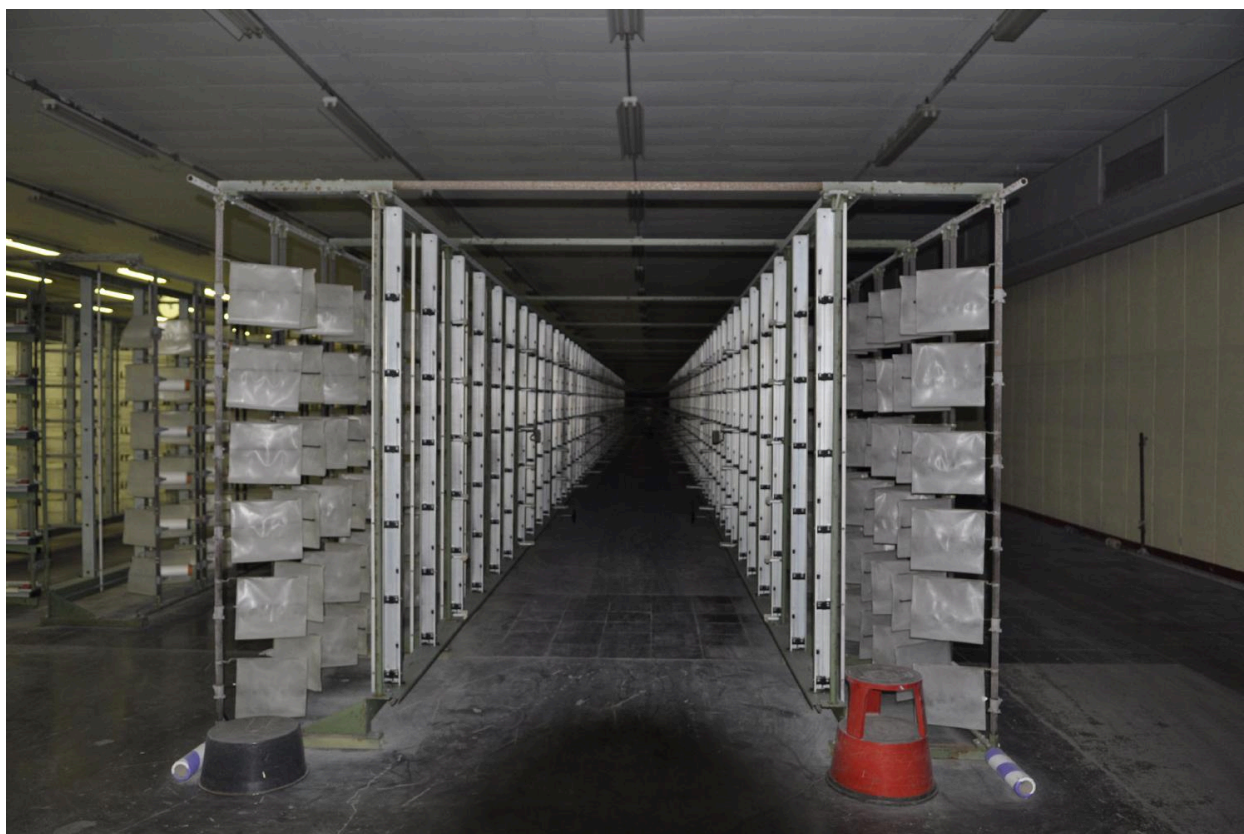
Atelier de texturation, détail (vue d'intérieur)
