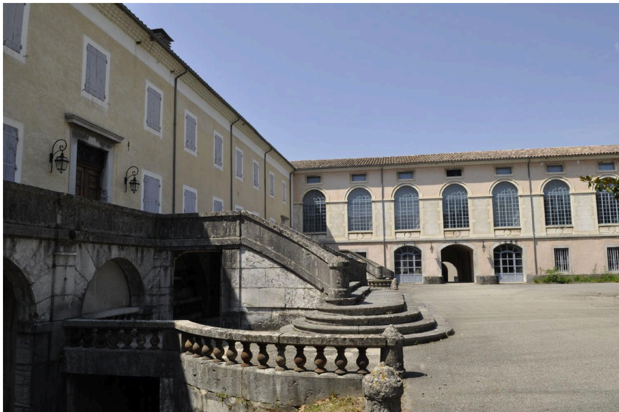
Vue d'ensemble sud de la grande cour principale
