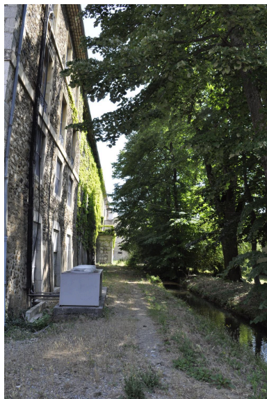
Vue d'extérieur Phot. Nadine Halitim-Dubois IVR82_20130700051NUCA
