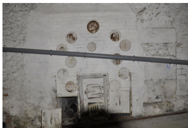
Chaudière de l'ancien système hydraulique Phot. Nadine Halitim-Dubois IVR82_20130700064NUCA
