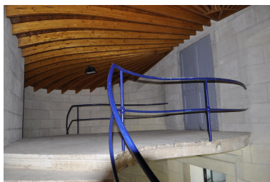
Escalier en vis suspendu, palier d'arrivée (vue d'intérieur) Phot. Nadine Halitim-Dubois IVR82_20130700160NUCA
