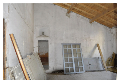
Comble (vue d'intérieur) Phot. Nadine Halitim-Dubois IVR82_20130700044NUCA
