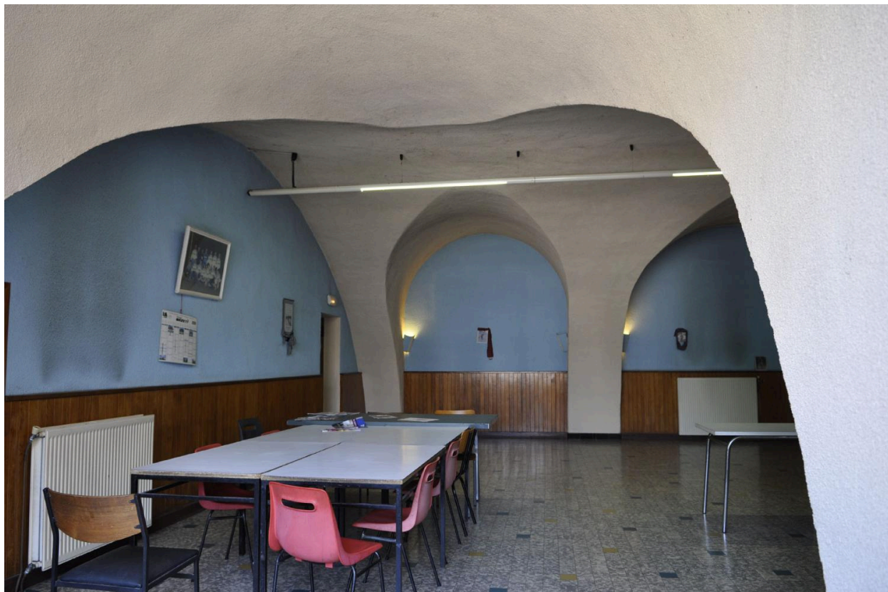
Ancien atelier voûté, actuellement salle de repos (vue d'intérieur)
