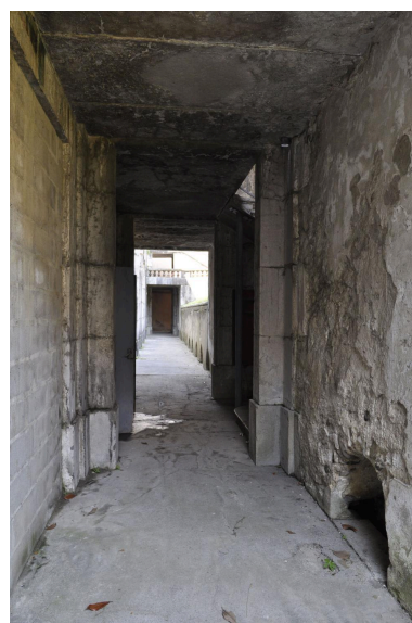
Galerie de passage (vue d'extérieur) Phot. Nadine Halitim-Dubois IVR82_20130700087NUCA
