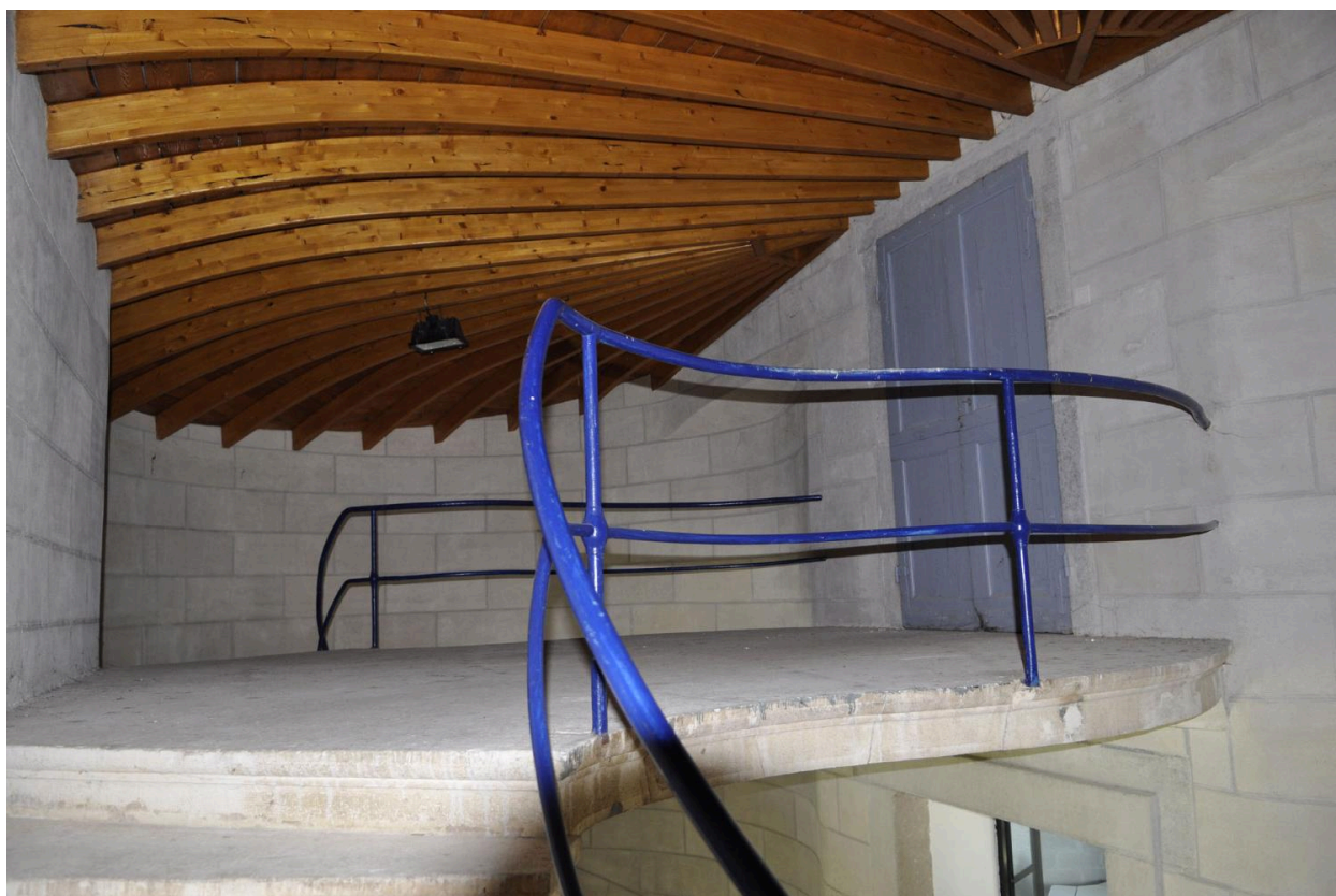
Escalier en vis suspendu, palier d'arrivée (vue d'intérieur)
