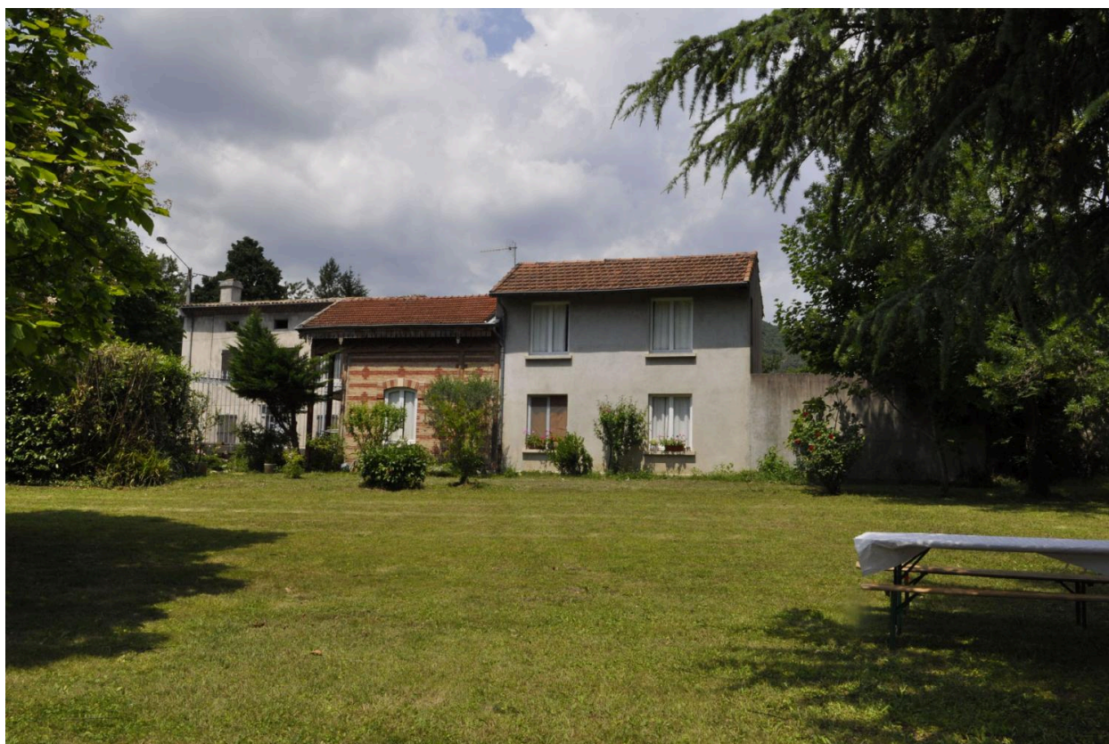
Vue d'extérieur du site
