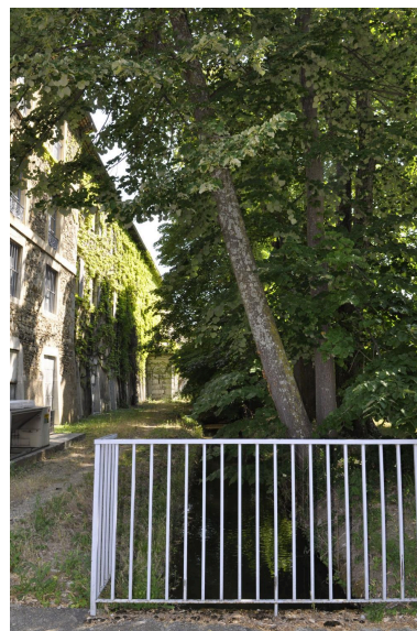
Détail parc Phot. Nadine Halitim-Dubois IVR82_20130700050NUCA
