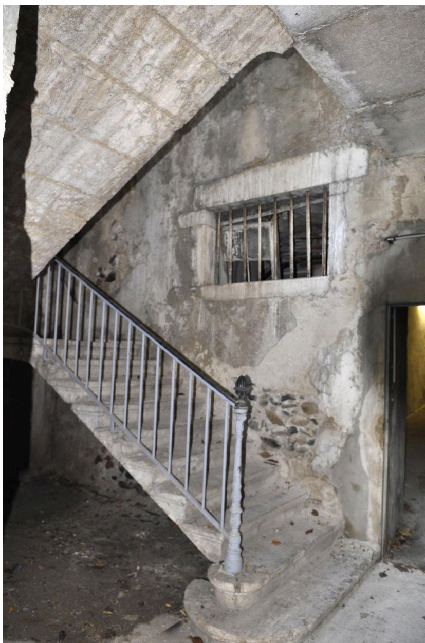
Escalier suspendu à retours (vue d'intérieur)
