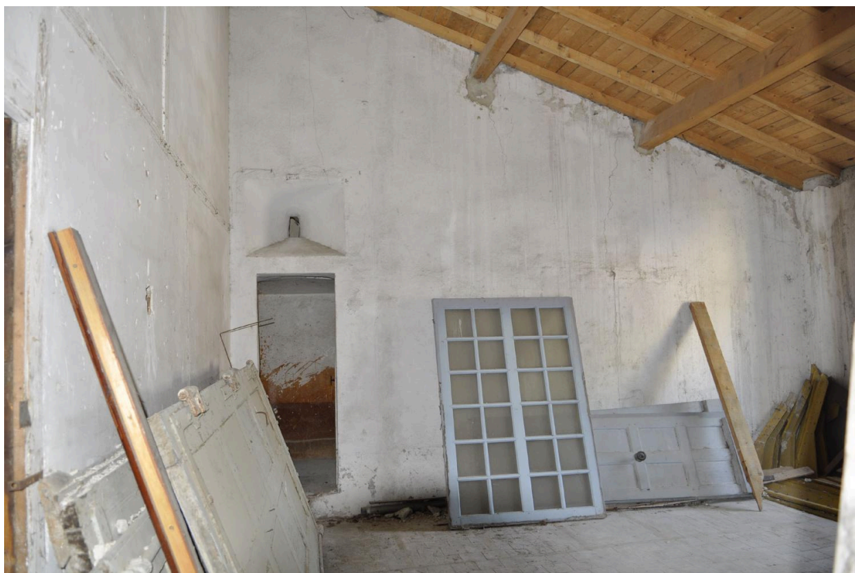
Comble (vue d'intérieur)
