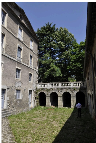
Vue des extérieurs, galerie Phot. Nadine Halitim-Dubois IVR82_20130700066NUCA
