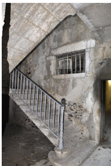
Escalier suspendu à retours (vue d'intérieur) Phot. Nadine Halitim-Dubois IVR82_20130700085NUCA
