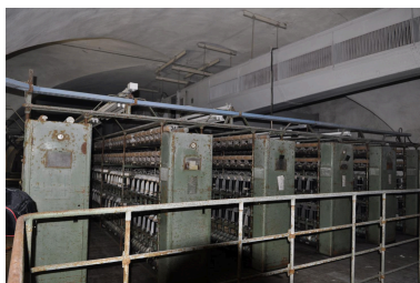
Ancien atelier vue d'intérieur Phot. Nadine Halitim-Dubois IVR82_20130700092NUCA
