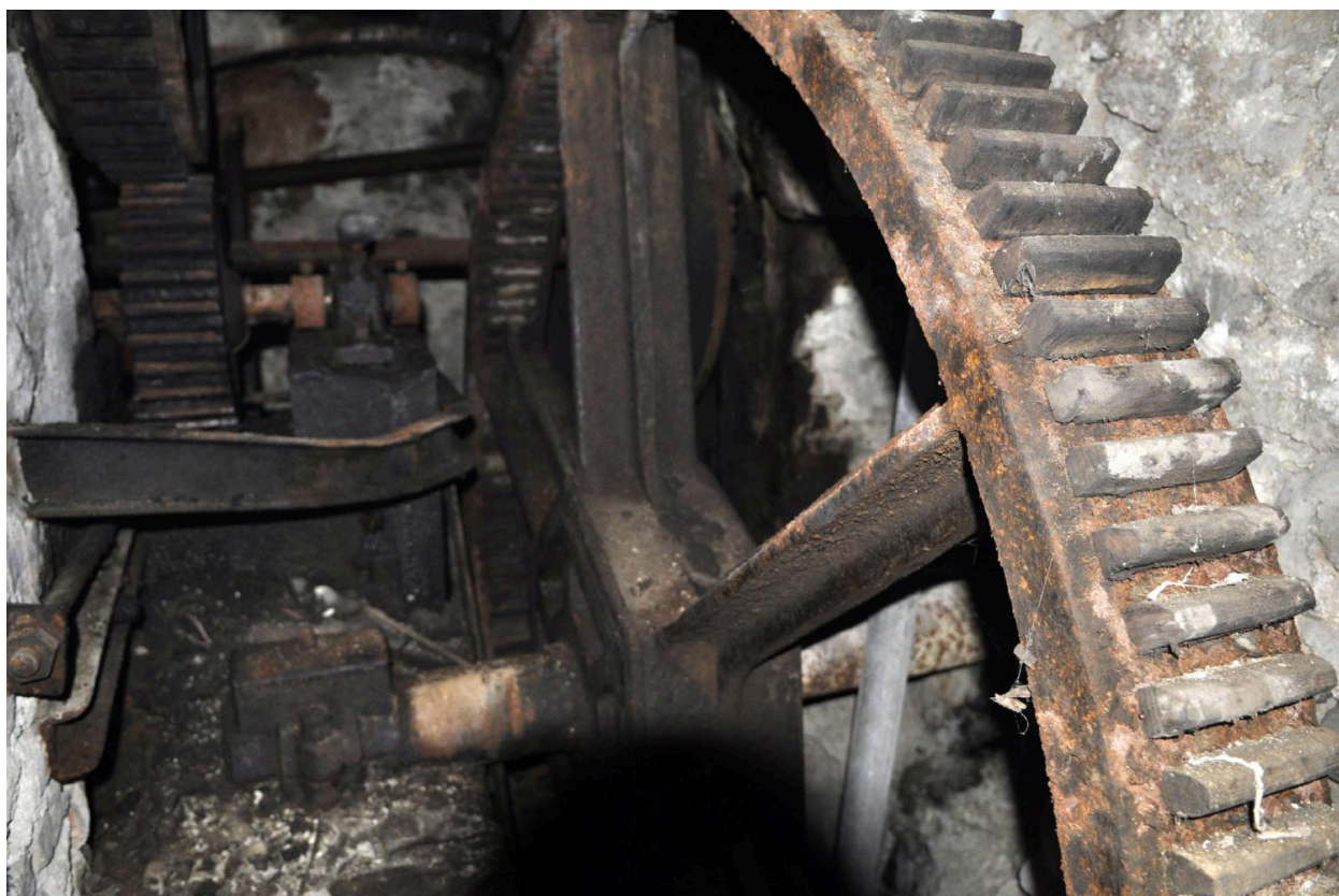
Ancien système hydraulique (vue d'intérieur)
