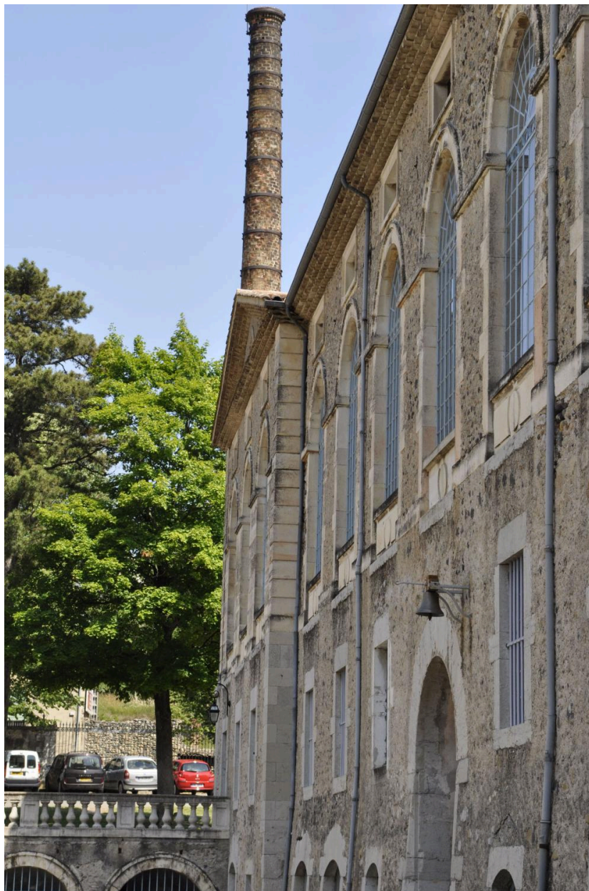
Façade du moulinage, pierre apparente et cheminé d'usine circulaire
