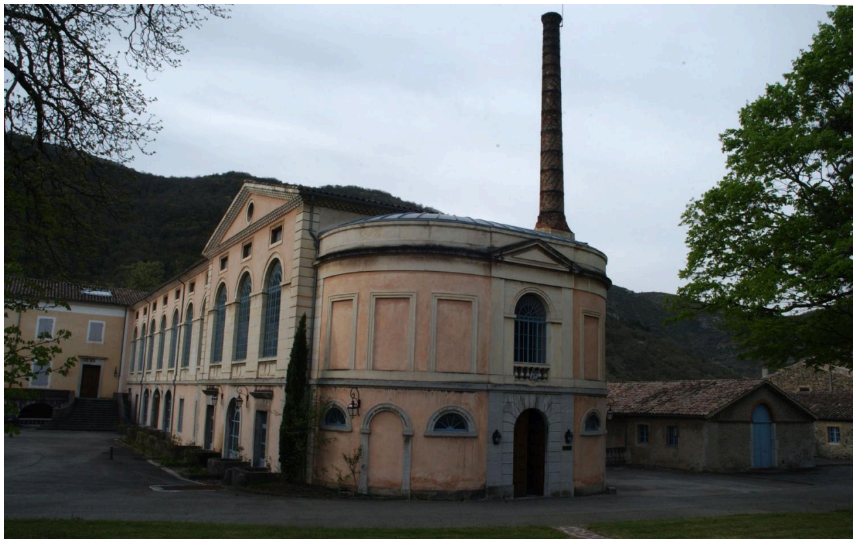
Rotonde à deux niveaux, avec cheminée, vue d'extérieur
