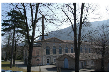
Vue extérieure du moulinage Phot. Nadine Halitim-Dubois IVR82_20130700080NUCA
