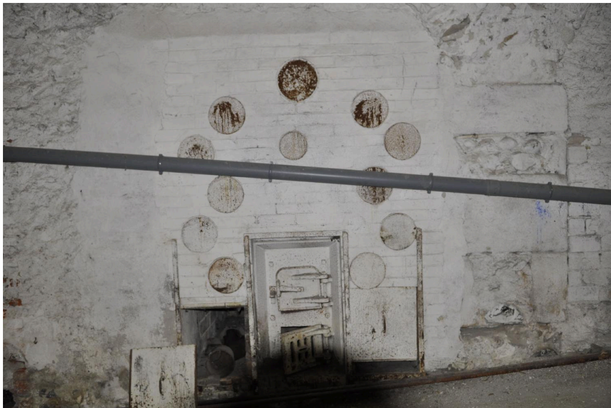
Chaudière de l'ancien système hydraulique
