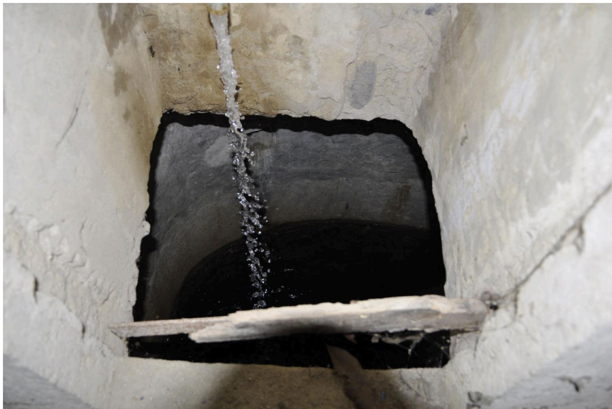
Détail système hydraulique
