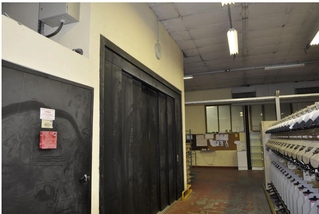
Monte-charges (vue d'intérieur)
