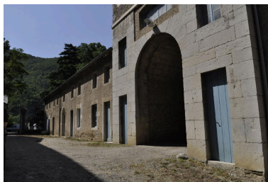
Passage : blocs calcaire, avec chaînages et encadrements Phot. Nadine Halitim-Dubois IVR82_20130700042NUCA
