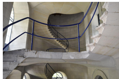
Détail palier escalier en vis suspendu, avec rampe d'appui (vue d'intérieur) Phot. Nadine Halitim-Dubois IVR82_20130700144NUCA
