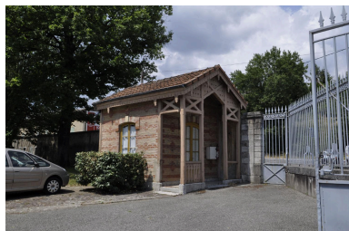
Poste de gardiennage : motif de brique et portique en bois à décor (vue d'extérieur) Phot. Nadine Halitim-Dubois IVR82_20130700133NUCA
