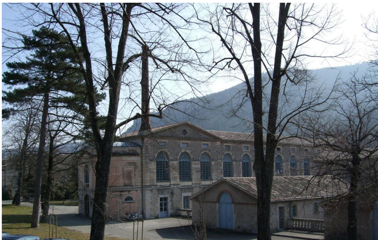
Vue extérieure du moulinage
