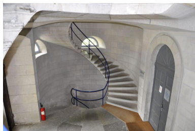
Escalier en vis suspendu, avec rampe métallique (vue d'intérieur) Phot. Nadine Halitim-Dubois IVR82_20130700145NUCA
