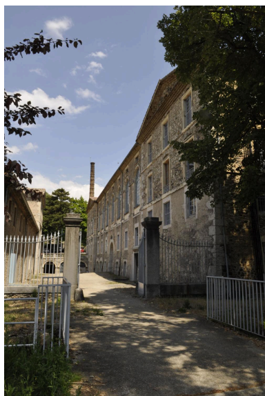
Entrée du moulinage (vue d'extérieur) Phot. Nadine Halitim-Dubois IVR82_20130700097NUCA
