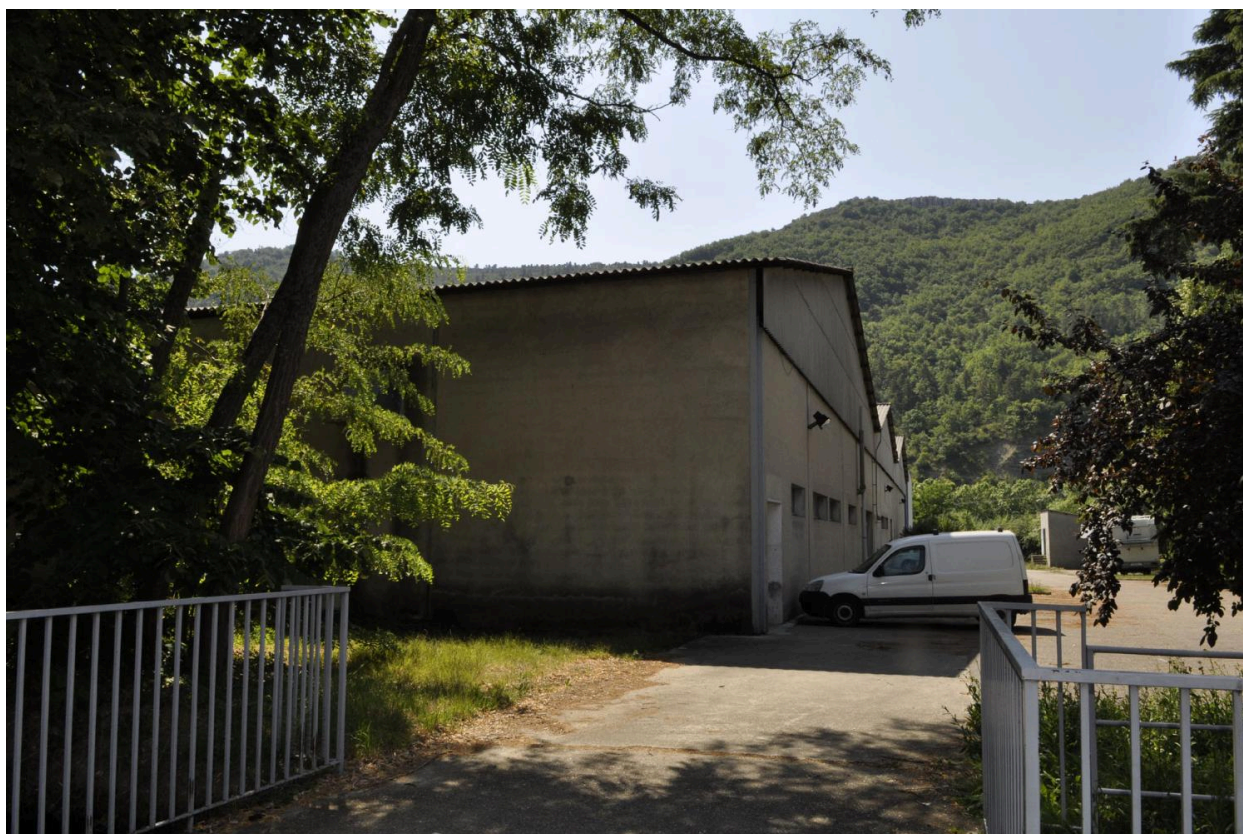
Extension de 1956 réalisée par la société FIMOLA
