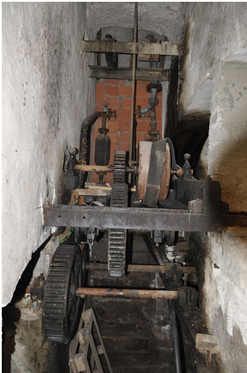
Ancien système hydraulique (vue d'intérieur)
