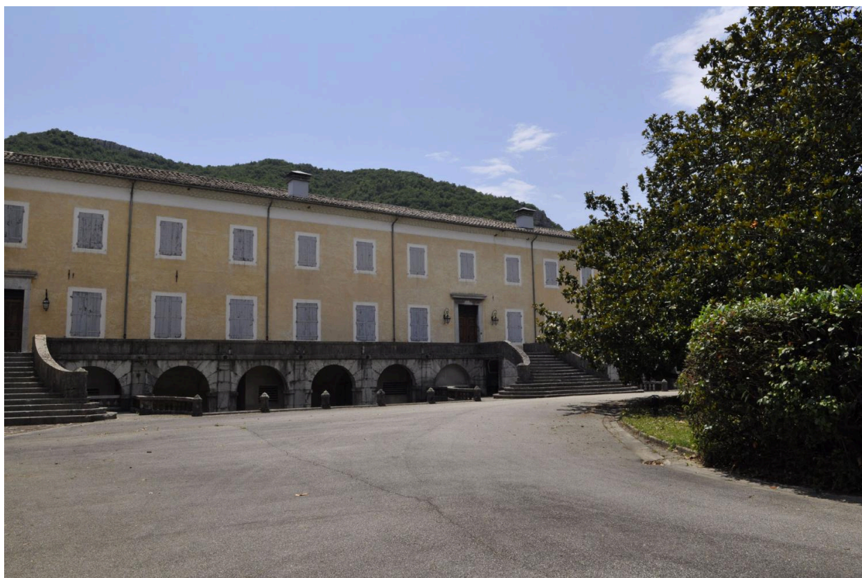
Façade principale du bâtiment principal, avec soubassement en galerie
