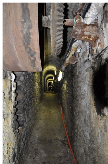
Ancienne galerie hydraulique Phot. Nadine Halitim-Dubois IVR82_20130700062NUCA
