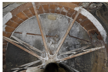
Roue de l'ancien système hydraulique (vue d'intérieur) Phot. Nadine Halitim-Dubois IVR82_20130700078NUCA
