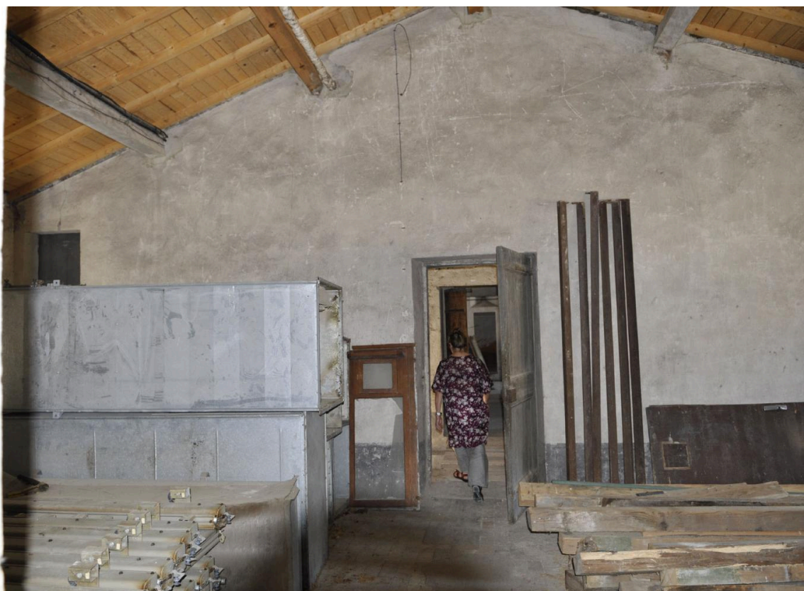
Comble (vue d'intérieur)
