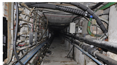
Réseau électrique de l'usine raccordé au réseau EDF en 1956 par la société FIMOLA Phot. Nadine Halitim-Dubois IVR82_20130700084NUCA
