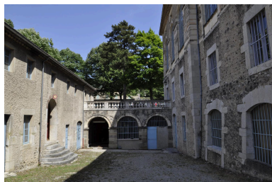
Galerie ouverte sur cour (vue d'extérieur) Phot. Nadine Halitim-Dubois IVR82_20130700041NUCA
