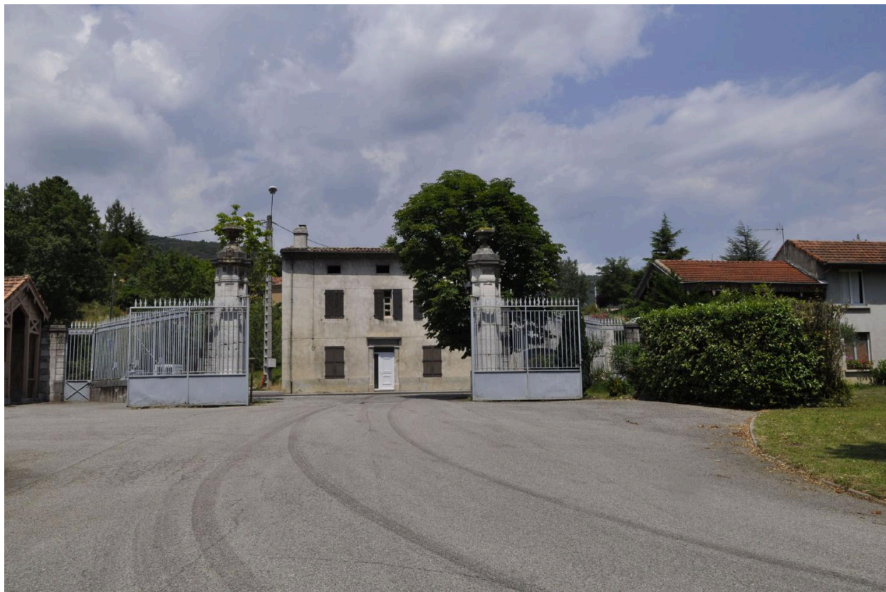
Entrée du moulinage
