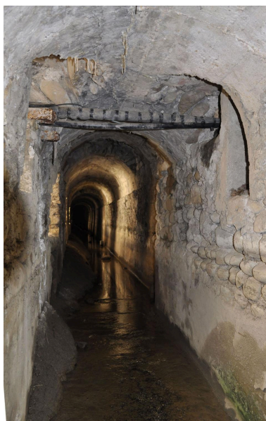
Bief du système hydraulique Phot. Nadine Halitim-Dubois IVR82_20130700055NUCA
