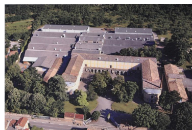
Vue zénithale de l'usine Payen (archive privée de la société) Phot. Nadine Halitim-Dubois IVR82_20130700156NUCA
