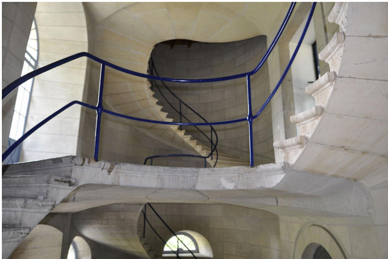
Détail palier escalier en vis suspendu, avec rampe d'appui (vue d'intérieur)
