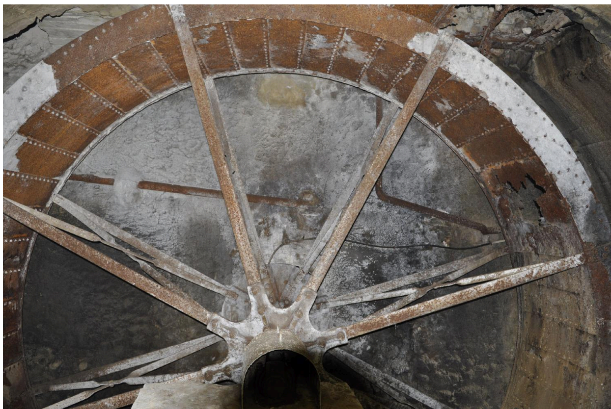
Roue de l'ancien système hydraulique (vue d'intérieur)
