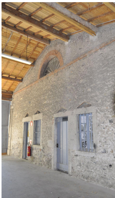
Pignon convert (vue d'intérieur) Phot. Nadine Halitim-Dubois IVR82_20130700077NUCA
