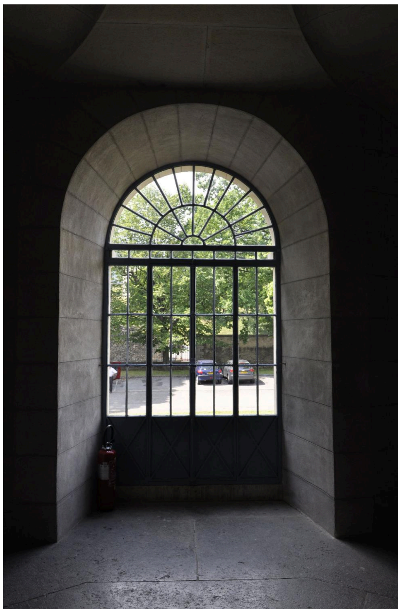
Porte-fenêtre à châssis de tympan en éventail (vue d'intérieur)
