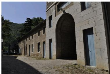
Passage : blocs calcaire, avec chaînages et encadrements
