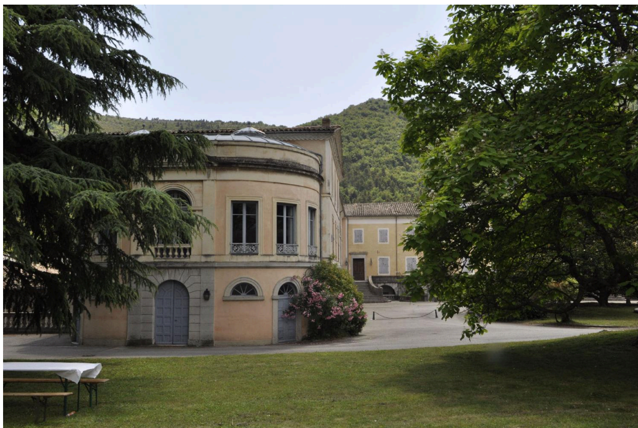
Rotonde (élément semi-circulaire), située à chaque extrémité des deux ailes du corps central
