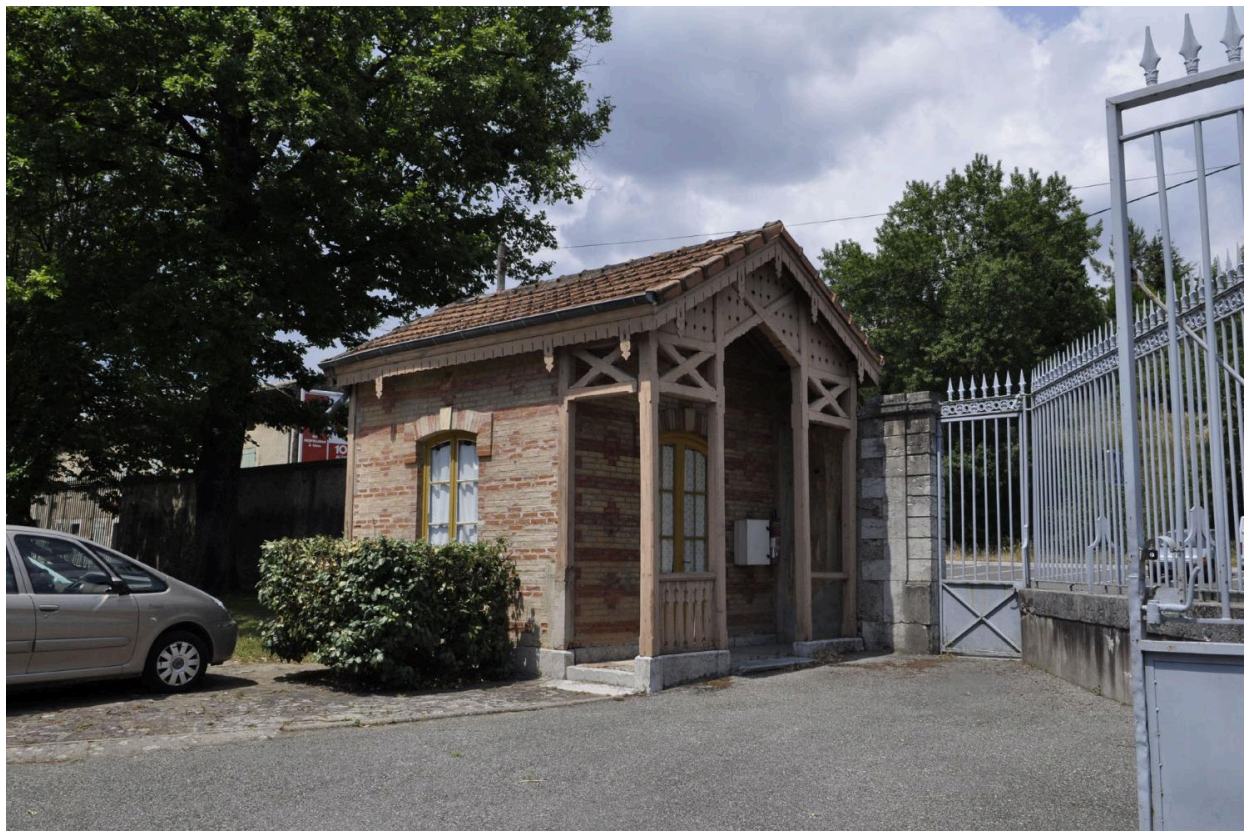
Poste de gardiennage : motif de brique et portique en bois à décor (vue d'extérieur)
