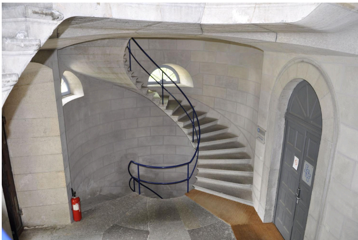
Escalier en vis suspendu, avec rampe métallique (vue d'intérieur)
