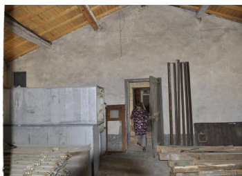
Comble (vue d'intérieur) Phot. Nadine Halitim-Dubois IVR82_20130700045NUCA
