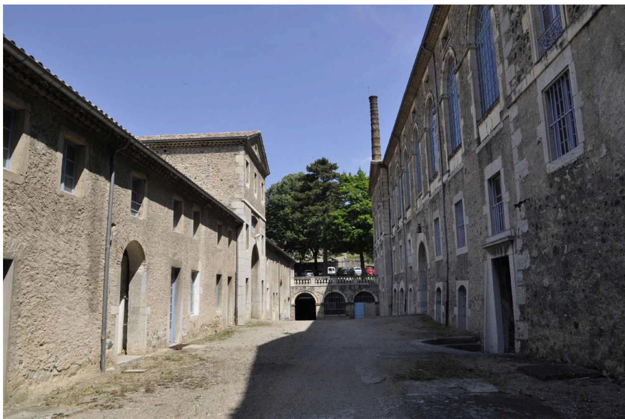
Vue nord des bâtiments
