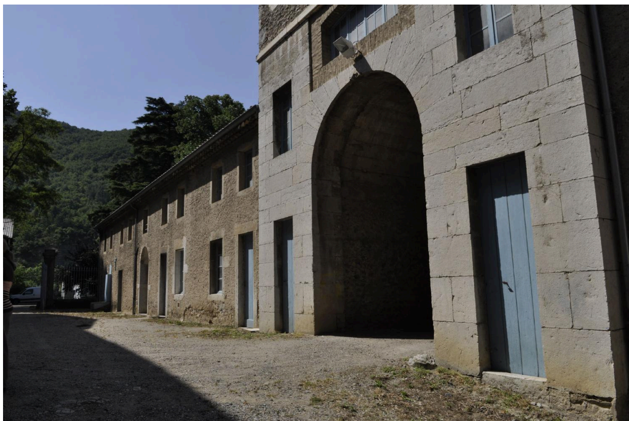
Passage : blocs calcaire, avec chaînages et encadrements
