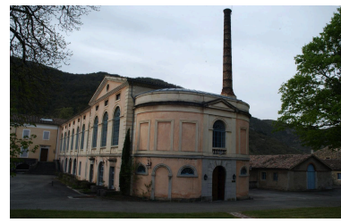
Rotonde à deux niveaux, avec cheminée, vue d'extérieur Phot. Nadine Halitim-Dubois IVR82_20130700162NUCA
