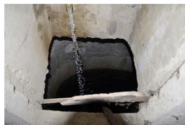
Détail système hydraulique Phot. Nadine Halitim-Dubois IVR82_20130700056NUCA
