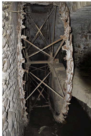
Roue de l'ancien système hydraulique (vue d'intérieur) Phot. Nadine Halitim-Dubois IVR82_20130700059NUCA
