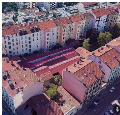
Usine localisée au 135 rue Baraban Phot. Nadine Halitim-Dubois IVR84_20246901154NUCA
