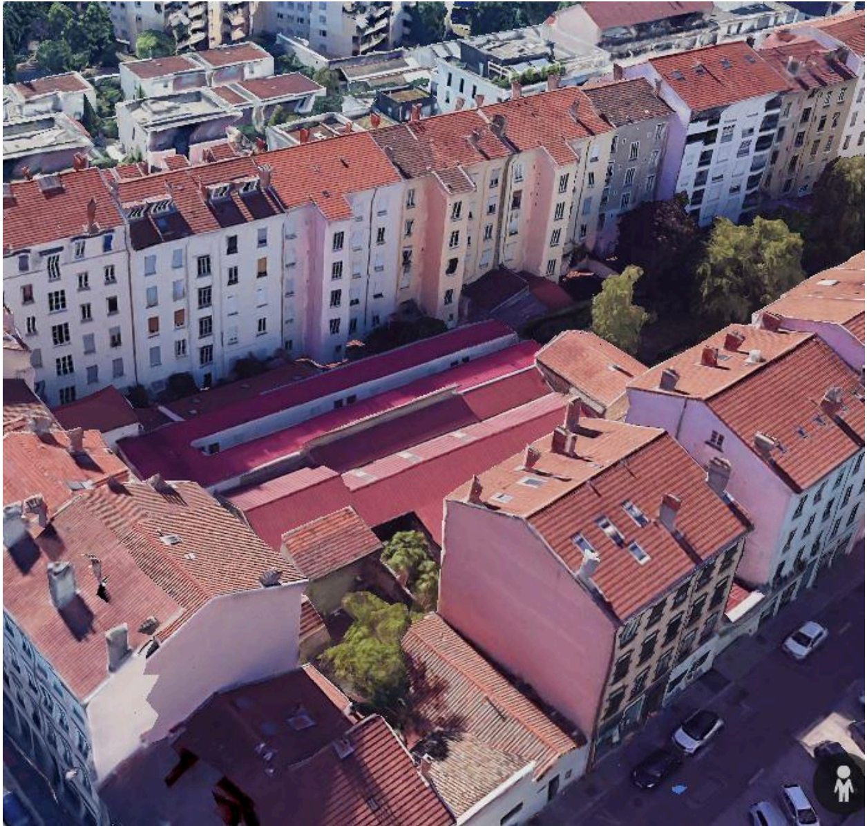
Usine localisée au 135 rue Baraban
