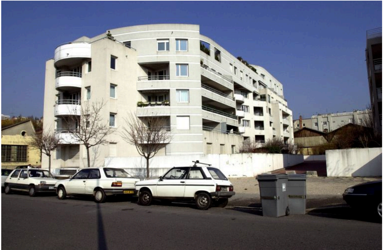
Elévation postérieure de l'immeuble rue Claudius-Collonge
