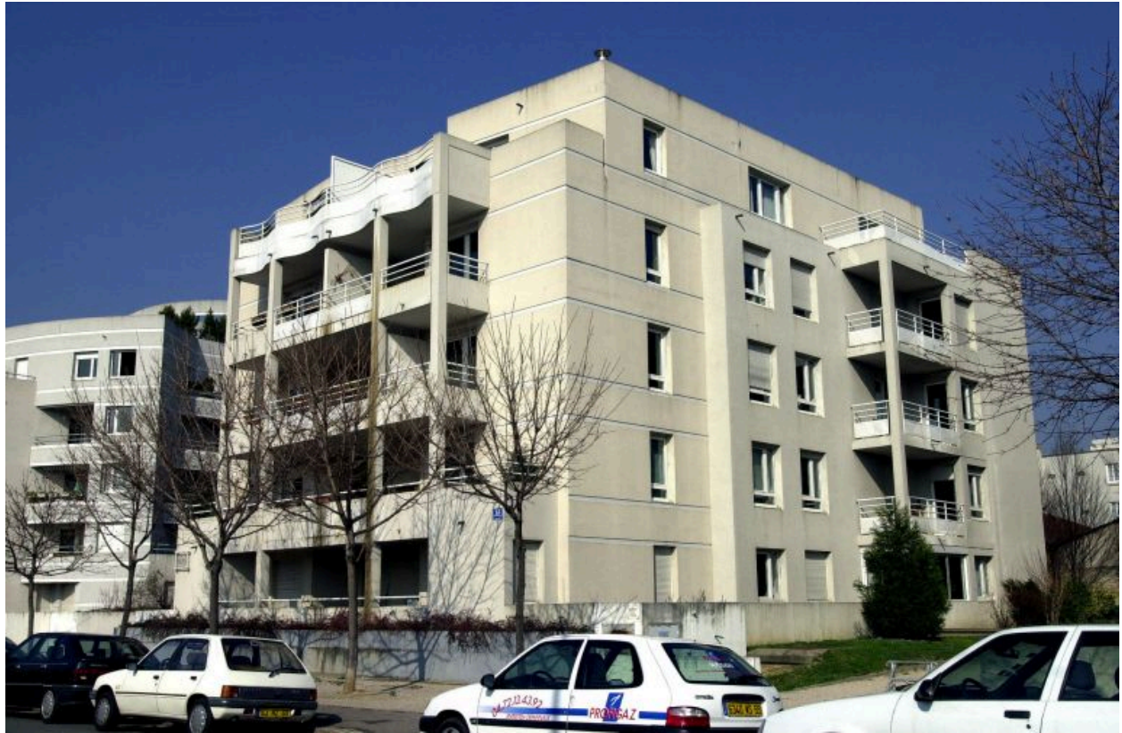
Elévation de l'immeuble rue Bichat
