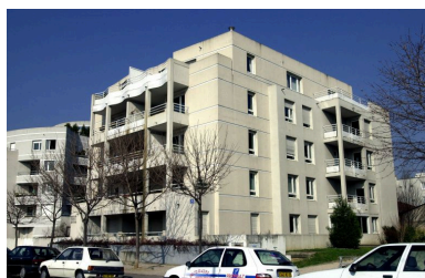
Élévation de l'immeuble rue Bichat Phot. Maryannick Chalabi IVR82_20016900421NUCA
