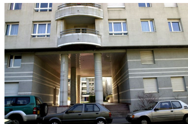
Vue du corps de passage vers le jardin depuis la rue Claudius-Collonge Phot. Maryannick Chalabi IVR82_20016900390NUCA
