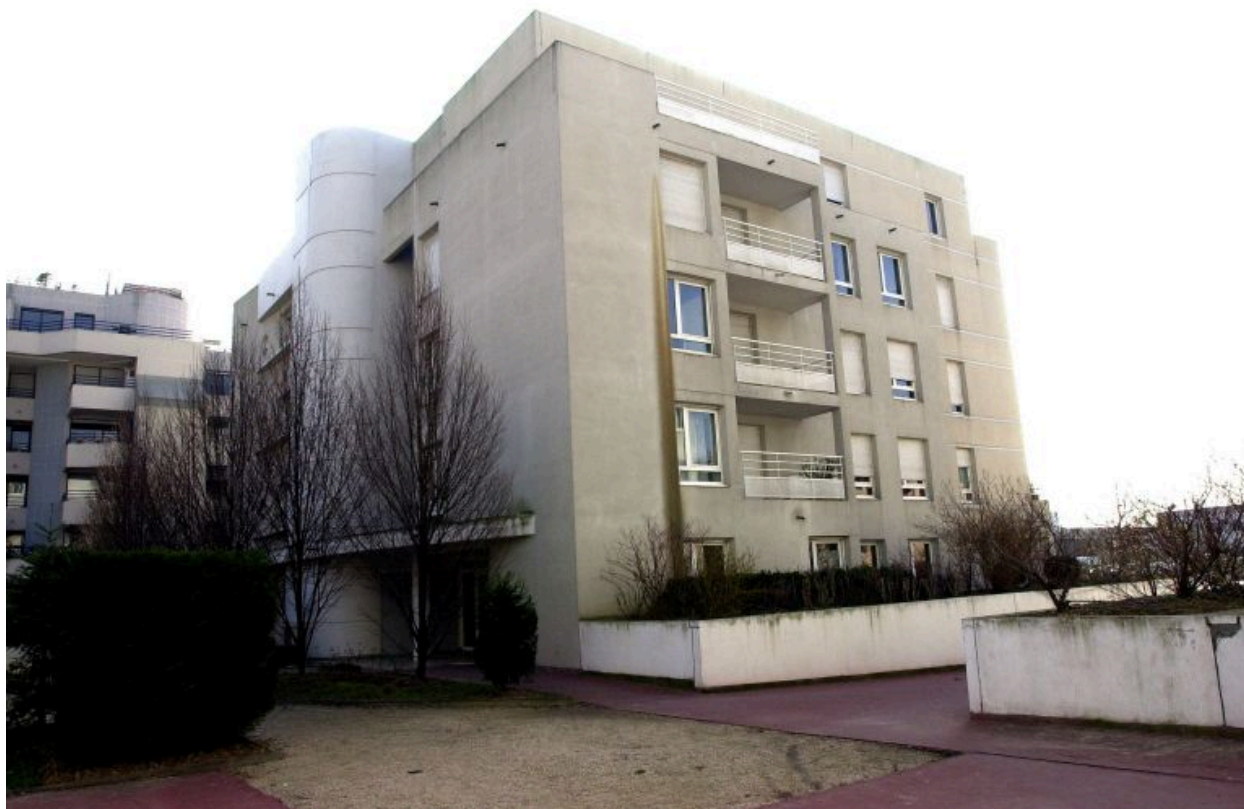
Vue d'ensemble de l'immeuble rue Bichat, depuis le nord-ouest
