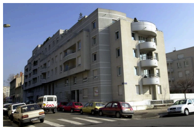
Vue d'ensemble depuis la rue Bichat Phot. Maryannick Chalabi IVR82_20016900389NUCA
