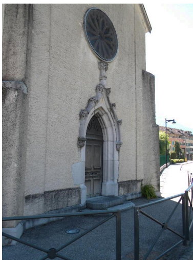
Vue de la façade principale. Phot. Jérôme Daviet IVR82_20147400055NUCA
