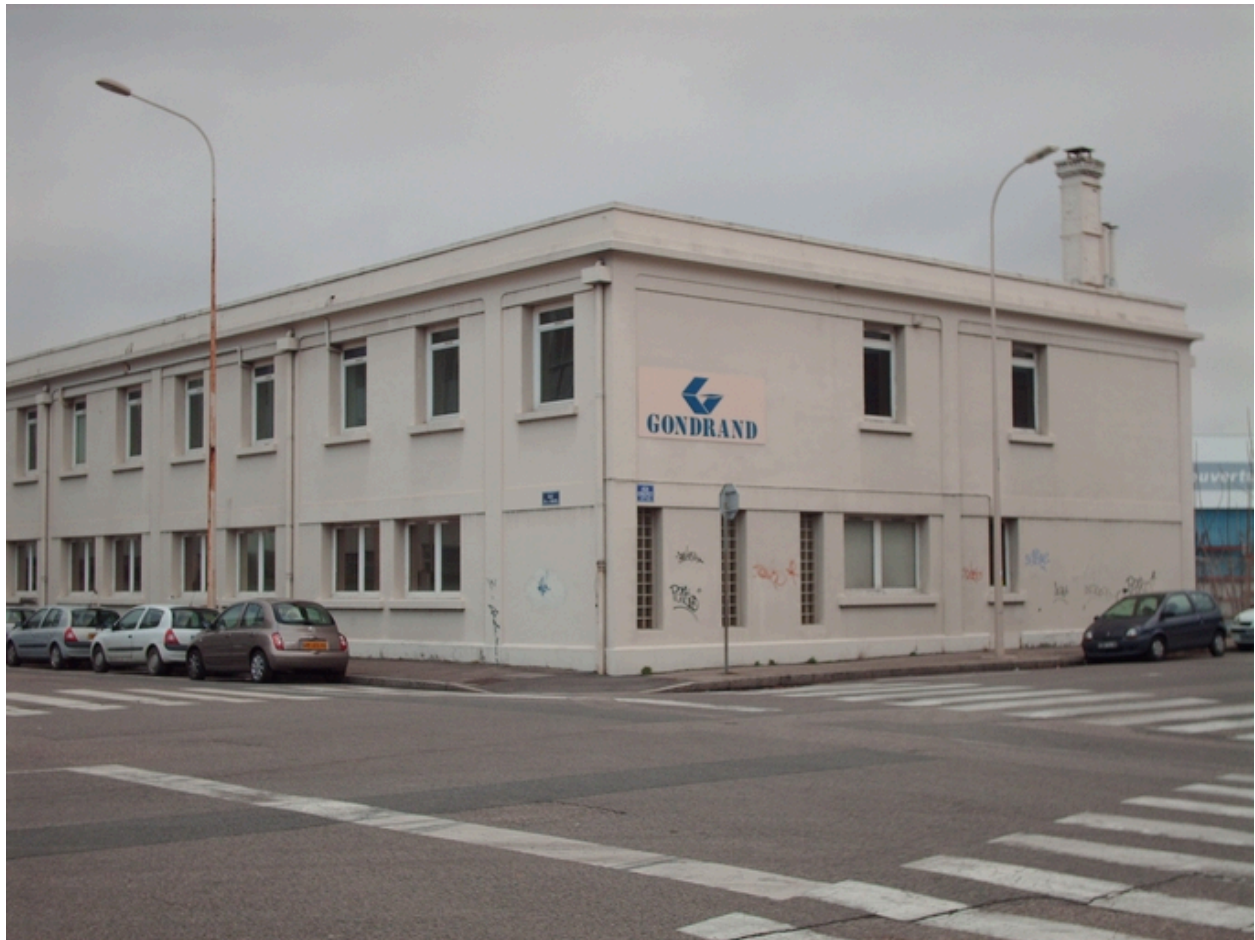
Bâtiment administratif de la sté Gondrant
