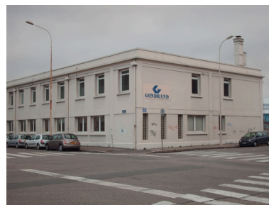
Bâtiment administratif de la sté Gondrant Phot. Géraldine Millo IVR82_20076901861NUCA
