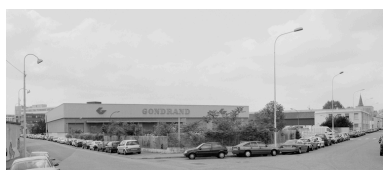
Vue d'ensemble sud-est du site Phot. Didier Gourbin IVR82_20066900085X
