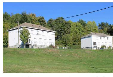
Neuvéglise-sur-Truyère - Fridefont, barrage de Grandval, deux maisons à deux logements de l'ancienne cité, n° 1 à 7 allée Marcel-Paul.
