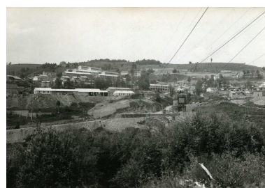
Neuvéglise-sur-Truyère - Fridefont, barrage de Grandval, les installations de chantier et la cité sur le flanc nord de la vallée, n. d., vers 1958 (Archives départementales du Cantal, Murat, photo Jack Andral, 2 Fi 1363). Phot. Christophe Laurent
