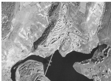
Neuvéglise-sur-Truyère - Fridefont, barrage de Grandval, photographie aérienne du site du barrage et de la cité, 10 septembre 1963 ; quelques baraquements ont déjà été démontés (IGNF, site remonterletemps.fr). Phot. Christophe Laurent IVR84_20211500005NUCA
