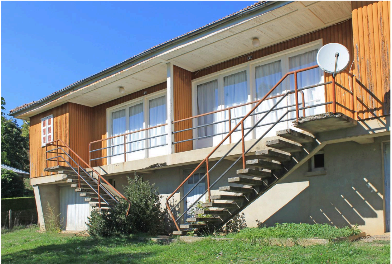
Neuvéglise-sur-Truyère - Fridefont, barrage de Grandval, maison à deux logements de l'ancienne cité, n° 2 rue des Frères Lumière, détail des escaliers convergents à une volée droite équipée de marches suspendues au limon.
