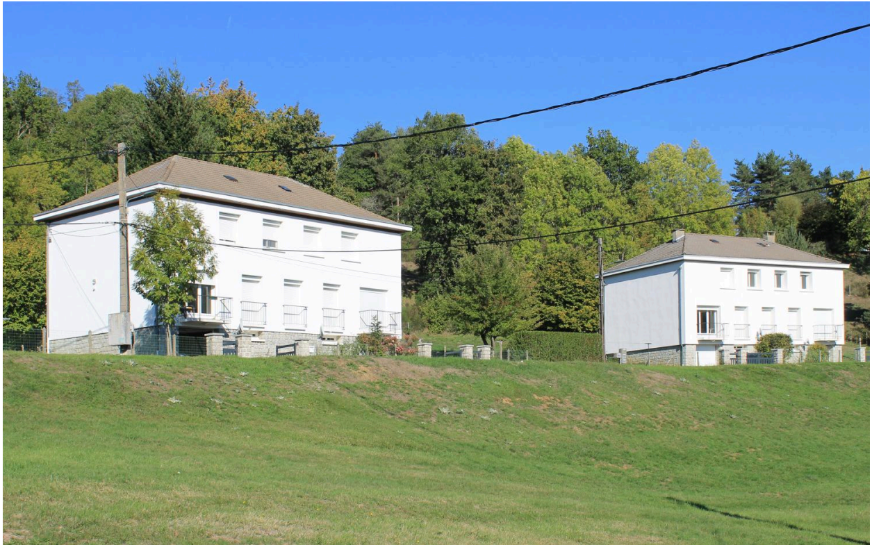
Neuvéglise-sur-Truyère - Fridefont, barrage de Grandval, deux maisons à deux logements de l'ancienne cité, n° 1 à 7 allée Marcel-Paul.
