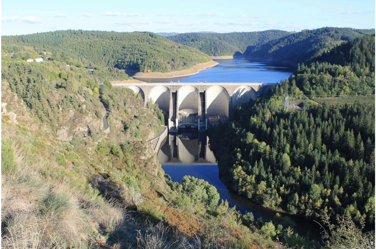
Neuvéglise-sur-Truyère - Fridefont, barrage de Grandval, vue générale depuis l'ouest du barrage et d'une partie de la retenue, avec à gauche quelques bâtiments de l'ancienne cité.
