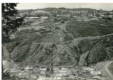
Neuvéglise-sur-Truyère - Fridefont, barrage de Grandval, vu du chantier depuis la rive gauche, n. d., vers 1957 (Archives départementales du Cantal, Murat, photo Jack Andral, 2 Fi 1364). Au fond de la vallée se trouvent les massifs en béton
