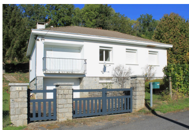
Neuvéglise-sur-Truyère - Fridefont, barrage de Grandval, maison
