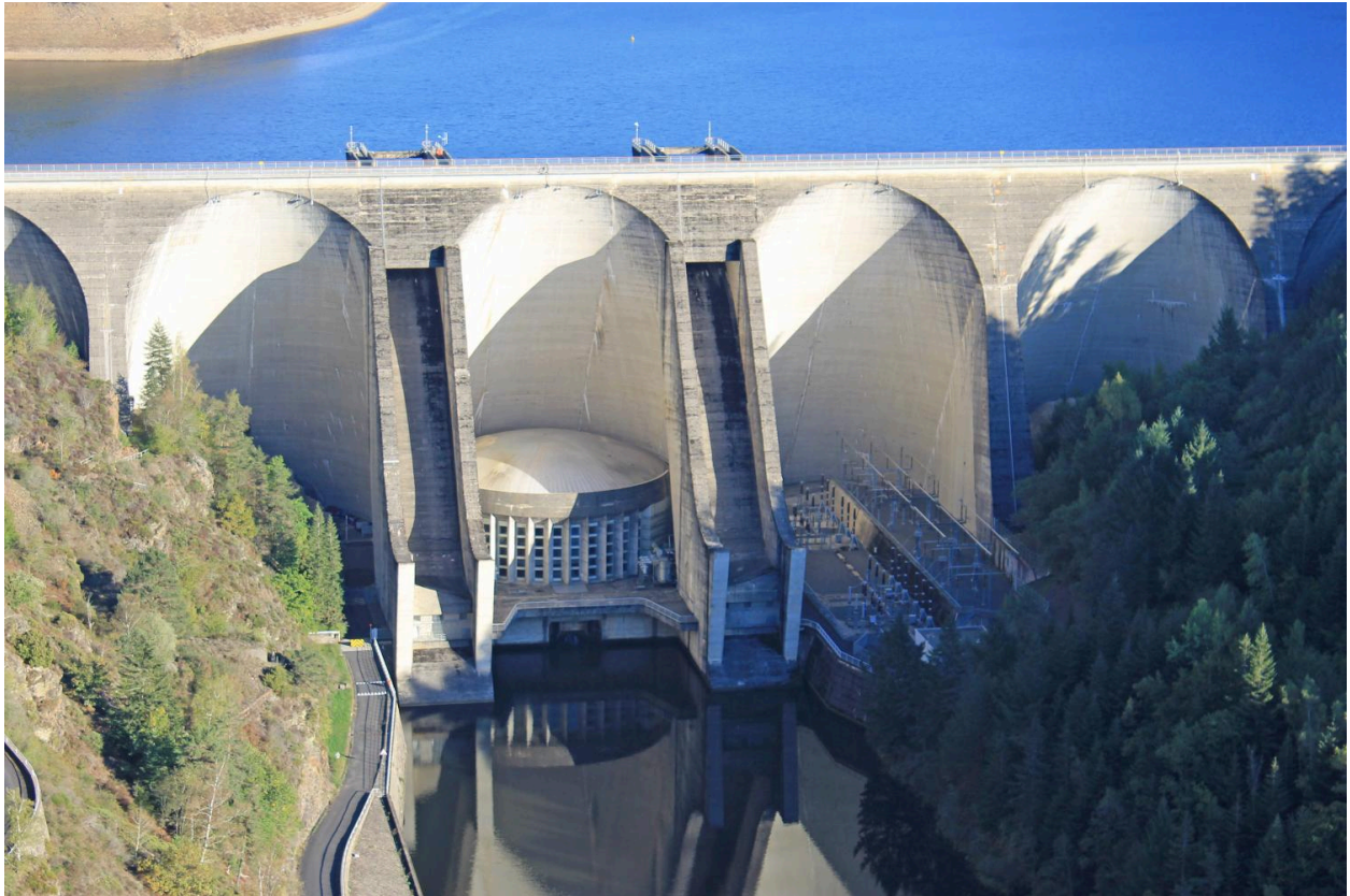
Neuvéglise-sur-Truyère - Fridefont, barrage de Grandval, vue depuis l'ouest de l'usine de plan circulaire logée dans l'une des voûtes du barrage, entre les deux déversoirs d'évacuation des crues (point de vue à proximité du hameau de Fauges).
