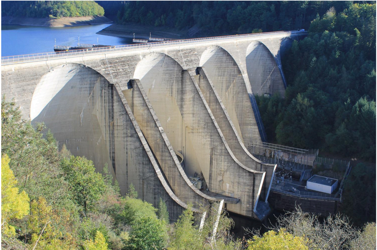
Neuvéglise-sur-Truyère - Fridefont, barrage de Grandval, photographie prise depuis le nord-ouest et montrant le profil en doucine des déversoirs d'évacuation des crues et leur extrémité inférieure en forme de « tremplin de saut à ski ».
