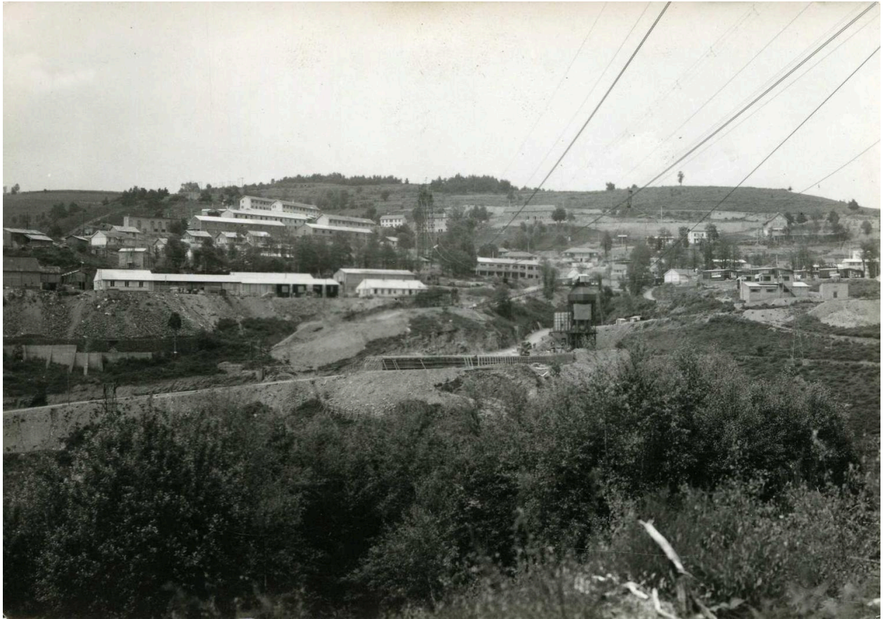
Neuvéglise-sur-Truyère - Fridefont, barrage de Grandval, les installations de chantier et la cité sur le flanc nord de la vallée, n. d, vers 1958 (Archives départementales du Cantal, Murat, photo Jack Andral, 2 Fi 1363).
