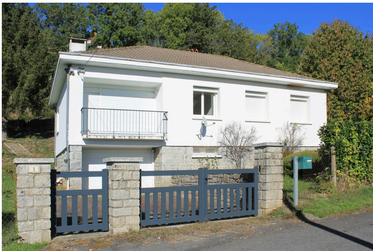
Neuvéglise-sur-Truyère - Fridefont, barrage de Grandval, maison individuelle de l'ancienne cité, n° 1 allée Kaplan.
