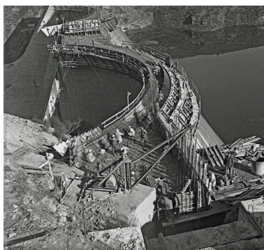
Neuvéglise-sur-Truyère - Fridefont, barrage de Grandval, travaux de ferrailage de l'une des voûtes vue depuis la rive gauche, n. d., vers 1959 (Archives départementales du Cantal, Famille Boyer de Chaudes-Aigues, collection Lionel Combes, 86 Fi 1361). Phot. Christophe Laurent IVR84_20211500008NUCA
