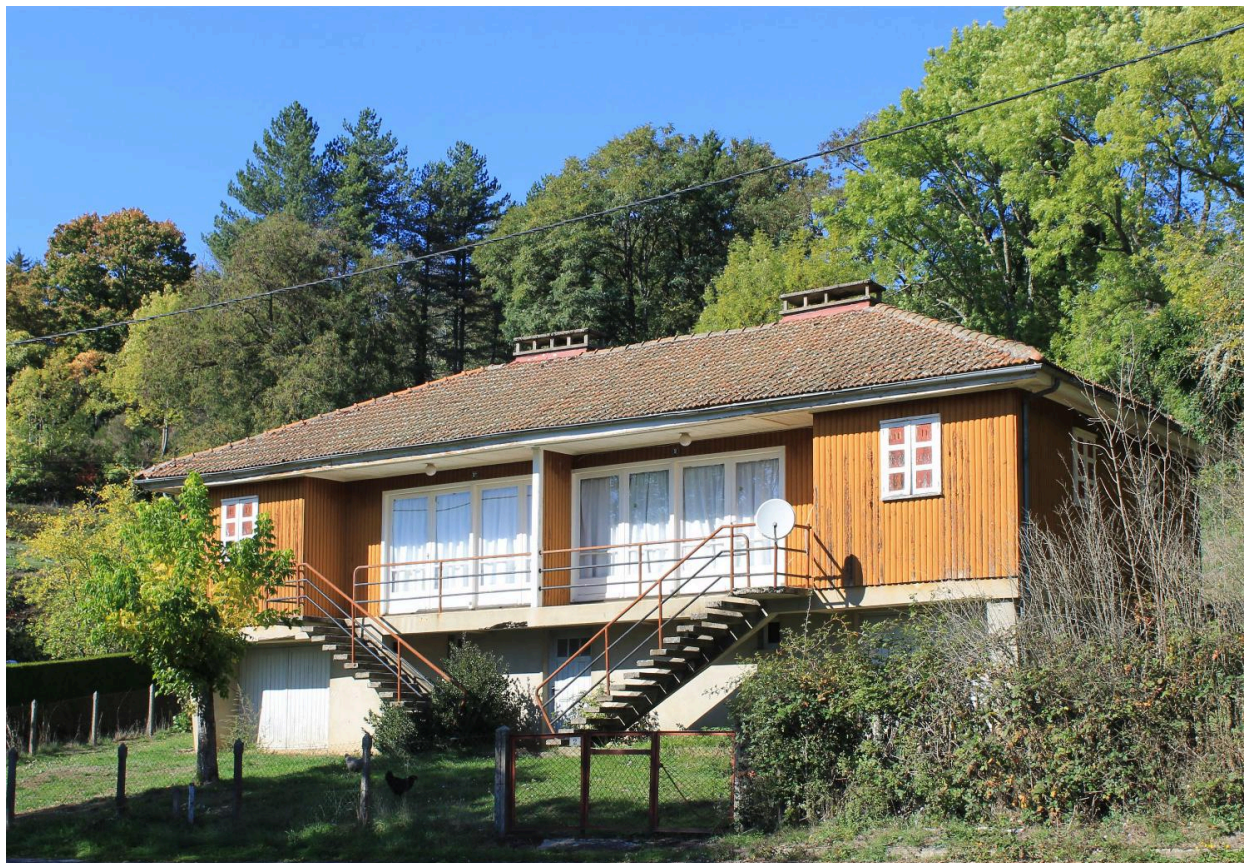
Neuvéglise-sur-Truyère - Fridefont, barrage de Grandval, maison à deux logements de l'ancienne cité, n° 2 rue des Frères Lumière.
