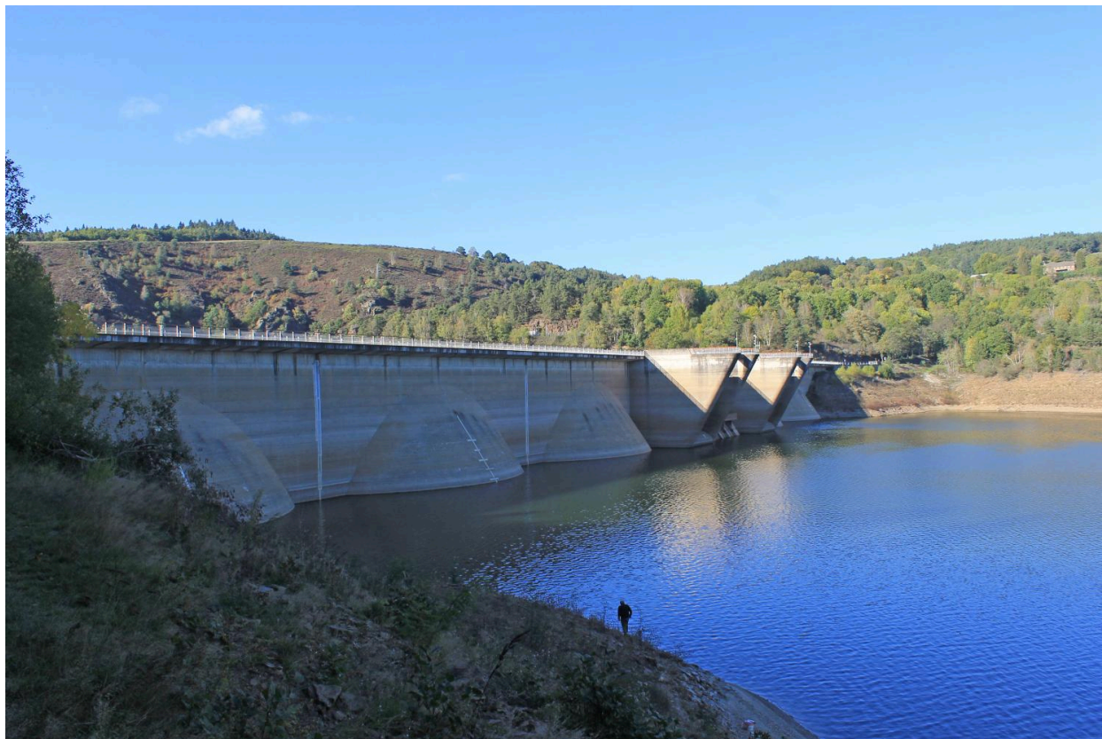
Neuvéglise-sur-Truyère - Fridefont, barrage de Grandval, vue de la partie supérieure de la face amont depuis la rive gauche.
