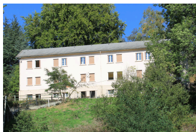
Neuvéglise-sur-Truyère - Fridefont, barrage de Grandval, l'un des deux bâtiments collectifs subsistants de la cité (parcelle AK 82, n° 2 domaine de la Batisse). Le bâtiment voisin abrite toujours l'ancienne salle de spectacles - cinéma de la cité (propriété privée).
