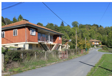
Neuvéglise-sur-Truyère - Fridefont, barrage de Grandval, maisons de l'ancienne cité abritant à l'origine deux logements, rue des Frères Lumière.
