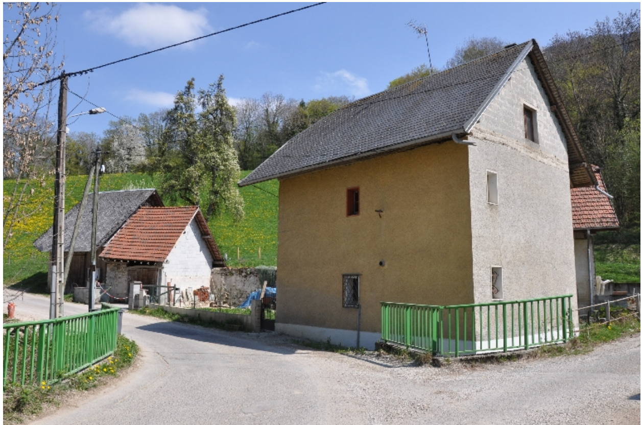
Vue du moulin aval, ouest
