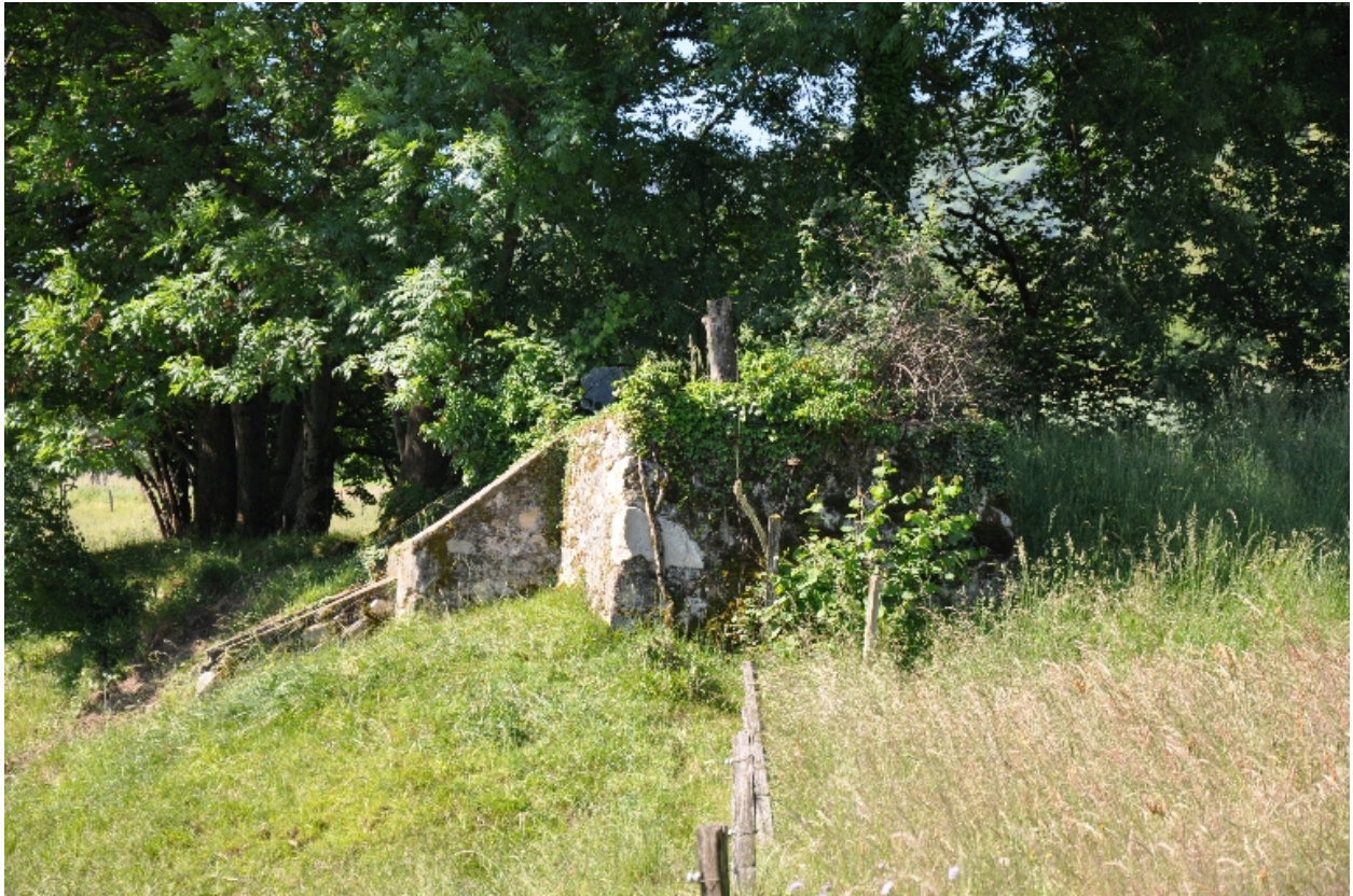
Element bâti de la réserve amont, seul vestiges des moulins Girod
