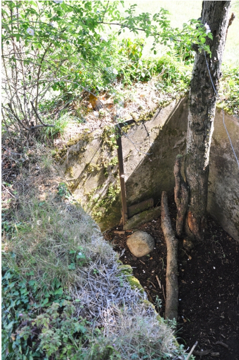
Détail de la réserve amont avec une vanne
