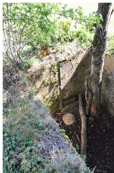
Détail de la réserve amont avec une vanne Phot. Yannick Milleret IVR82_20117302385NUCA
