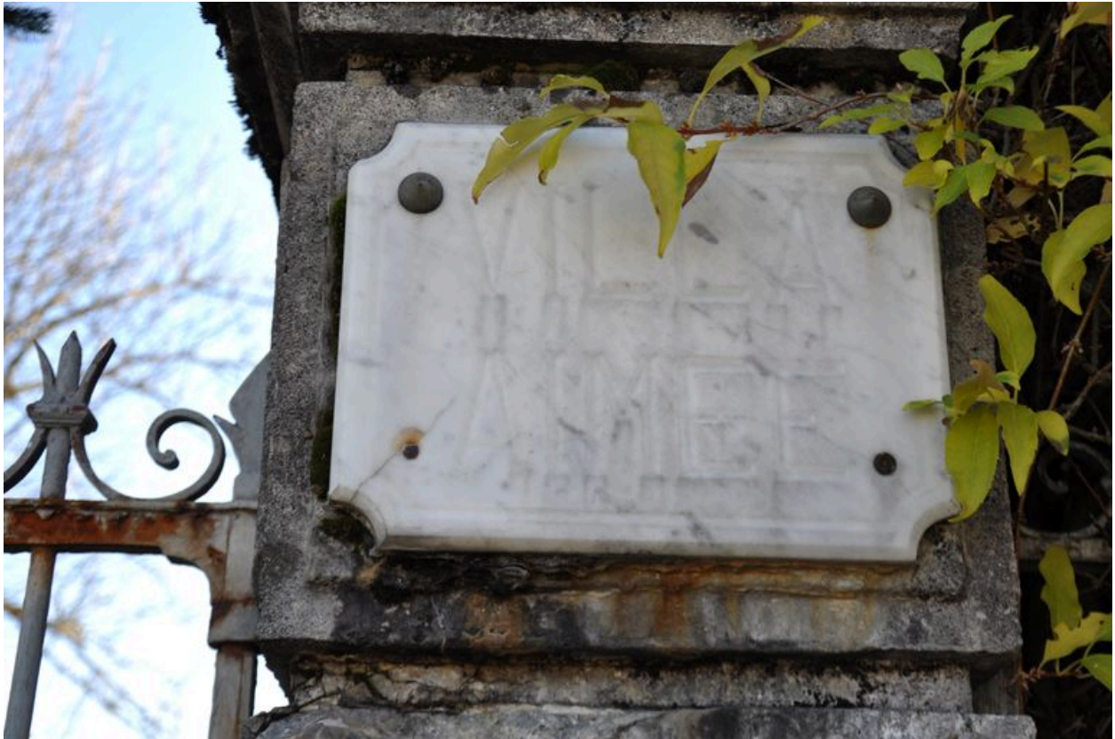
Détail de l'inscription porté au pilastre de l'entrée de la villa Aimée
