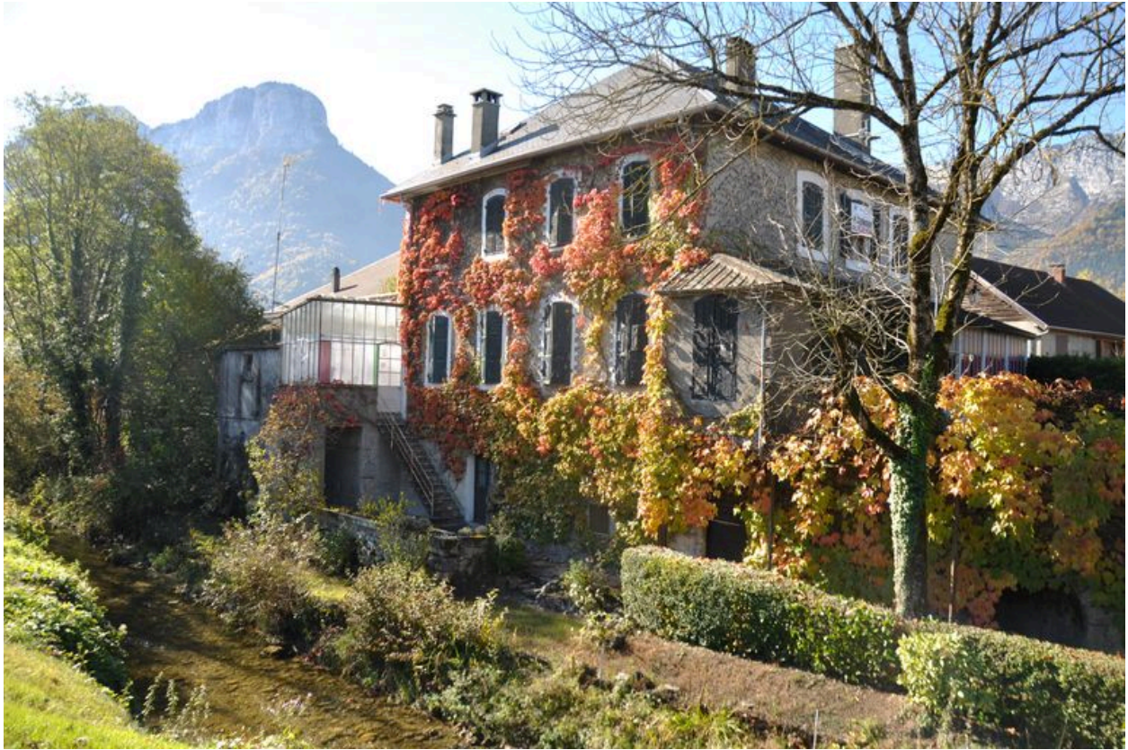
Bâtiment de l'ancien battoir devenu la villa Aimée
