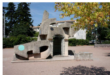
Vue de face Phot. Etudiants de l'Ecole Saint-Luc, Liège IVR84_20252600457NUCA
