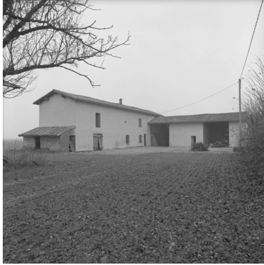
Vue d'ensemble élévation sur cour.
