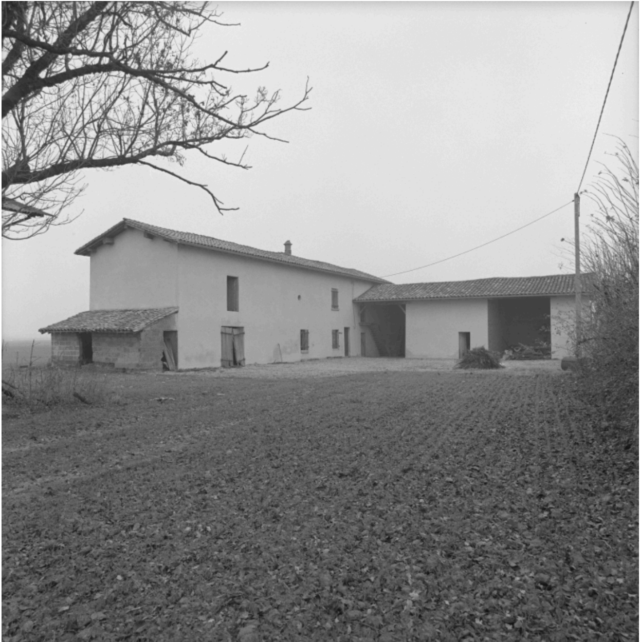
Vue d'ensemble élévation sur cour.
