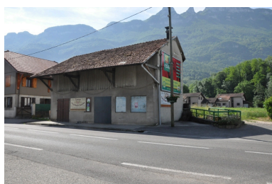
Vue générale nord Phot. Yannick Milleret IVR82_20107300856NUCA
