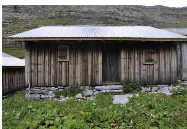
Vue de la façade antérieure est Phot. Samir Mahfoudi
