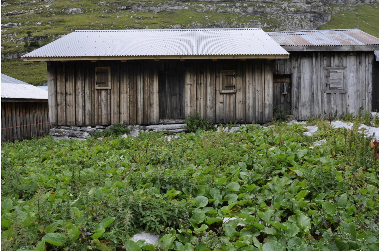
Vue d'ensemble du bâtiment
