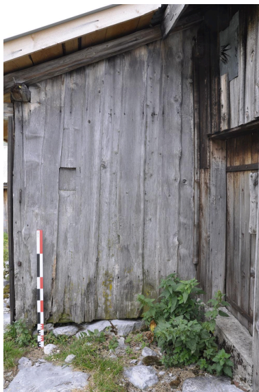
Détail d'une partie du bardage du mur pignon nord Phot. Samir Mahfoudi IVR84_20227402405NUCA
