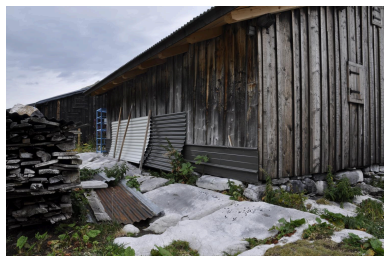
Vue de la façade postérieure ouest Phot. Samir Mahfoudi IVR84_20227402404NUCA
