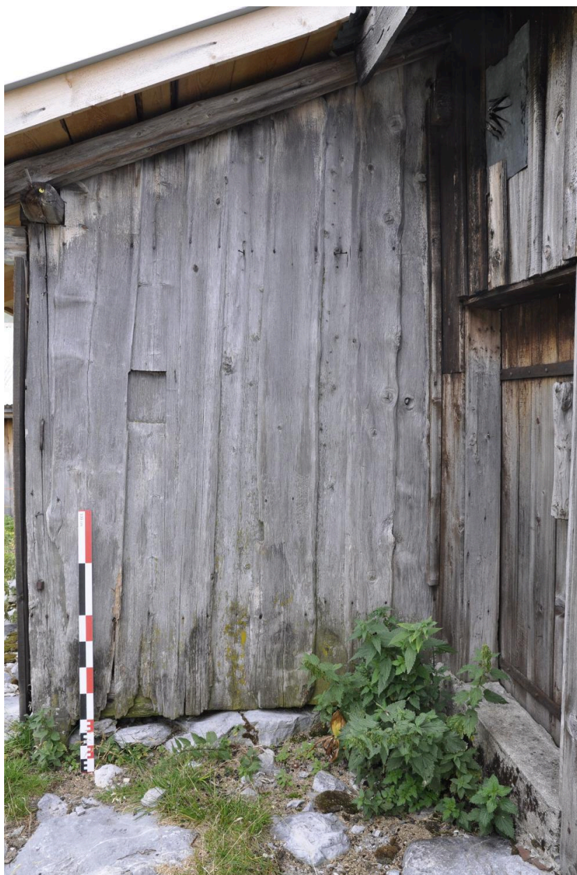
Détail d'une partie du bardage du mur pignon nord
