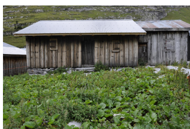
Vue d'ensemble du bâtiment Phot. Samir Mahfoudi
