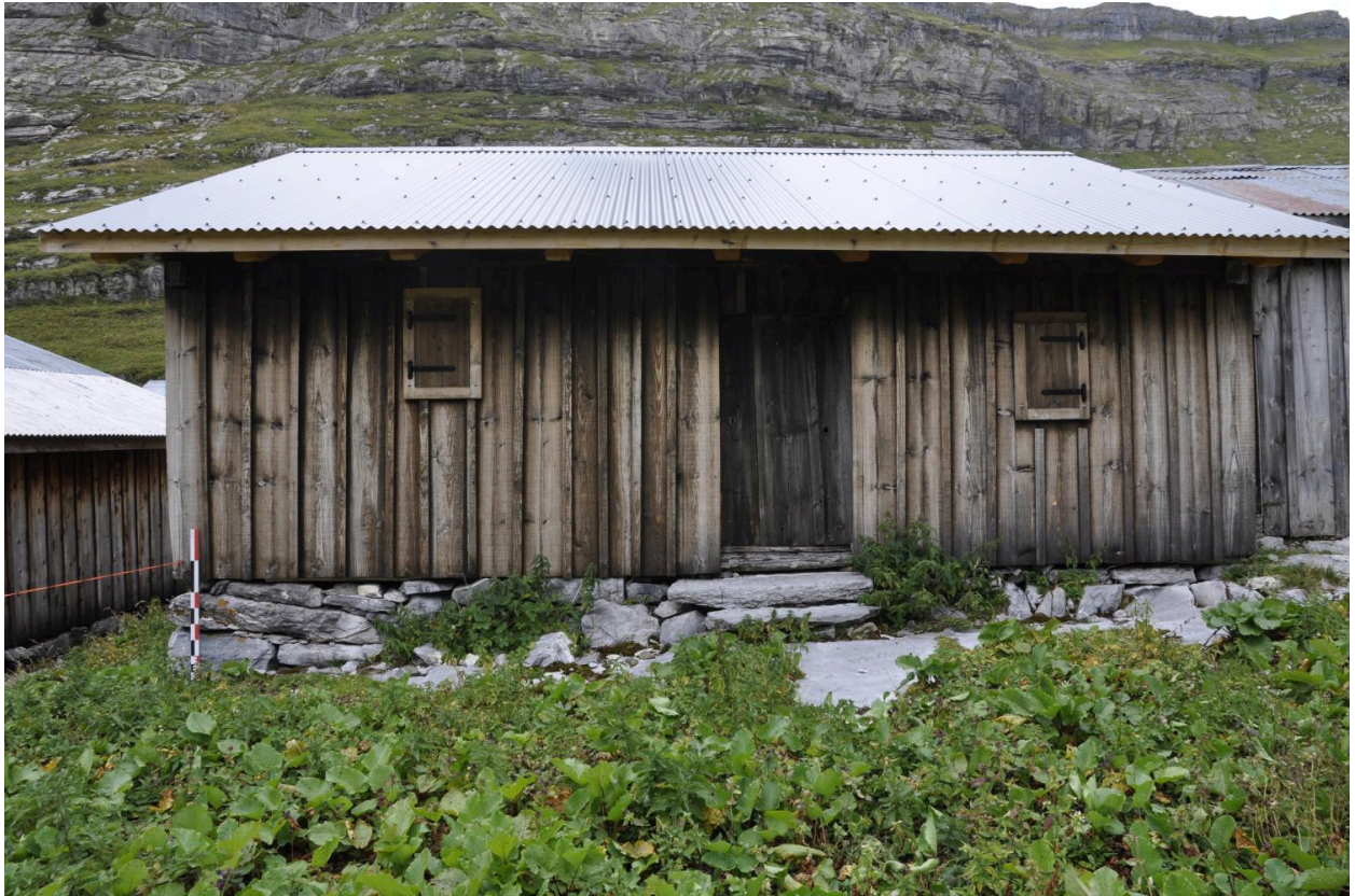
Vue de la façade antérieure est
