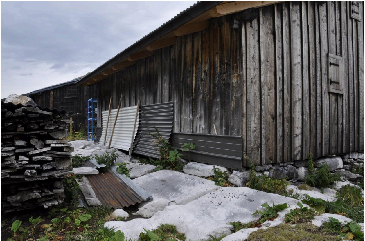
Vue de la façade postérieure ouest
