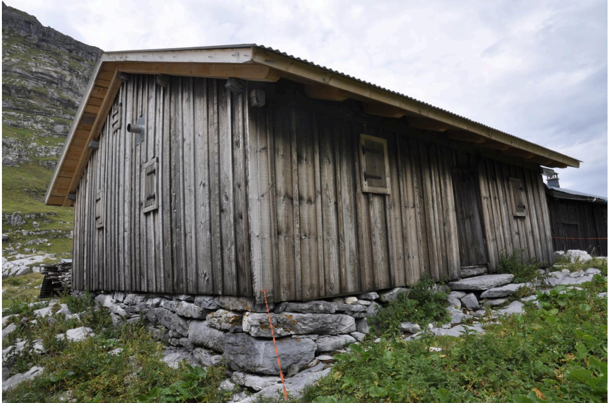
Vue de l'élévation sud-est
