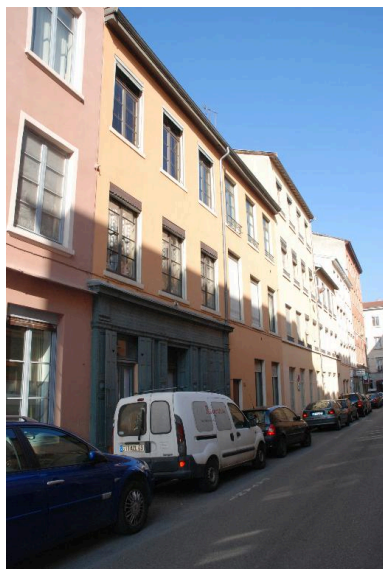
Vue d'ensemble sud est Phot. Nadine Halitim-Dubois IVR82_20146900134NUCA
