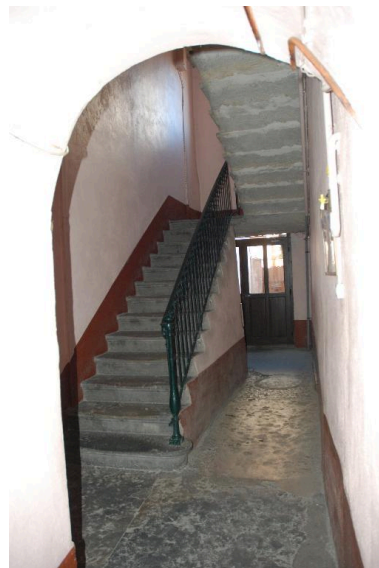
Vue du départ de l'escalier Phot. Nadine Halitim-Dubois IVR82_20146900139NUCA
