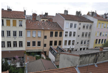
Vue ouest de l'immeuble de deux étages Phot. Nadine Halitim-Dubois IVR82_20146900262NUCA
