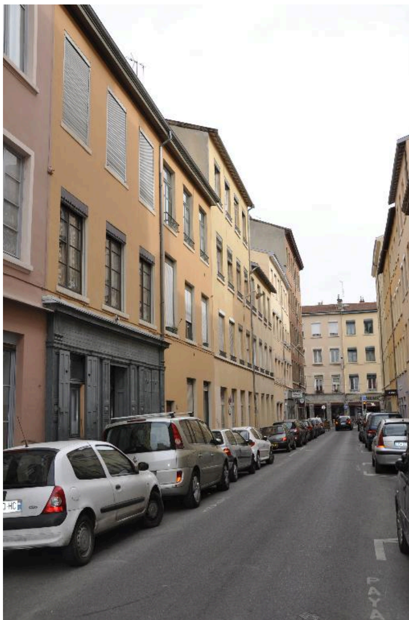
Vue d'ensemble sud est de l'immeuble de deux étages
