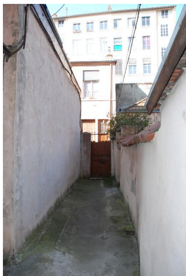
Vue de l'allée extérieure Phot. Nadine Halitim-Dubois IVR82_20146900140NUCA
