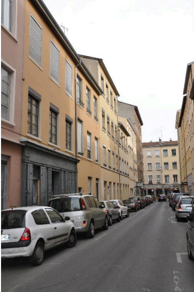
Vue d'ensemble sud est de l'immeuble de deux étages Phot. Nadine Halitim-Dubois IVR82_20146900557NUCA
