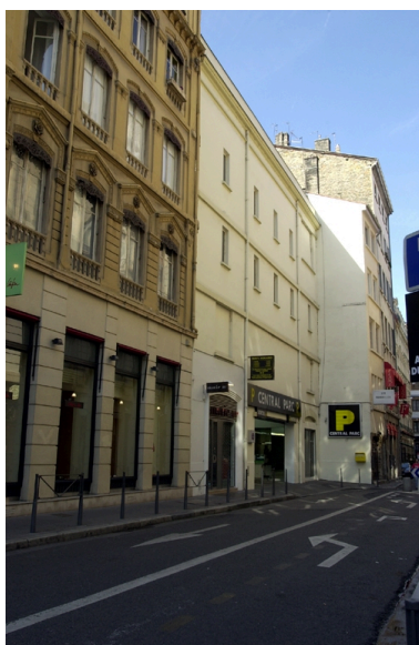
Vue générale nord-est Phot. Véronique Belle IVR82_20046905299NUCA
