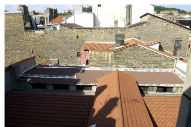
Vue zénithale nord Phot. Nadine Halitim-Dubois IVR82_20046905313NUCA
