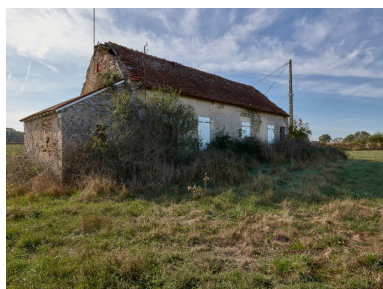
Vue générale de la façade principale orientée au nord. Phot. Christian Parisey IVR84_20230300405NUC4A
