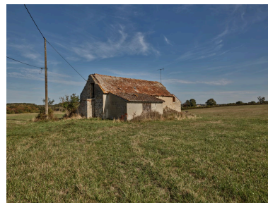
Vue générale au sud. Phot. Christian Parisey IVR84_20230300404NUC4A
