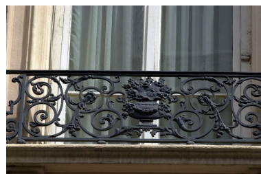
Façade, 3e niveau, détail du garde-corps de la 3e fenêtre Phot. Bernard Ducouret IVR82_20046900865NUCA
