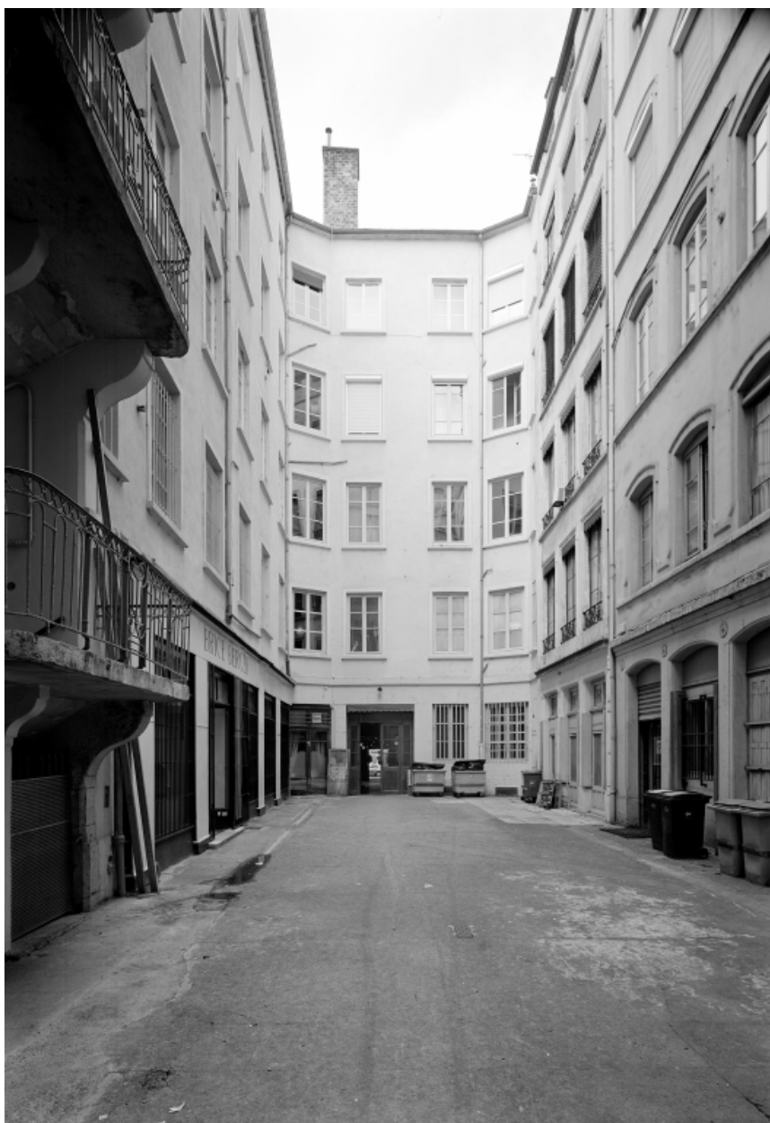
Vue générale de la 2e cour vers le nord
