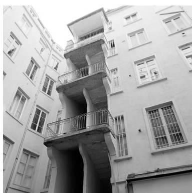
2e cour, partie supérieure de l'escalier Phot. Didier Gourbin IVR82_20046905898X
