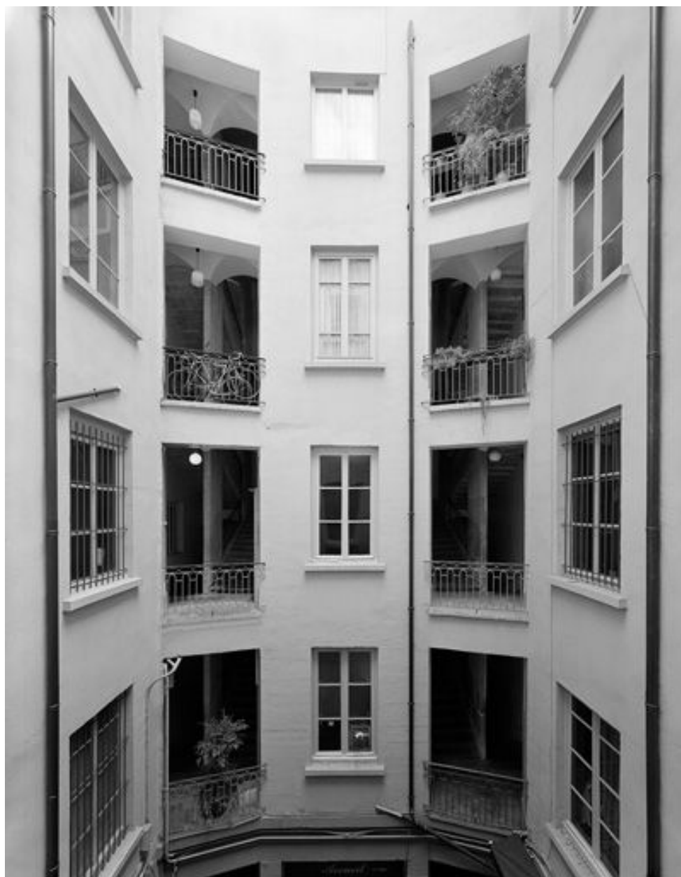
1ère cour, élévation du bâtiment en fond de cour, niveaux 2 à 5
