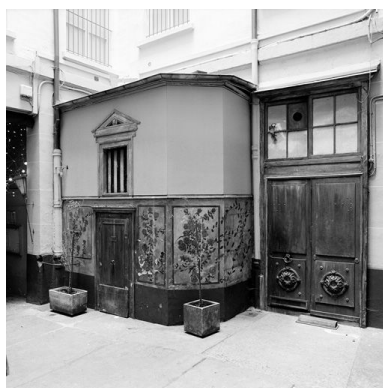
1ère cour, loge de concierge Phot. Didier Gourbin IVR82_20046905900X
