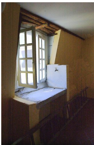
Corps de bâtiment à droite de la 1ère cour, évier dans le couloir du 5e étage Phot. Lore Derail IVR82_20046900234NUCA
