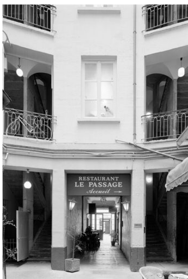
Bâtiment au fond de la 1ère cour, élévation des premiers niveaux Phot. Didier Gourbin IVR82_20046905896P
