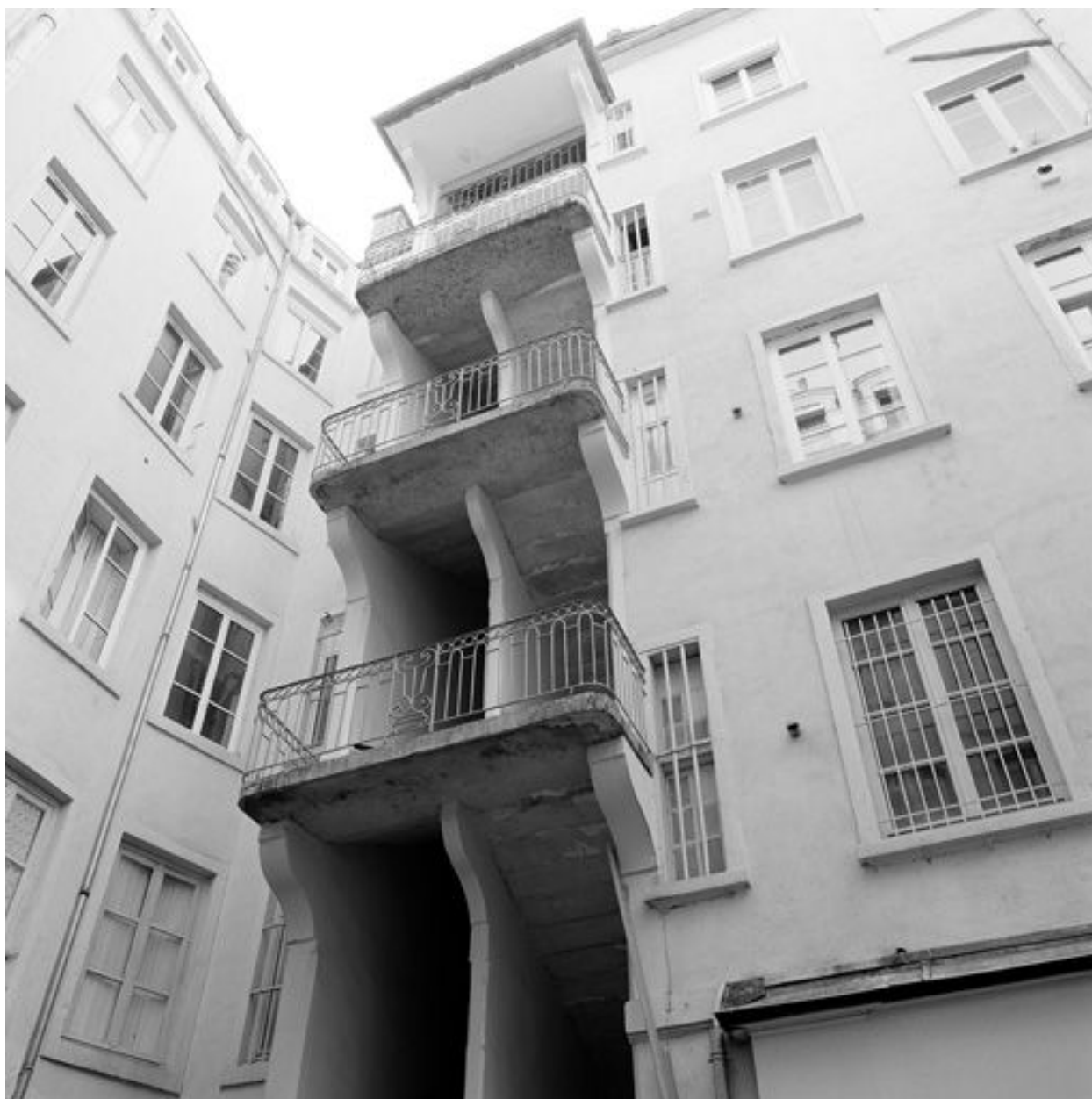
2e cour, partie supérieure de l'escalier
