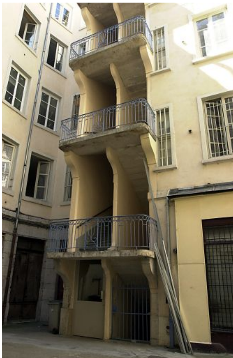
2e cour, partie inférieure de l'escalier
