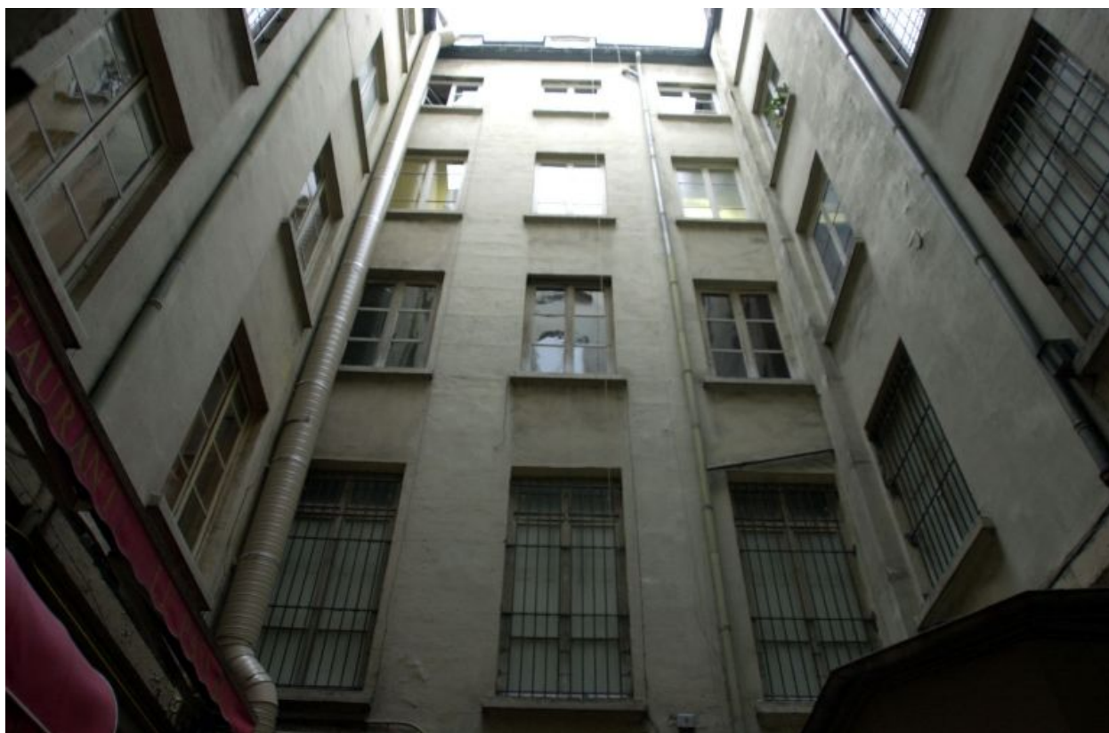
Bâtiment sur la rue du Plâtre, façade sur cour
