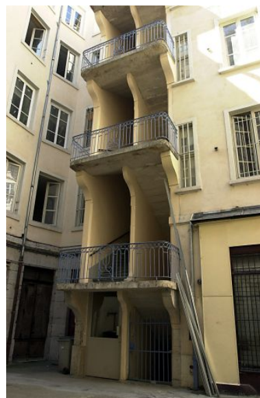
2e cour, partie inférieure de l'escalier Phot. Lore Derail IVR82_20046900235NUCA
