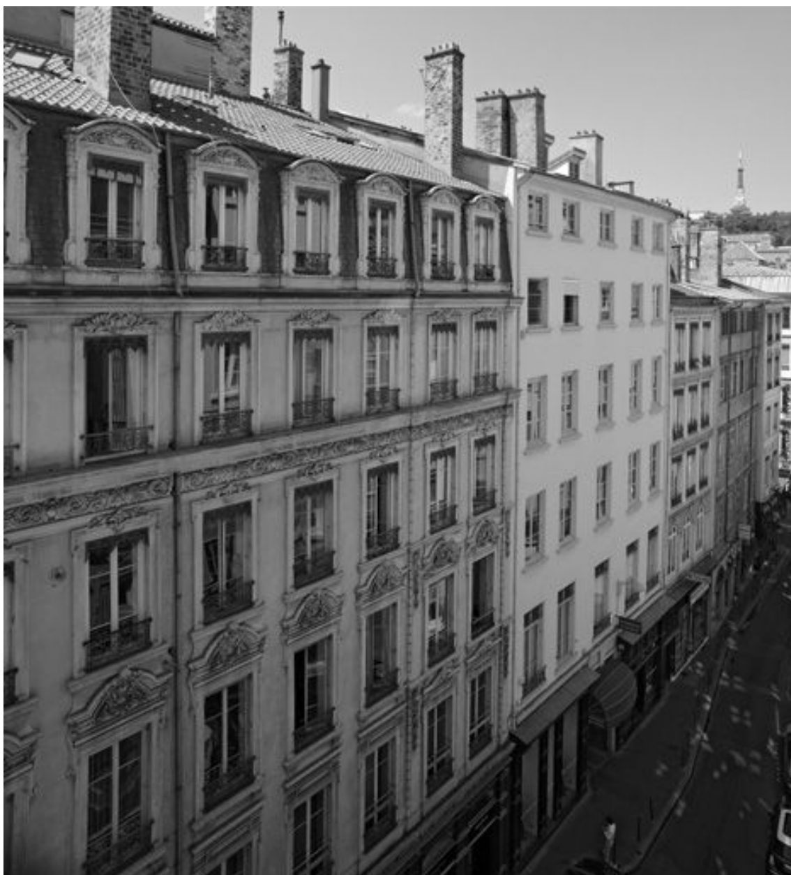
Façade sur la rue du Plâtre, vue générale
