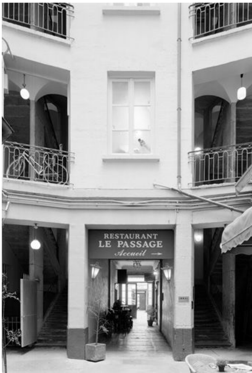
Bâtiment au fond de la 1ère cour, élévation des premiers niveaux
