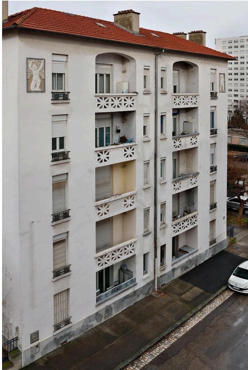
Vue de situation des bas-reliefs rue de l'Effort
