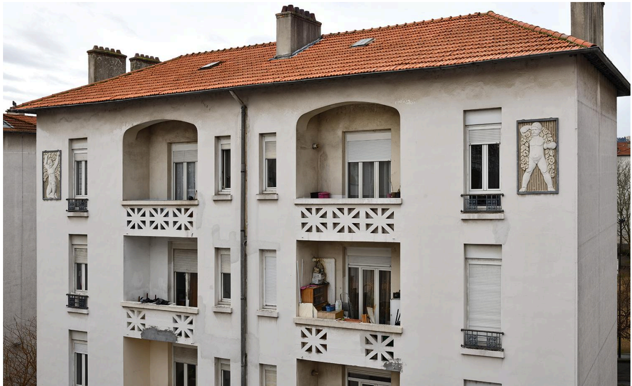
Vue de situation des bas-reliefs rue de l'Effort
