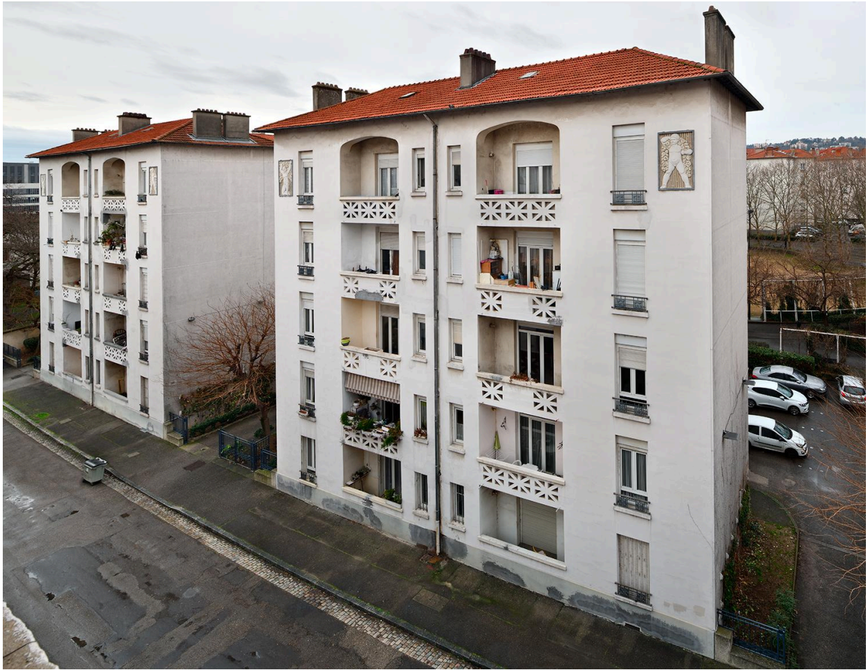
Vue de situation des bas-reliefs de la rue de l'Effort
