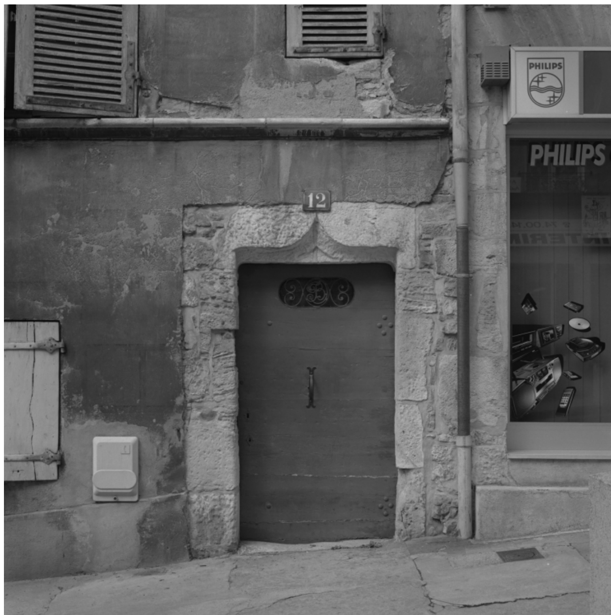
Porte d'entrée sur la rue du Port, avec jour percé dans le vantail et orné d'un monogramme en ferronnerie.
