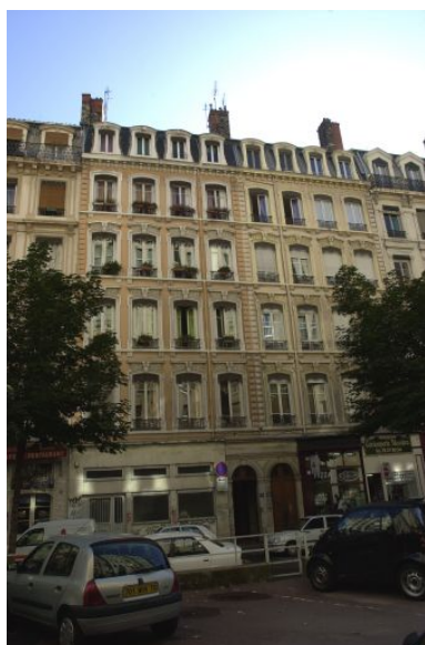
Façades des immeubles 11 et 13, rue Mercière, vue générale Phot. Bernard Ducouret IVR82_20046900980NUCA
