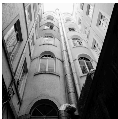
Vues générale des élévations sur cour Phot. Didier Gourbin IVR82_20056902649X
