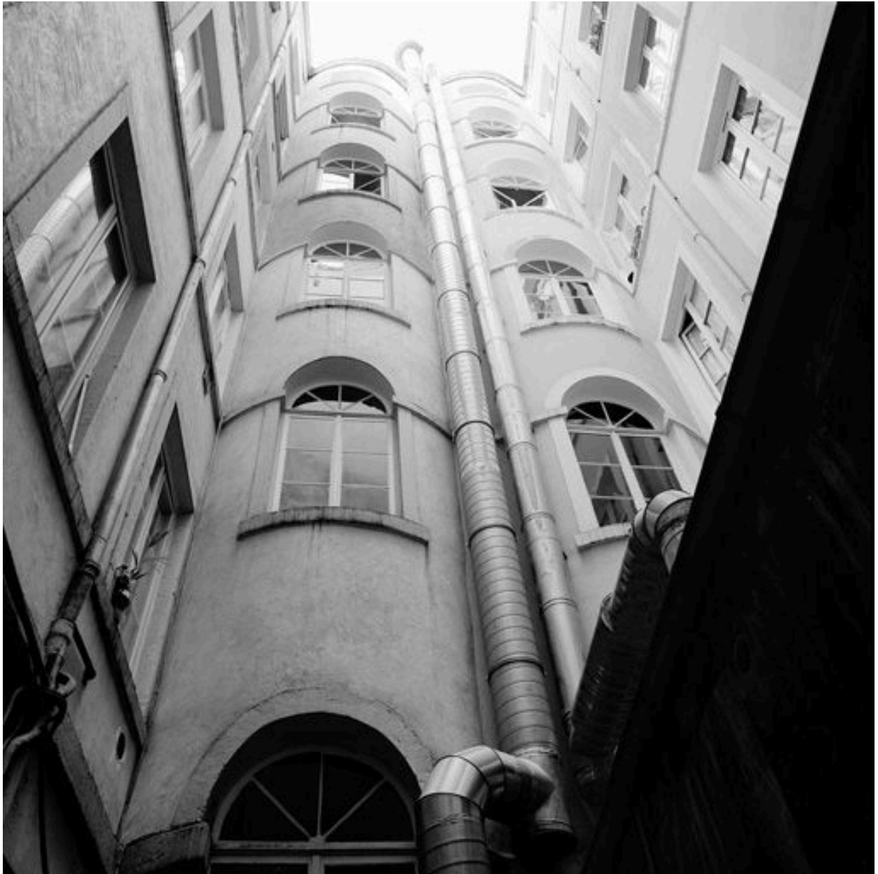
Vues générale des élévations sur cour
