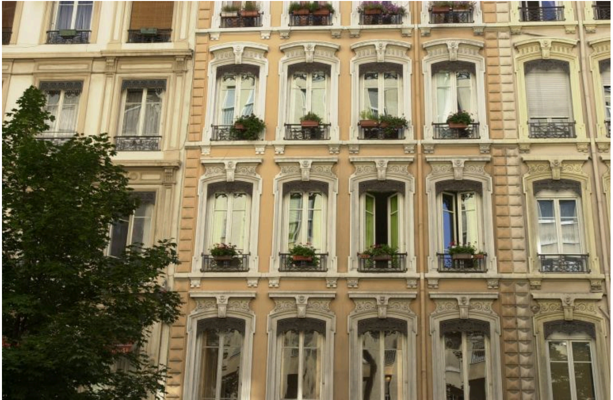
Façade, niveaux 2 à 4
