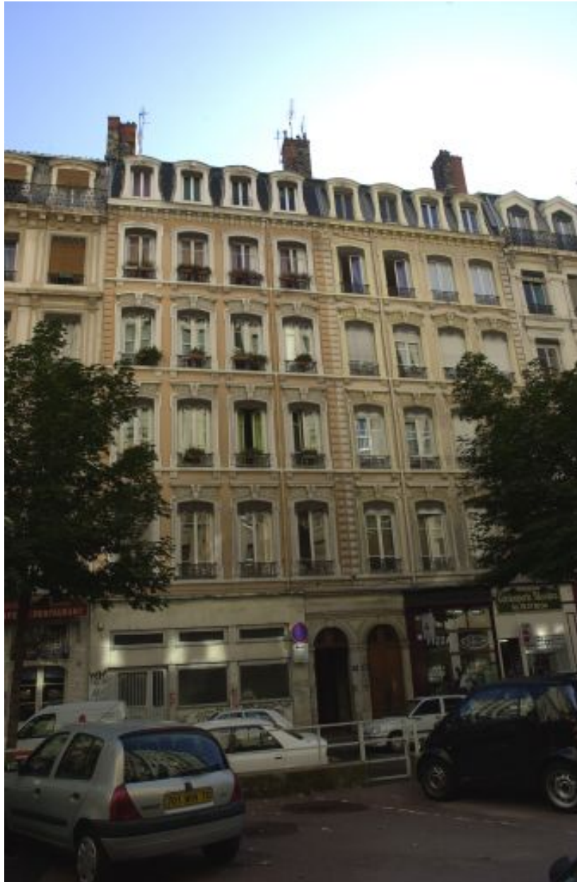
Façades des immeubles 11 et 13, rue Mercière, vue générale
