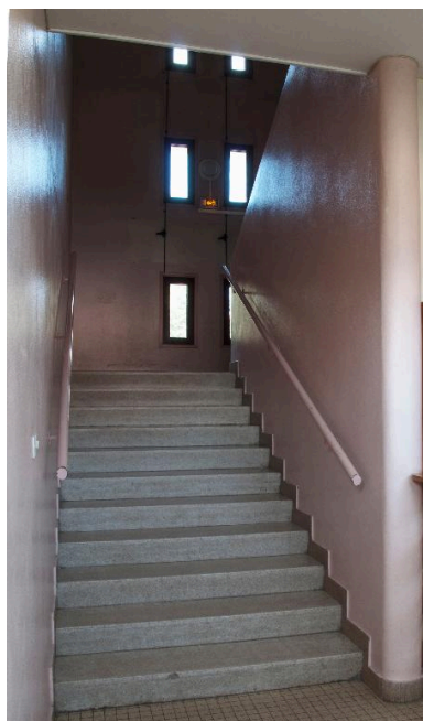
Escalier intérieur Phot. Denys Harreau IVR82_20147301250NUCA
