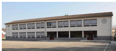
Vue d'ensemble Phot. Denys Harreau IVR82_20147301249NUCA
