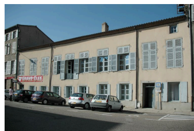
Maison 37 occupée par le doyen Jean-Guy du Bessey de Contenson, trente-huitième et dernier doyen du chapitre, d'après le bref de vente de 1791. Phot. Simone Hartmann-Nussbaum IVR82_20114201307NUCA
