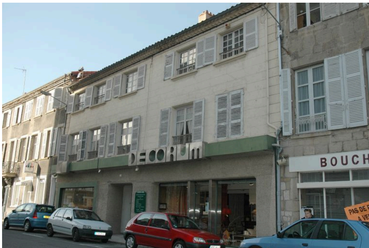
Maison 39 occupée par le chanoine Dussieu, prêtre constitutionnel, d'après le bref de vente de 1791.
