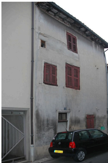
Maison 19 du chanoine Jean- Marie de la Mure, occupée par le chanoine Barthélémy Audelin, prêtre constitutionnel, d'après le bref de vente de 1791. Phot. Simone Hartmann-Nussbaum IVR82_20114202303NUCA
