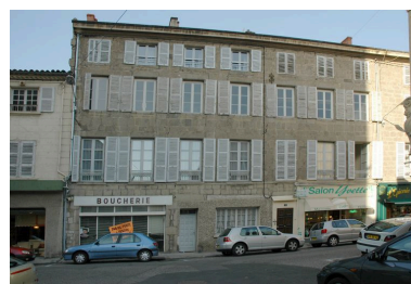
Maisons 40 et 41 occupée au 16e siècle par le chanoine Pierre Paporin. Au 19e siècle le prêtre Pierre Gay fait modifier l'élévation. La maison conserve un escalier en vis du 16e siècle. Phot. Simone Hartmann-Nussbaum IVR82_20114201323NUCA
